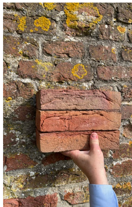
Nieuwe, speciaal hiervoor gebakken bakstenen. Welke kleurt het beste bij de oude?
