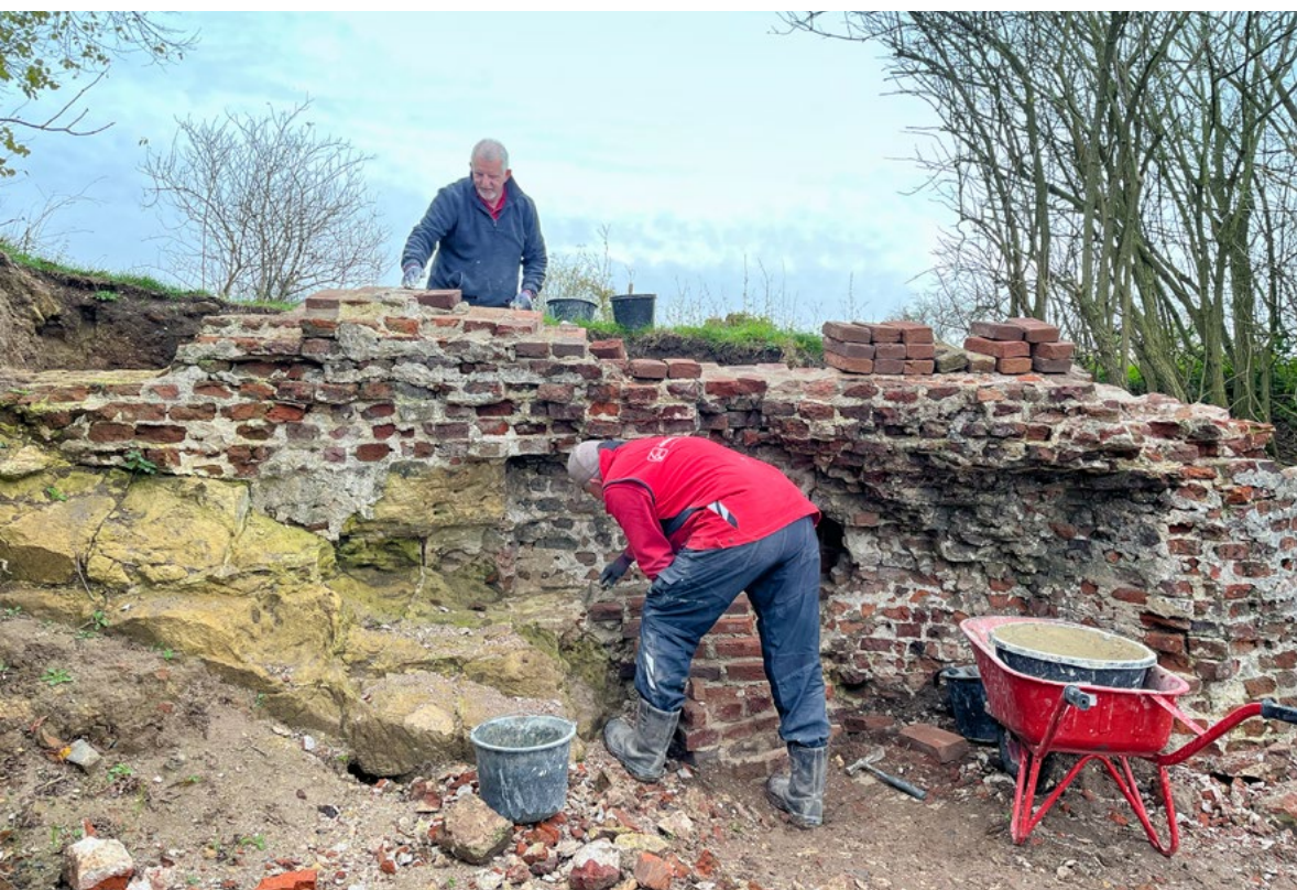
Metselaars zetten alle losse bakstenen weer vast en vullen de voegen aan
