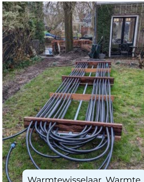
Aan- en toevoer tussen bron en warmtepomp, Warmte uit de Vecht
