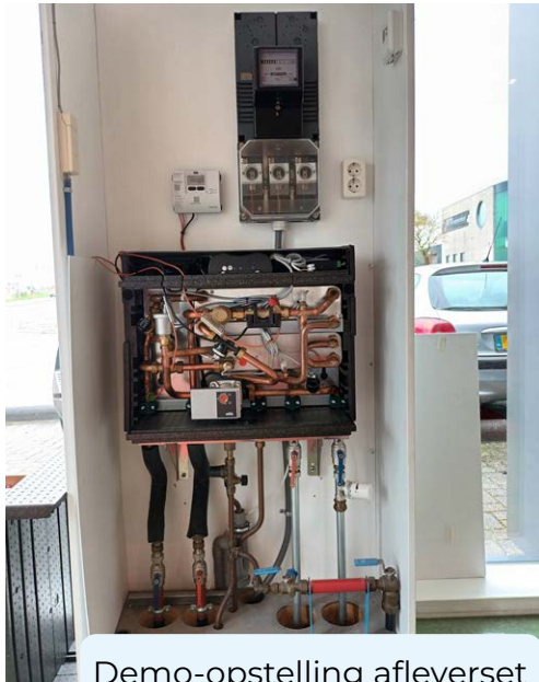
Demo-opstelling afleverzet in meterkast
