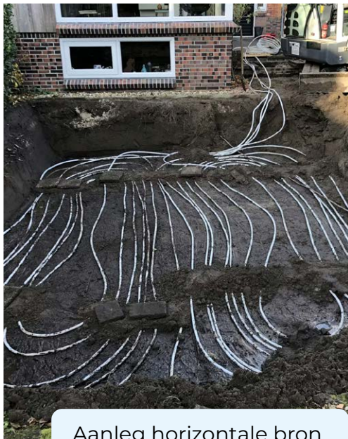
Aanleg horizontale bron, Vakblad Warmtepomp
