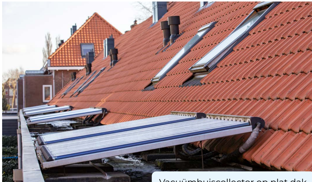
Vacuümbuiscollector op plat dak van uitbouw
