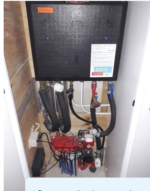
Afleverzet in de meterkast
