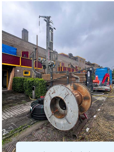
Aanleg verticale bron
