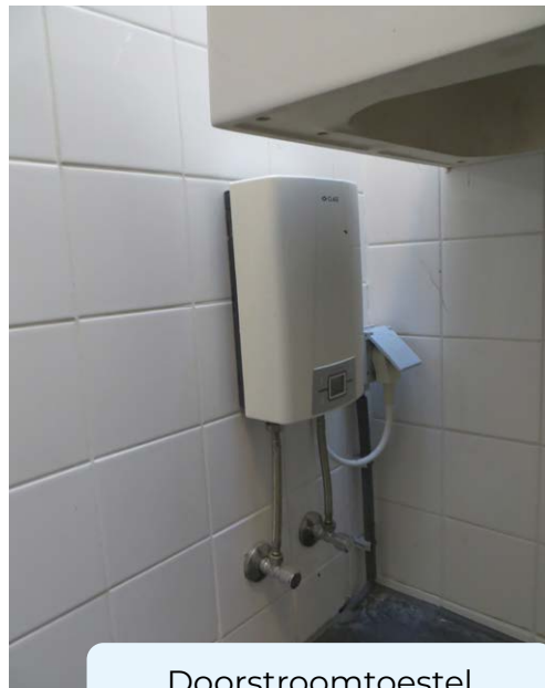
Doorstroomtoestel onder wasbak
