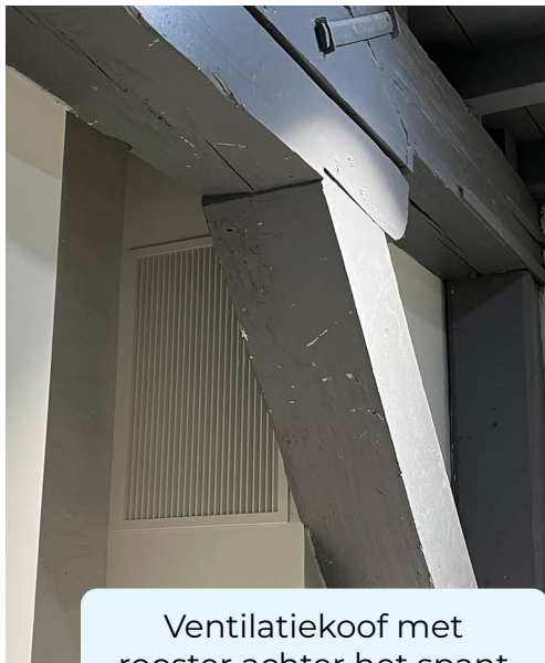
Geperforeerd ventilatierooster in een hoek gepositioneerd
