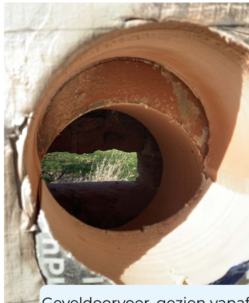
Geveldoorvoer, gezien vanaf de binnenzijde
