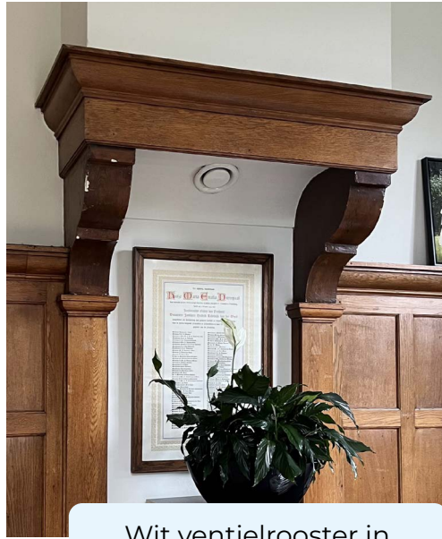
Wit ventielrooster midden in de schouwlijst
