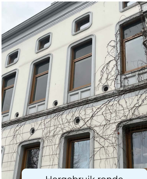
Hergebruik ronde geveluitsparingen
