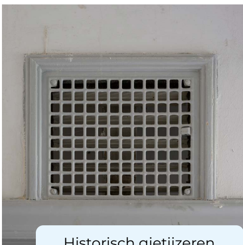
Historisch gietijzeren ventilatierooster
