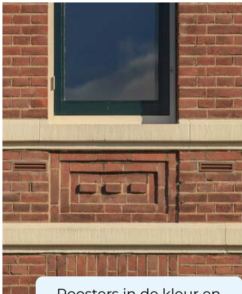
Roosters in de kleur en vorm van baksteen
