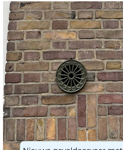
Nieuwe geveldoorvoer met modern gietijzeren rozet
