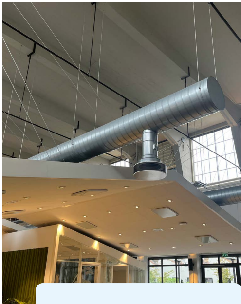
Kanaalwerk in het zicht
