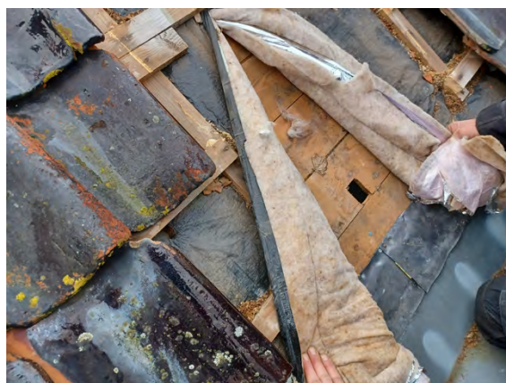
Figuur 8 Aanzicht opengemaakte constructie aan de west-noordwestzijde
