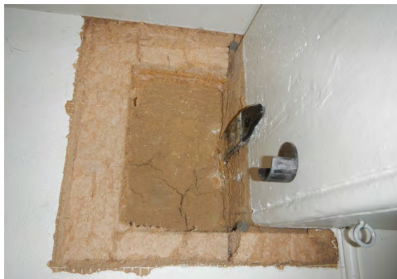
Figuur 46 Aanzicht opengemaakte constructie.
