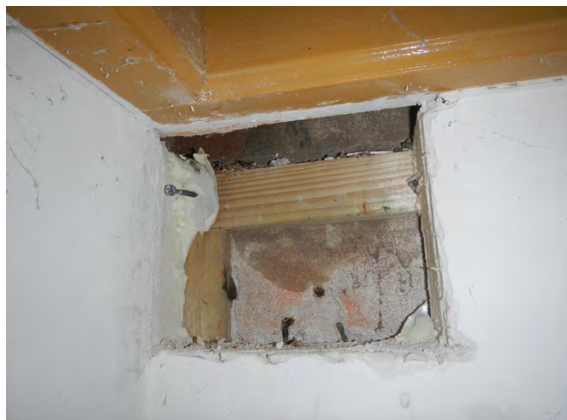
Figuur 34 Aanzicht opengemaakte constructie.
