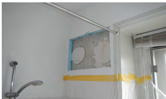
Figuur 13 Aanzicht opengemaakte constructie
