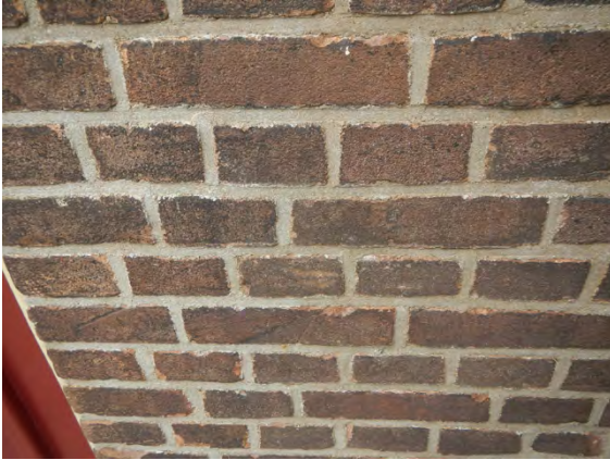
Figuur 41 Aanzicht van de gevel aan de buitenzijde.
