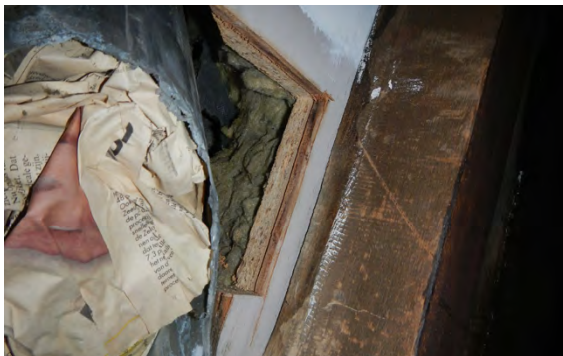
Figuur 11 Aanzicht opengemaakte constructie
