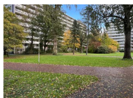
Flats ingebed met clusters van beplanting.
