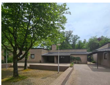
Verdiept vlak met muurtjes in een van de hofjes. Foto's van SteenhuisMeurs.
