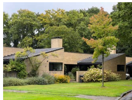
Patiowoningen in het noordelijke deel.
