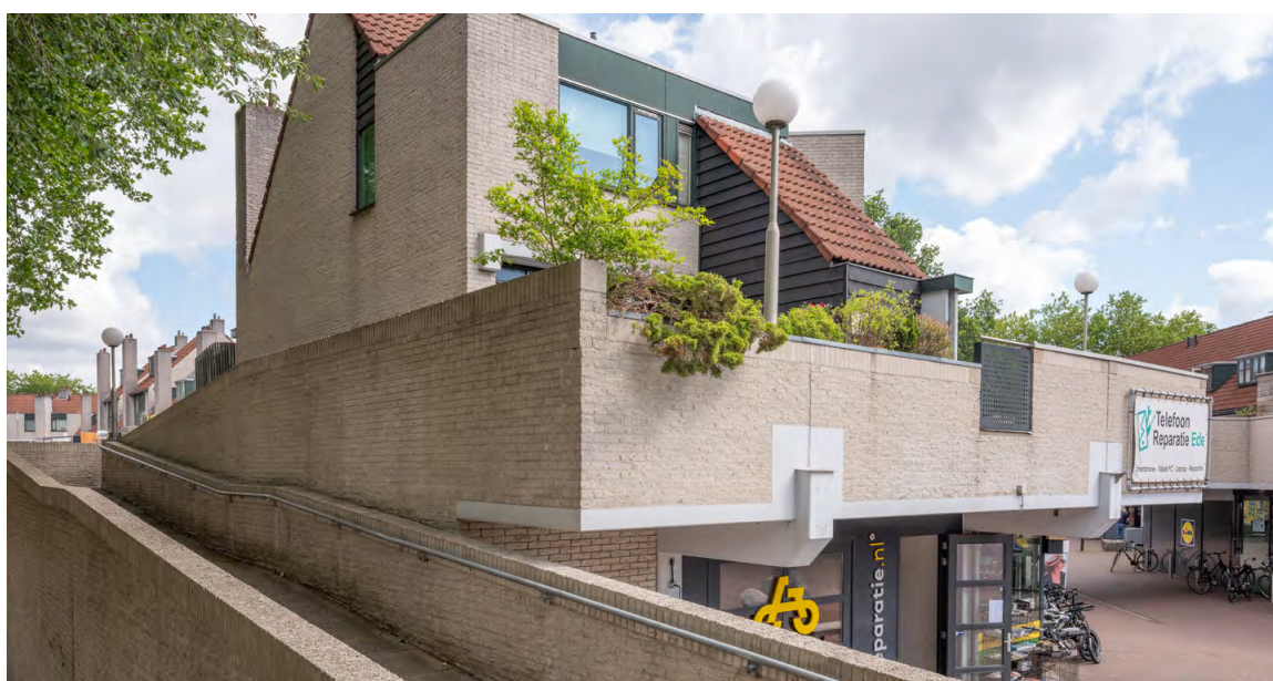
Hellingbaan naar woonstraat op eerste verdieping (westzijde)
