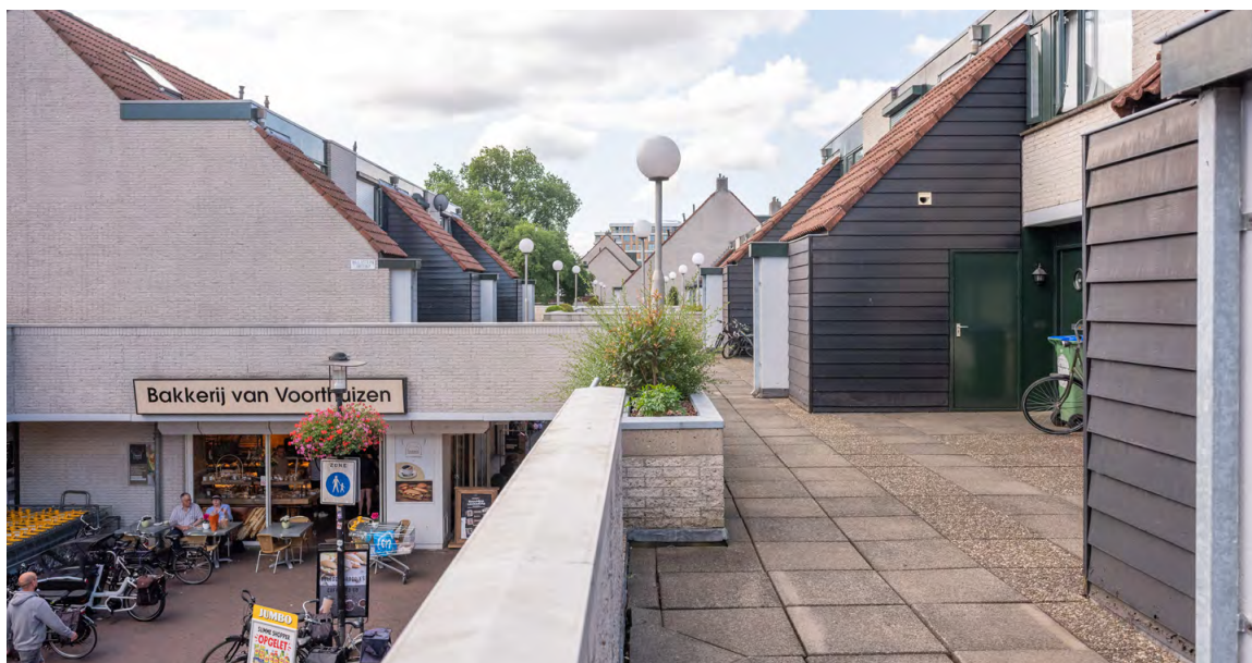
Woonstraat op eerste verdieping
