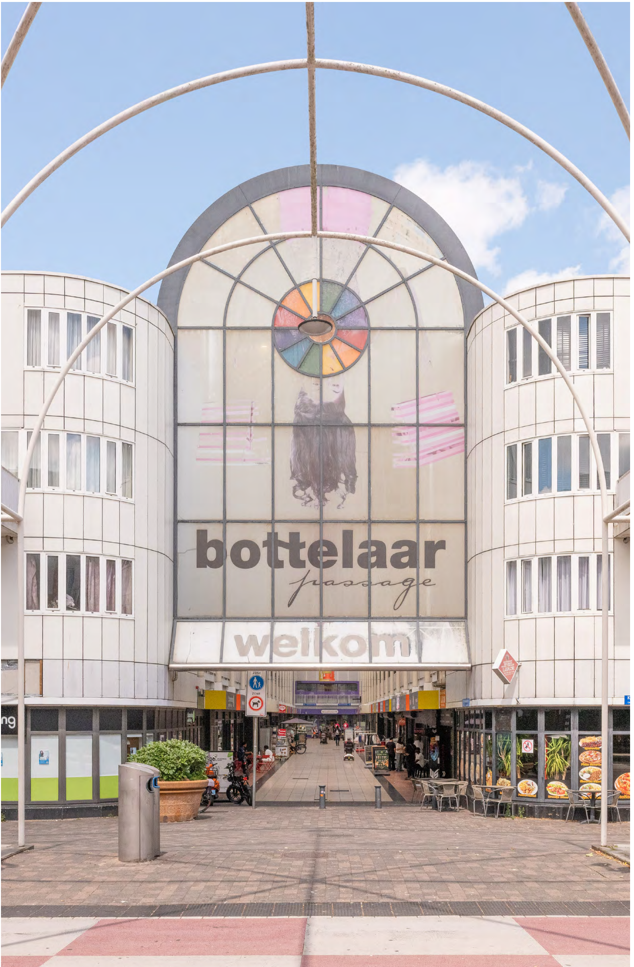
Ingang aan de Kruierstraat met kunstwerk boven busbaan
