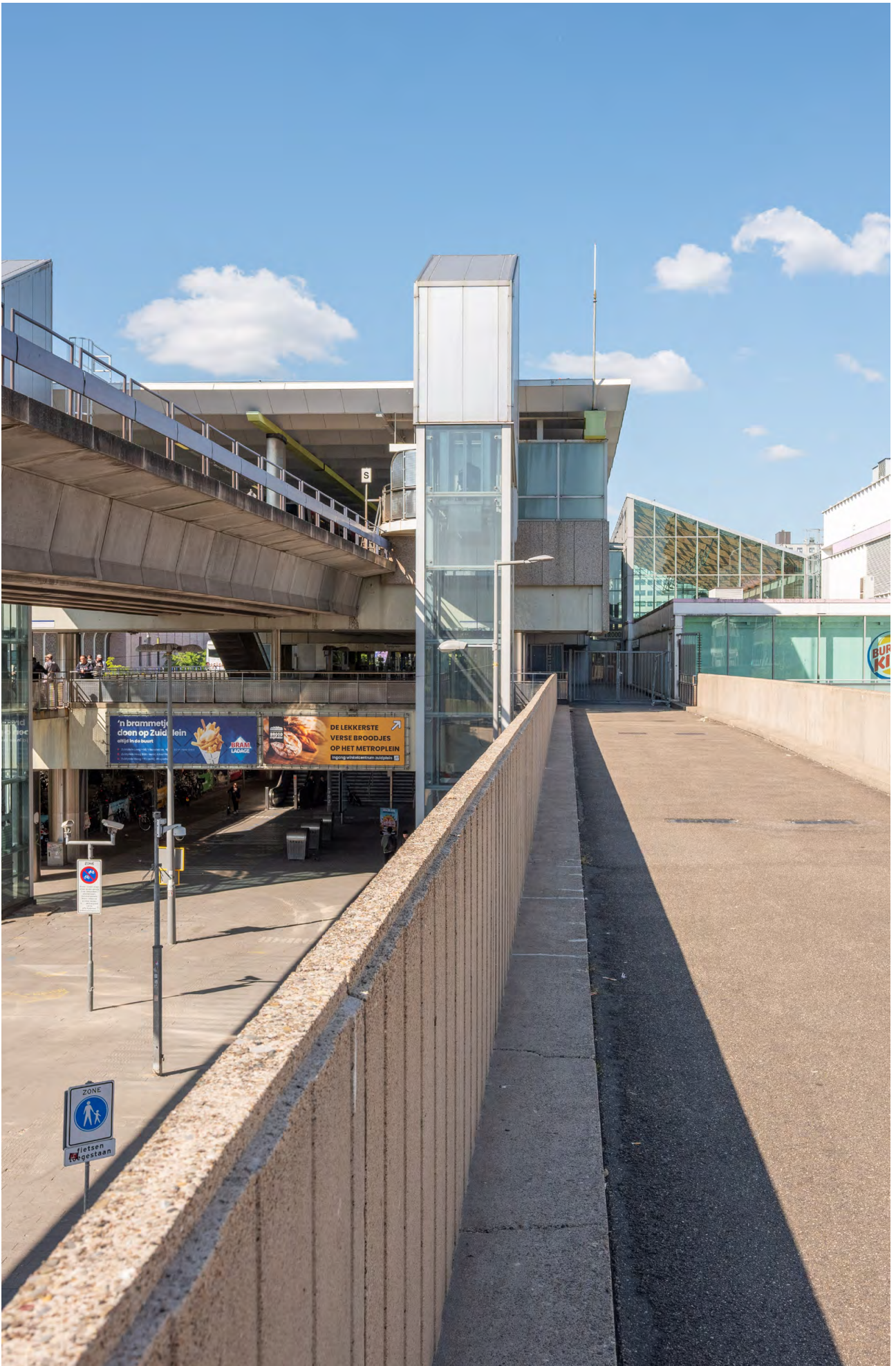
Westzijde met metrostation Zuidplein
