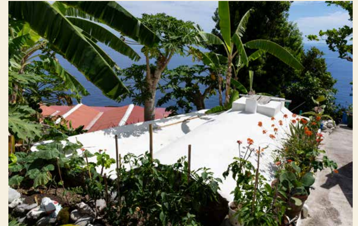
[Afb] Huiscisterne in Upper Zions Hill met links het bassin voor de opvang van regenwater.
