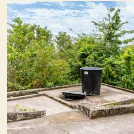
[Afb] Links van de weg bevindt zich een reservoir voor regenwater. Bij de aanleg van nieuwe wegen werden langs de wegen regenwaterreservoirs aangelegd waarbij de weg fungeert als regengoot. De functie hiervan is tweeledig. Tijdens zware regenval wordt het water van weg opgevangen en worden woeste waterstromen over de weg voorkomen. Het opgevangen water in de reservoirs was bestemd voor de landbouwers. Omdat er steeds minder landbouwactiviteiten zijn, wordt het water hiervoor nog maar weinig gebruikt.
