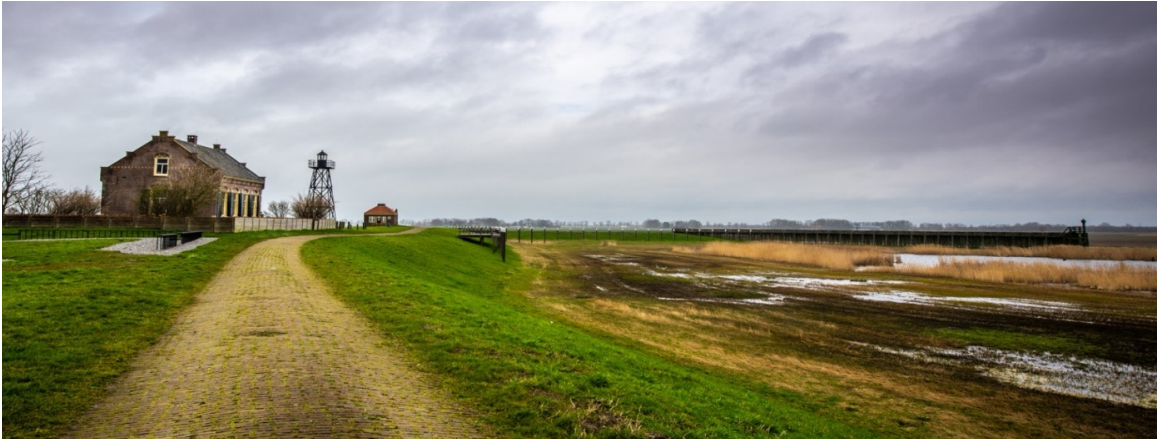
Schokland met aangelegde hydrologische zone rechts om het archeologisch bodemarchief te beschermen
