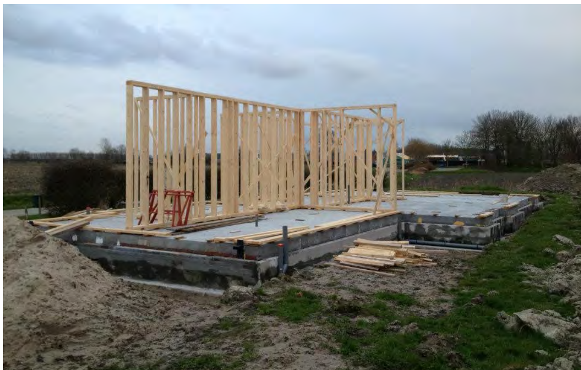
Een voorbeeld van een lichtere bouwconstructie. Foto Alies Koree, Atelier Koree
