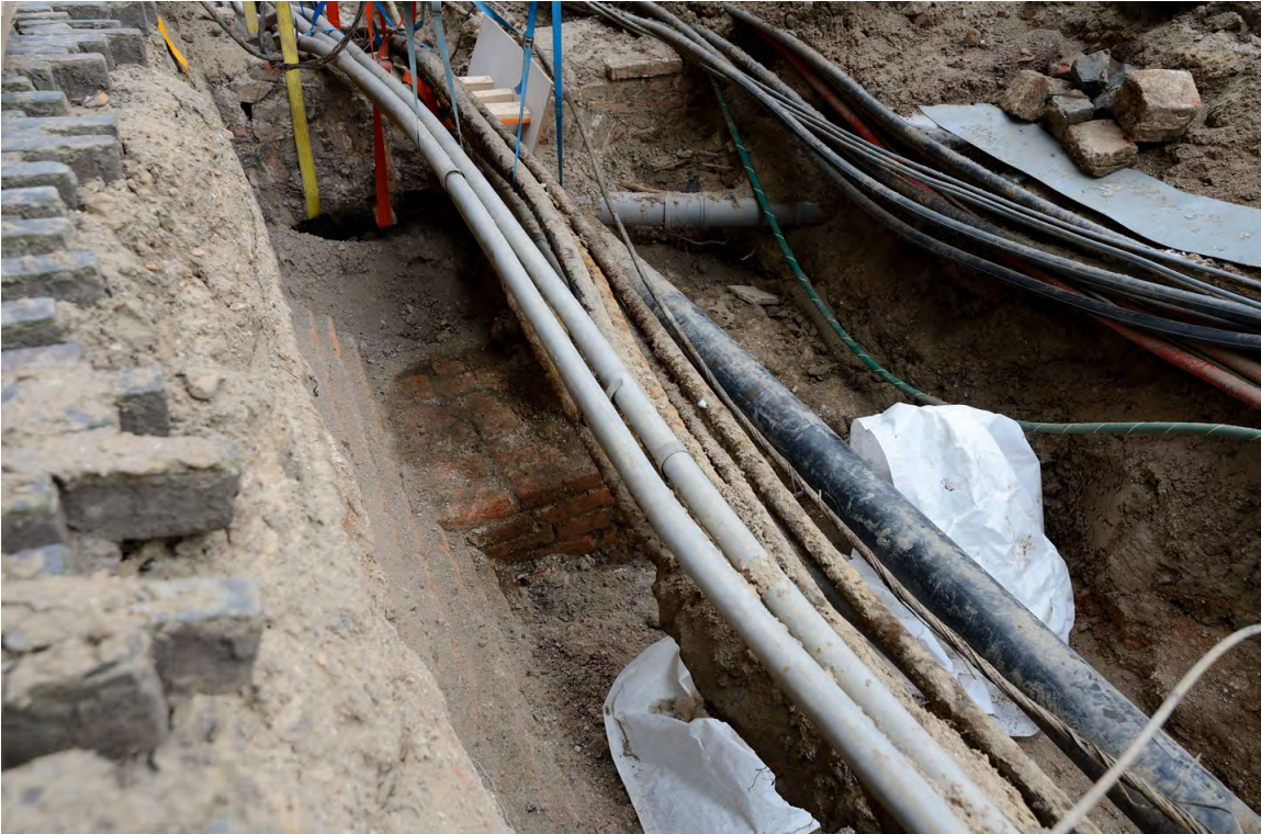
Kabelsleuf op het Domplein in Utrecht. Foto Jos Stöver, RCE
