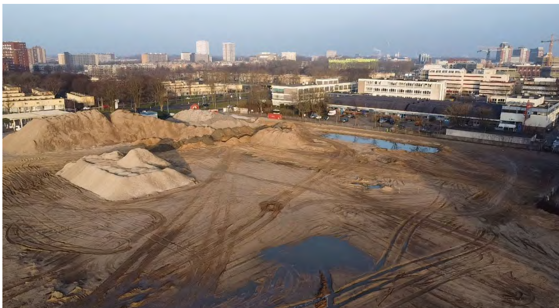
Vorbereidende werkzaamheden en gronddepot bij een bouwplaats in Utrecht. Foto: Matthijs Sonneveld, Transect.
