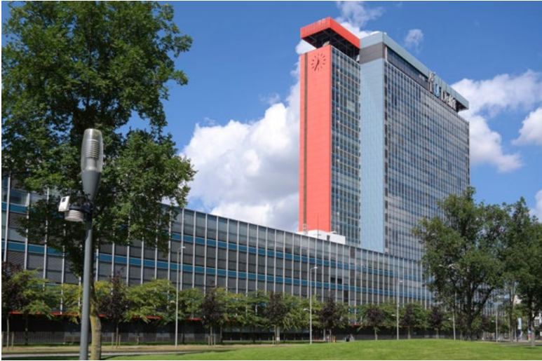
Het gebouw voor elektrotechniek in Delft kan bij extreme hitte flinke schade oplopen
