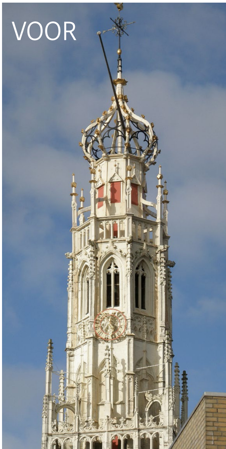
2024: De met lood beklede bekroning van de toren van de Bakenesserkerk was wit geschilderd
