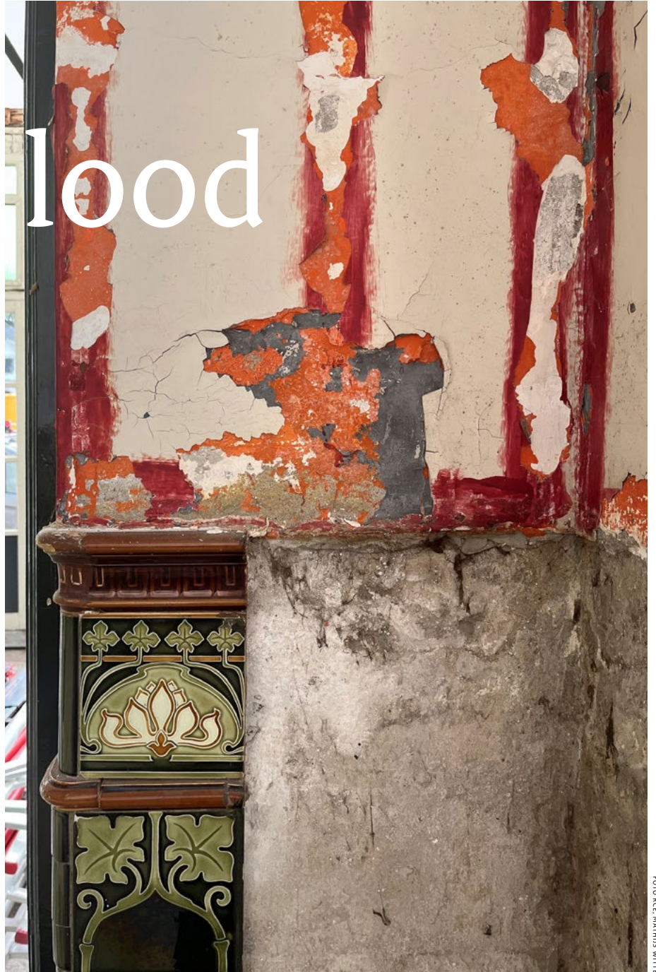
Tussen de oranje loodmenie en de witte verf is het grijze lood te zien
