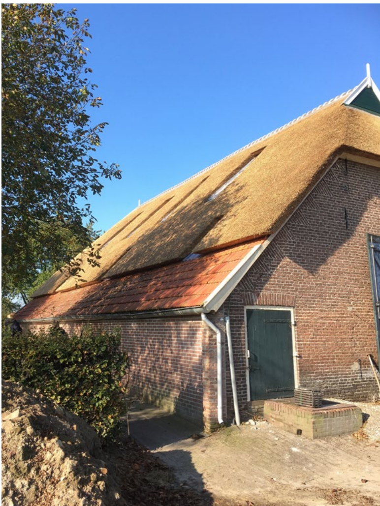
Een traditioneel rieten dak op een stal uit de zeventiende eeuw bij Marle in Overijssel
