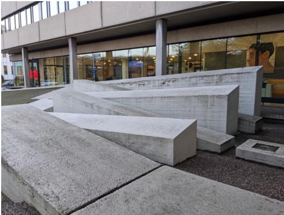
Joop Beljon, ruimtelijke, sculpturale betonnen zone voor het voormalige belastingkantoor in Arnhem (1971). Hier is sprake van kunst die zich niet langer als kunst manifesteert. Hij beoogde het contrast tussen bezoeker en gebouw te overbruggen door de betonconstructie te laten meespelen in de ruimtelijke compositie van de omgeving (bron: wikipedia.org).
