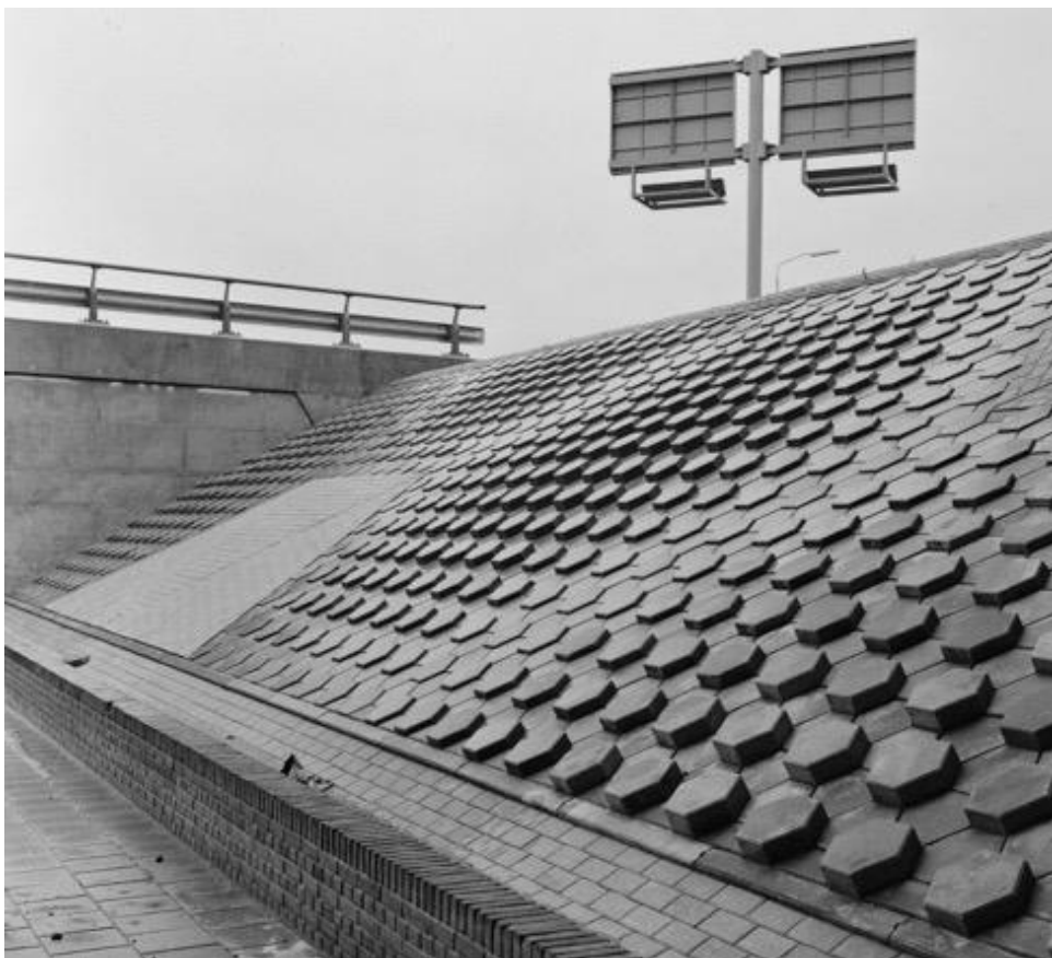
Taludreliëf van Jo Pessink. Dit bestratingspatroon onder de Rijksweg bij Zwolle (1971) toont hoe een artistieke ingreep zich dienstbaar kon voegen in de ruimtelijke vormgeving van infrastructuur. (bron: Collectie Overijssel, collectie Dolf Henneke).
