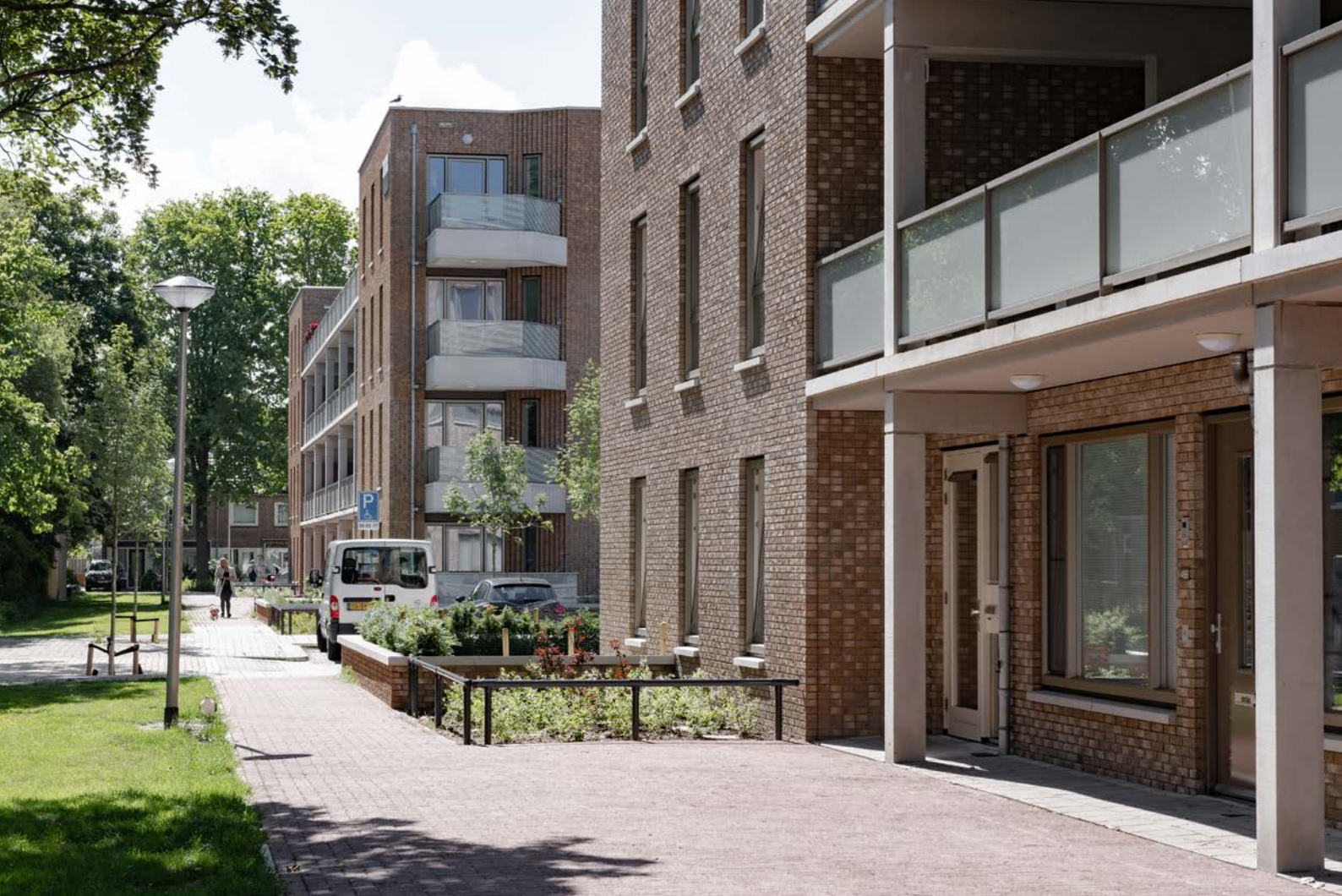
Het voorheen anonieme wandelpad loopt in de nieuwe situatie langs voordeuren en leefgalerijen. Foto: Sebastian van Damme.
