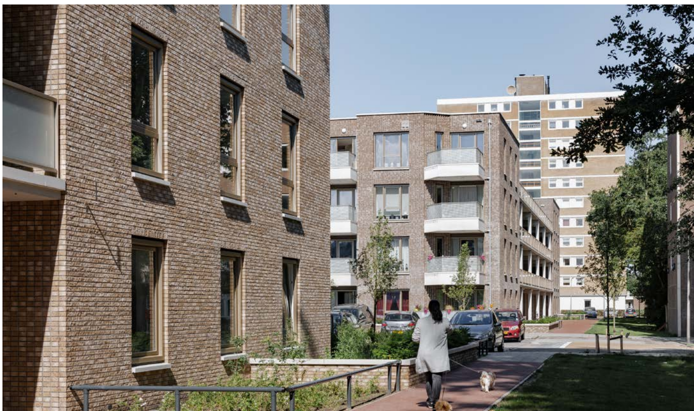
De nieuwe gebouwen hebben een meer alzijdige uitstraling. Op de begane grond en op de koppen zijn in tegenstelling tot de oorspronkelijke portiekwoningen ingepast. Foto van het pad aan de hofzijde: Sebastian van Damme.
