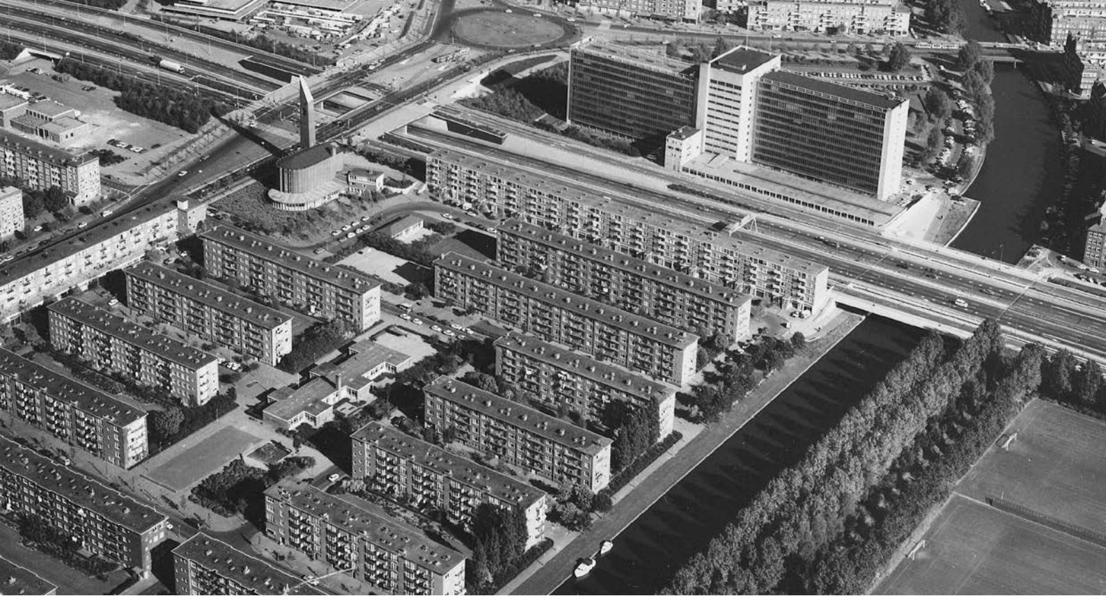
Luchtfoto vanuit het westen met op de voorgrond de strokenbouw, moskee en Kolenkitkerk in de Kolenkitbuurt-Zuid (1972). Foto: Stadsarchief Amsterdam.
