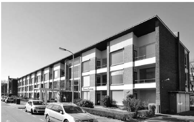
De bestaande serviceflat kenmerkte zich door een plastisch gevelbeeld dankzij terugliggende loggia's en een licht oplopend lessenaarsdak. Foto: StudioSchaeffer.
