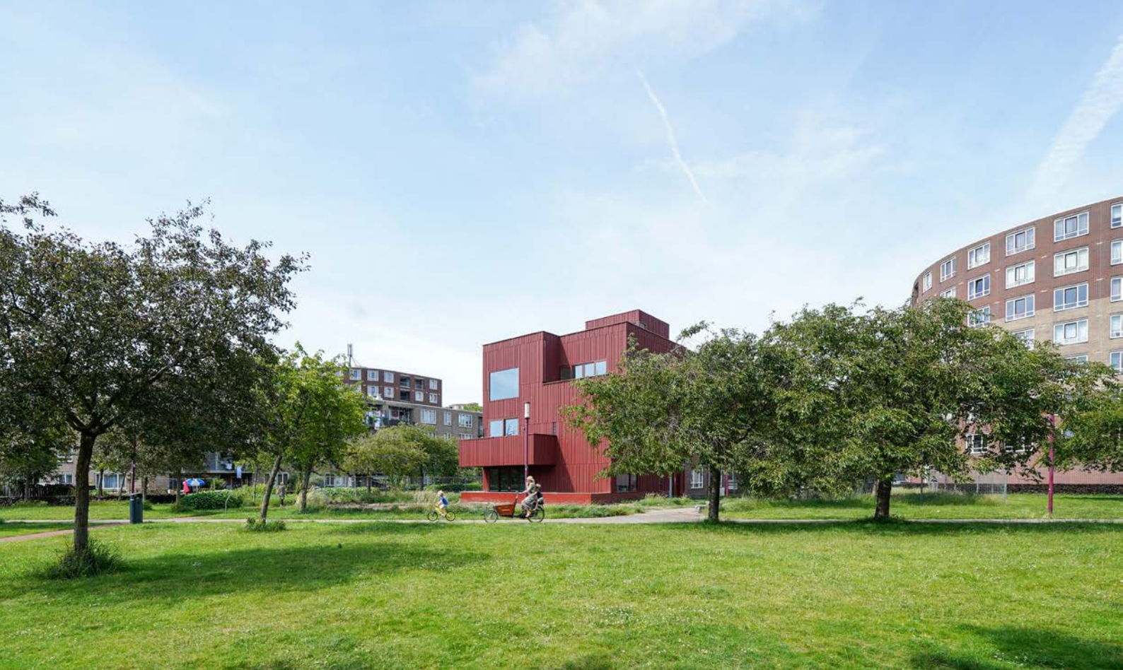
De Houten Kop geeft het bouwblok van Weeber een beëindiging in het Kaappark. Foto: Studio Architectuur MAKEN.
