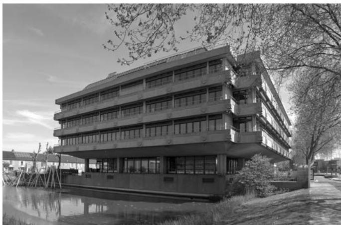
Oorspronkelijk was het gebouw voorzien van horizontale banden van grindbeton en glas. Foto: Johan Bakker.
