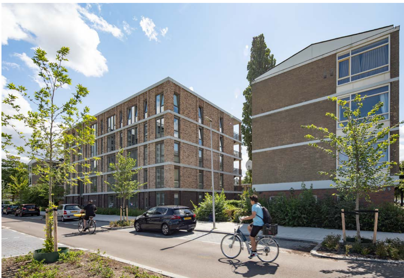
Het nieuwe appartementengebouw staat langs de Cervanteslaan op de bestaande rooilijn en voegt zich ook architectonisch naadloos tussen de bestaande gebouwen. Foto: LEVS architecten.
