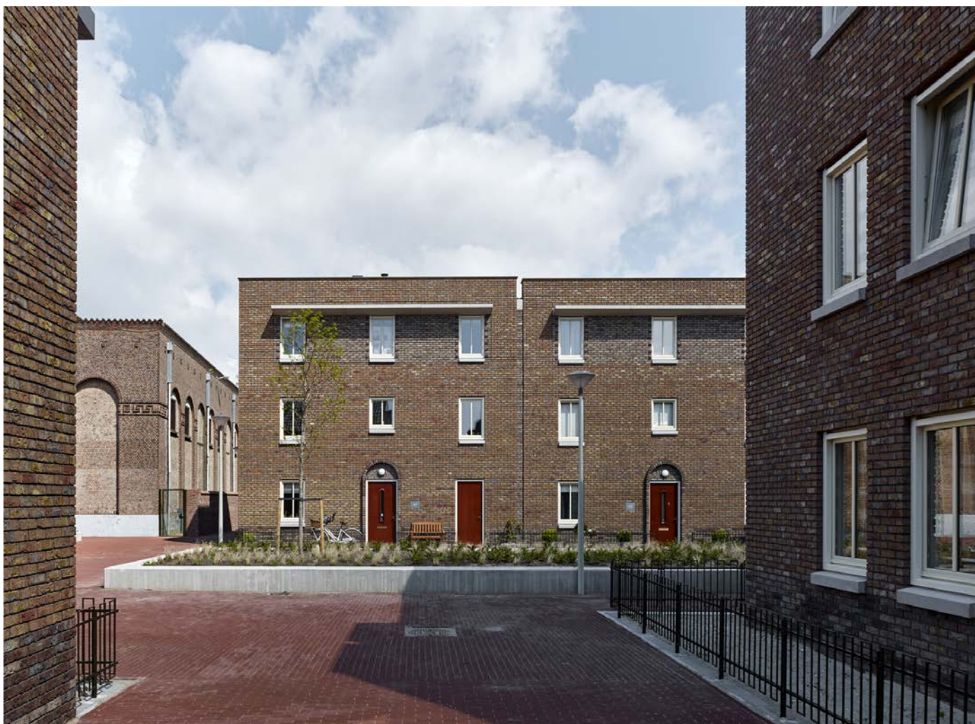
Subtiel details als een gemetselde boog rondom de voordeuren en een hedendaagse kroonlijst verwijzen naar de architectuur van de Delftse / Bossche School. Foto: Stefan Müller.
