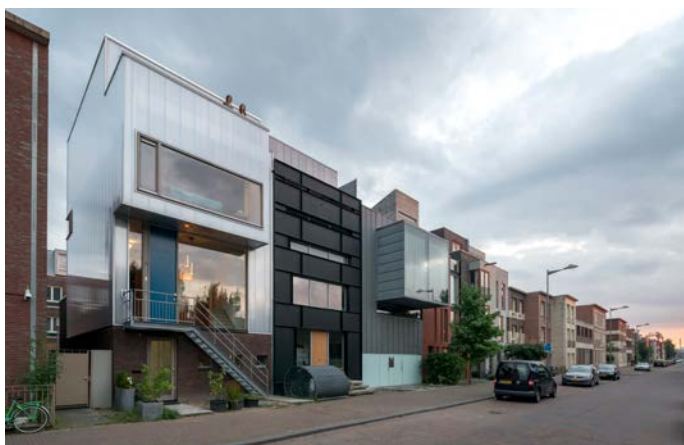
Kleurrijke en expressieve zelfbouwwoningen aan de overzijde van het Kaappark. Foto: Ossip van Duivenbode.
