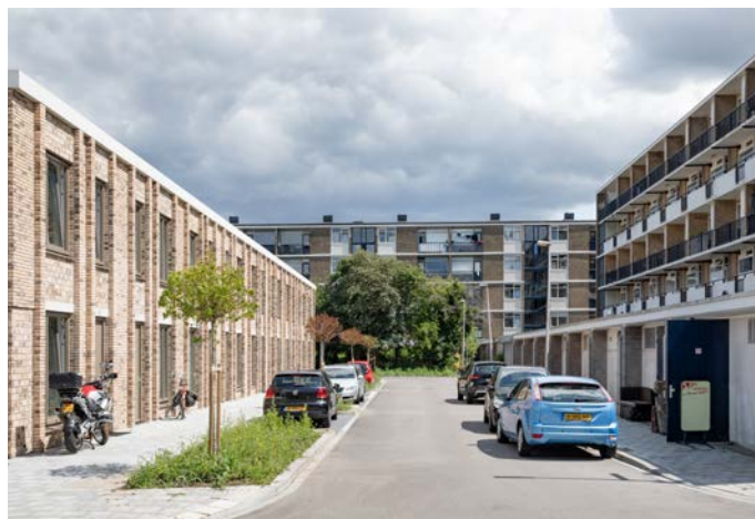
De eengezinswoningen hebben een meer verticale geleiding. Foto: LEVS architecten.
