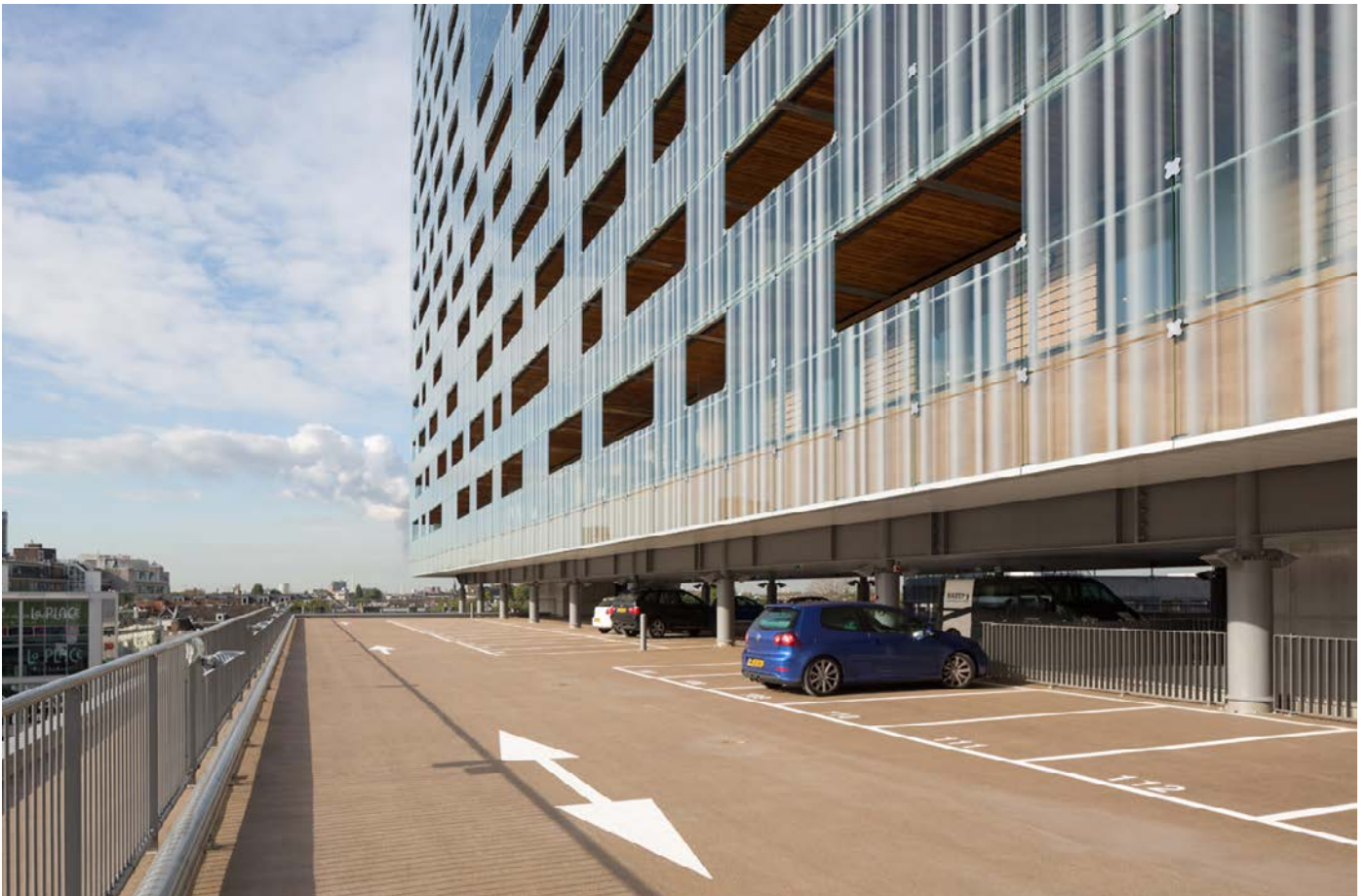
Op het dak van het vroegere warenhuis Ter Meulen wordt geparkeerd. Het nieuwe gebouw is los gehouden van de onderbouw en heeft een abstracte, glazen gevel met gaten. Foto: Ossip van Duivenbode.
