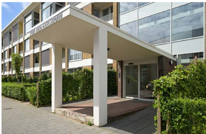
De betonnen entreeuilufel is behouden. Foto: Funda.
