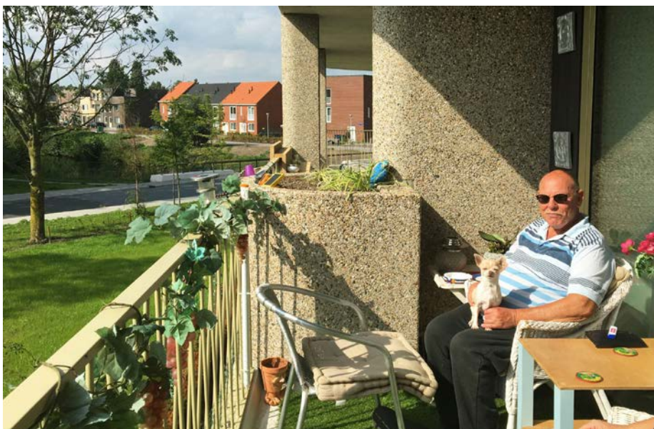
De halfronde elementen van gewassen grindbeton doen dienst als balkonkasten, plantenbakken, privacy-schermen en nissen voor regenpijpen. Foto's: Stefan Müller.
