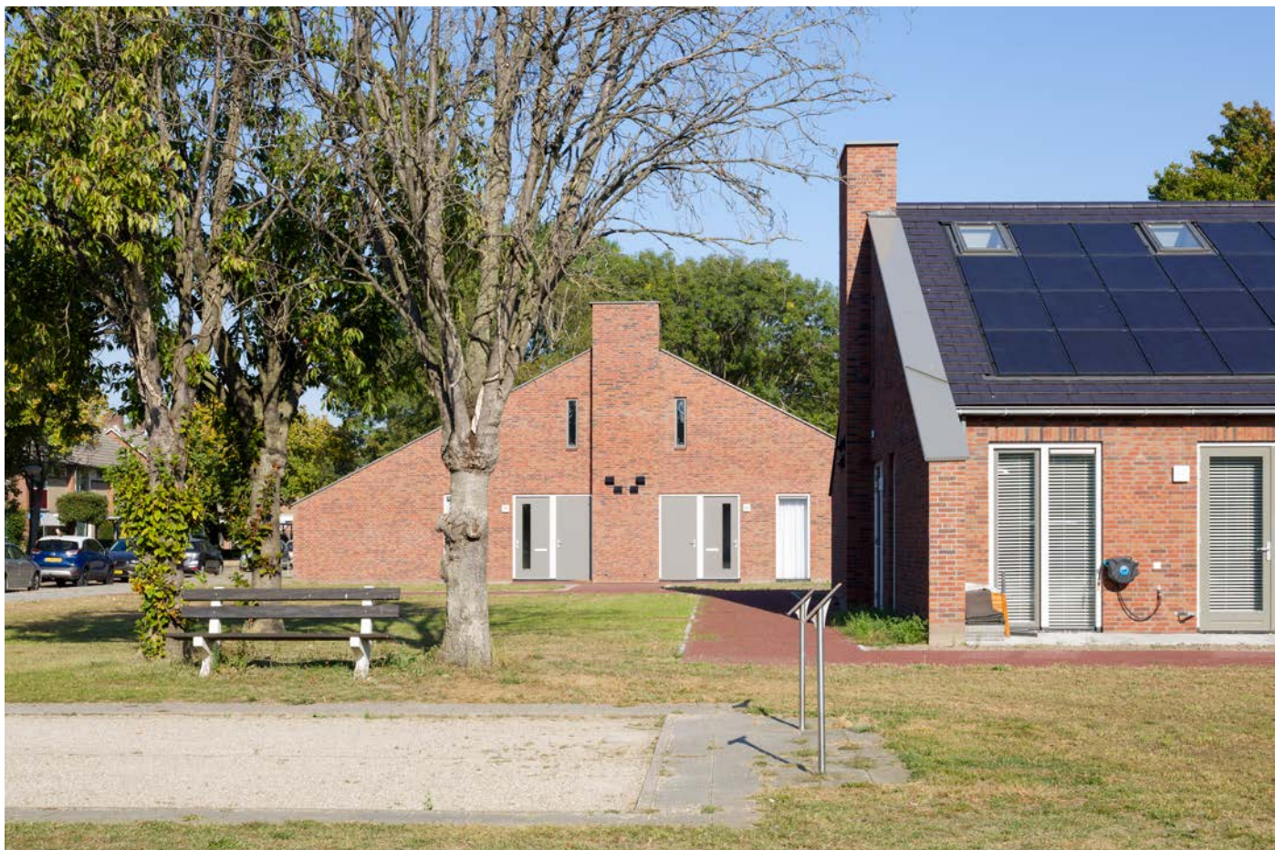
De drie gebouwen zijn alzijdig vormgegeven. De woningen hebben hun voordeuren in de koppen. Foto: Rob van Esch.
