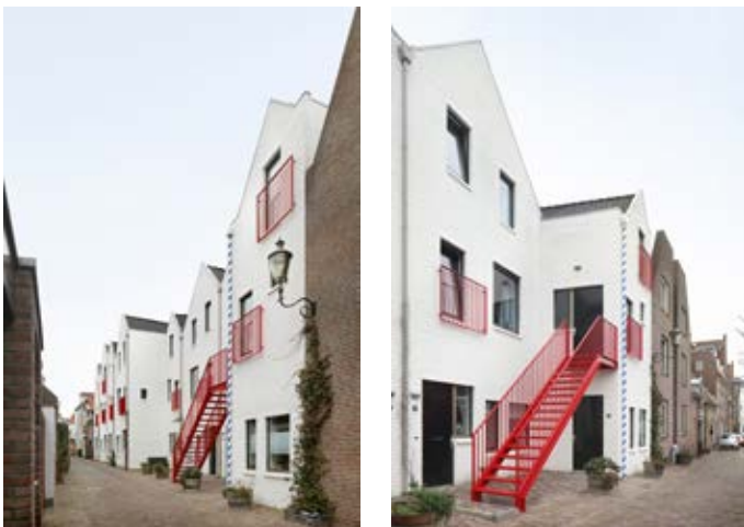
In de Valkestraat liggen enkele woningen iets terug waardoor een bredere voorruimte ontstaat. Foto: Architecten De Vylder Vinck Taillieu / Filip Dujardin.
