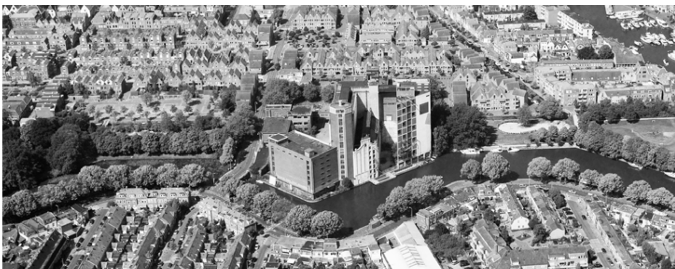
Luchtfoto vanuit het oosten van de meelfabriek voor de transformatie (2015). Foto: De Meelfabriek.
