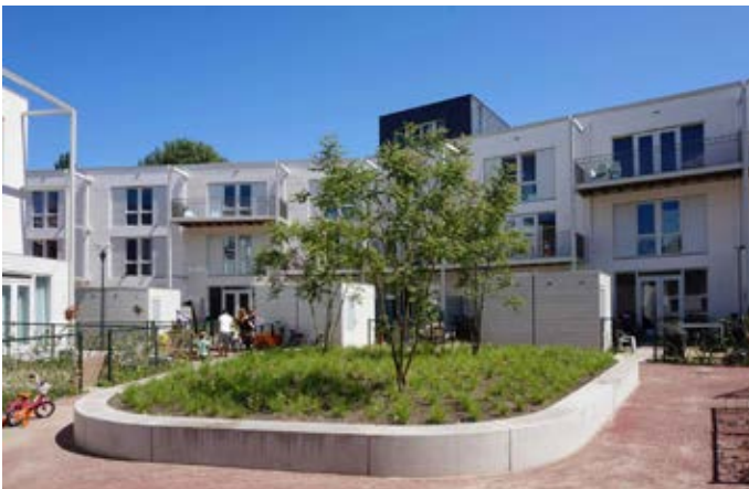
De wit gekeimde tuingevels zijn voorzien van een pergolaconstructie. Foto: Geurst & Schulze architecten.
