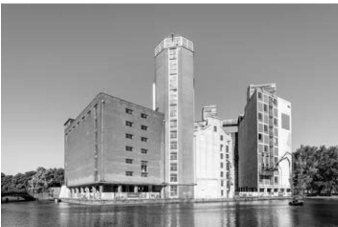
Zicht op de meelfabriek vanaf de Zijlsingel voor de transformatie (2015). Foto: De Meelfabriek / Corentin Haubruge.
