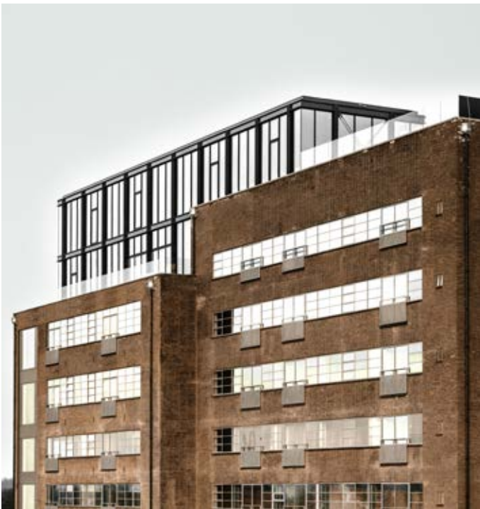
Bij het Molengebouw / Riffellokaal vormde de kenmerkende bakstenen gevel met strookvensters het uitgangspunt voor de transformatie. Bij het meelpakhuis is de bakstenen gevel verwijderd en is de betonconstructie als blikvanger zichtbaar gemaakt. Beide gebouwen kregen een lichte opbouw. Foto's: De Meelfabriek / Corentin Haubruge.
