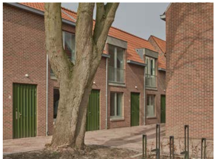
Details als eenvoudige zinken dakgoten en flesgroene voordeuren geven de gebouwen een hedendaagse knipoog. Foto: MWA Hart Nibbrig.
