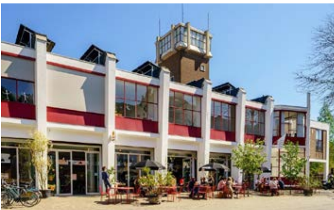
De voormalige brandweerkazerne is nu in gebruik als restaurant en werkplek voor creatieve ondernemers. Foto: gemeente Maastricht.
