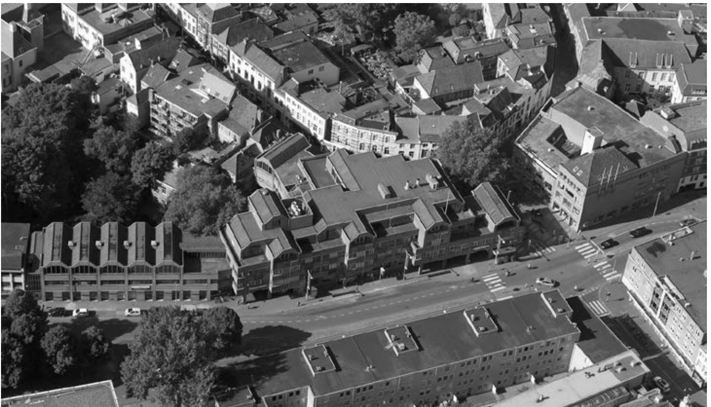
Luchtfoto van het voormalige complex van de sociale dienst (midden) en het Hendriksgebouw (rechts) aan de Vlaszak – John F. Kennedylaan omstreeks 2013. Foto: Michel Kievits.
