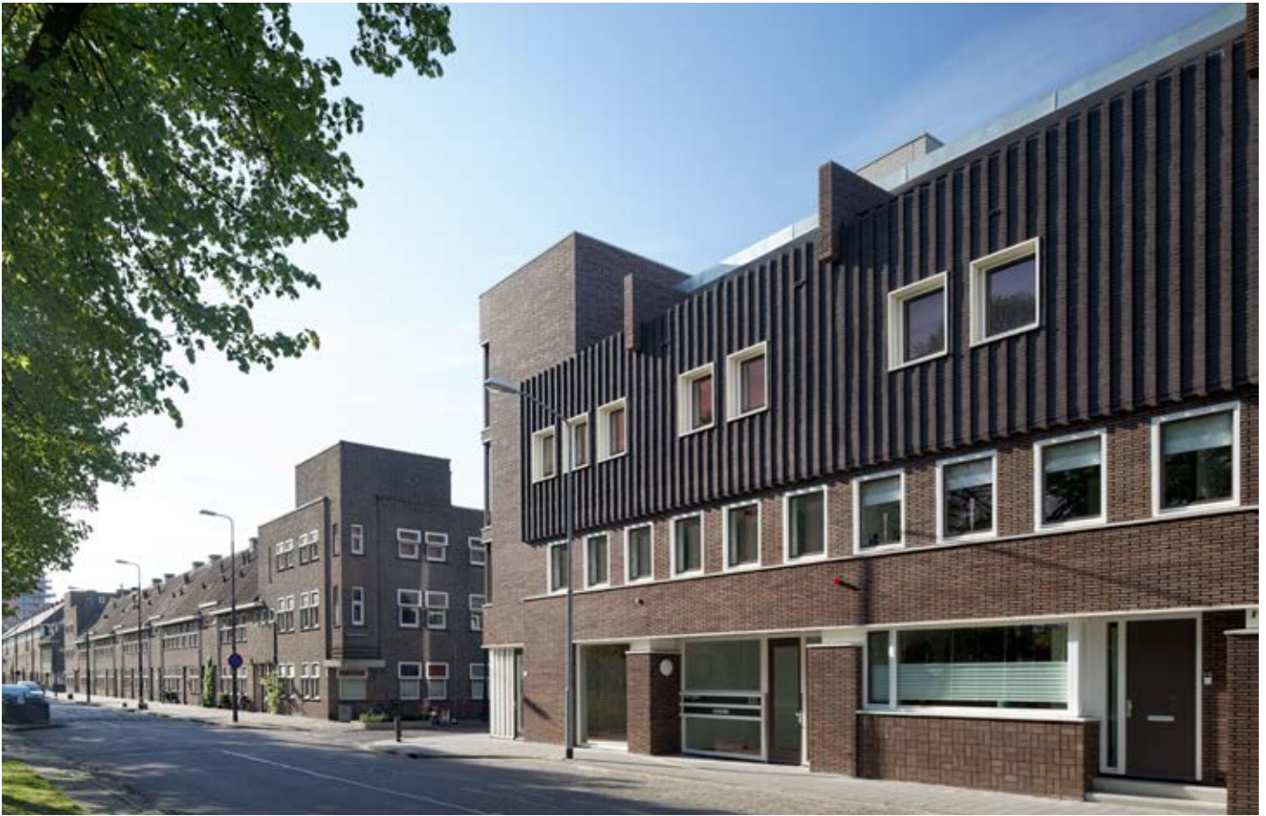
De nieuwbouw sluit qua volumeopbouw, materialisatie en detaillering nauw aan bij de bestaande bebouwing in de wijk. Foto: René de Wit.
