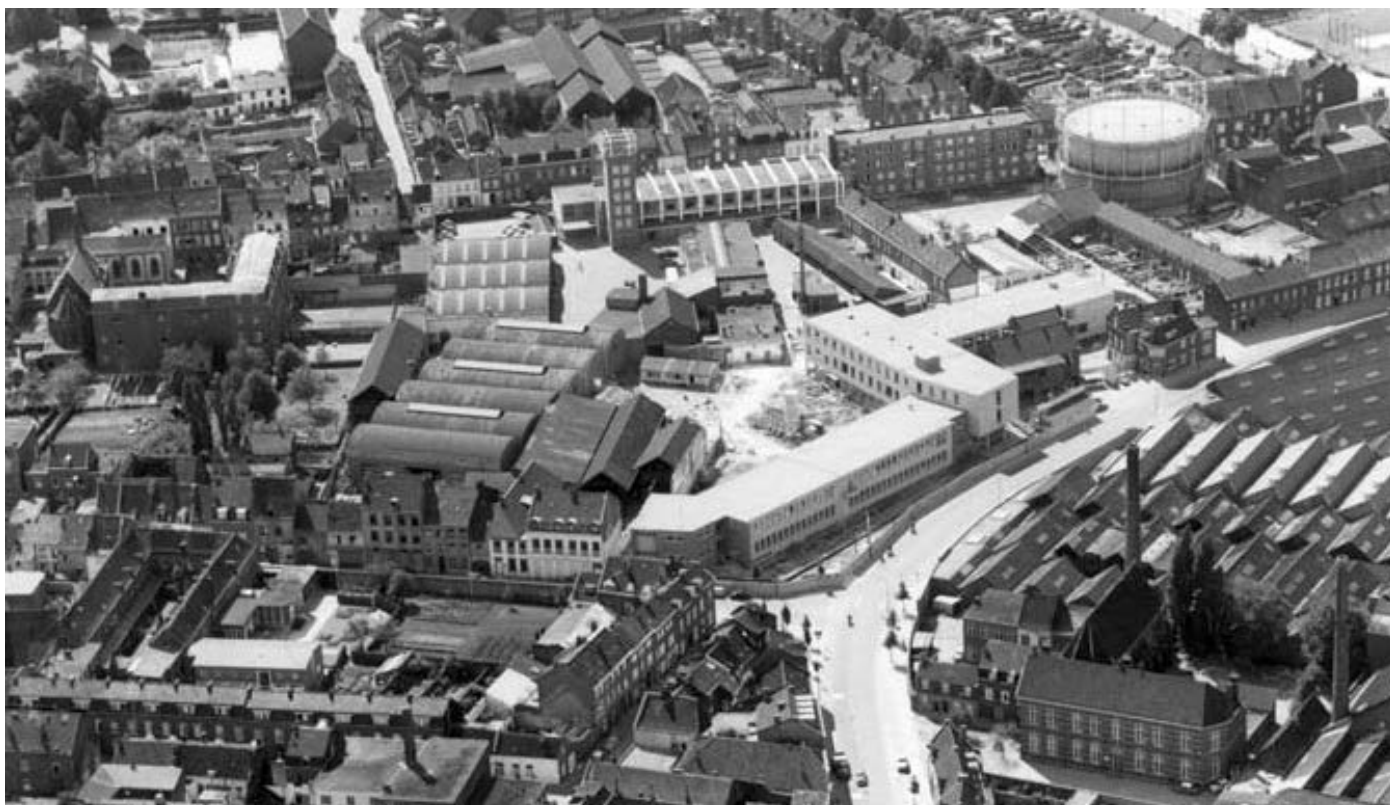
Luchtfoto vanuit het oosten van het nutsterrein (1965). Op de voorgrond is de route Achter de Baracken-Maagdendries zichtbaar, centraal bovenaan de brandweerkazerne met slangentoren. Foto: Gemeentearchief Maastricht.
