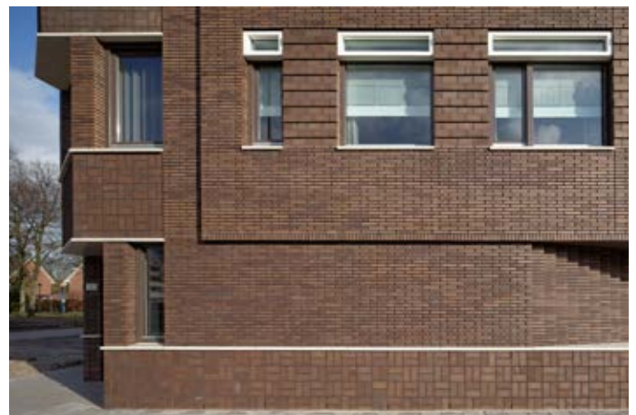
Verschillende metselverbanden op de meest prominente hoek van het bouwblok. Foto: René de Wit.
