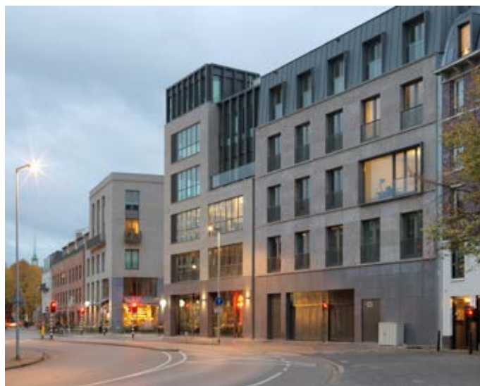
Twee hogere bouwdelen aan weerszijden van de straat Gasthuispoort vormen een hedendaagse poort naar de binnenstad. Foto: Michel Kievits.
