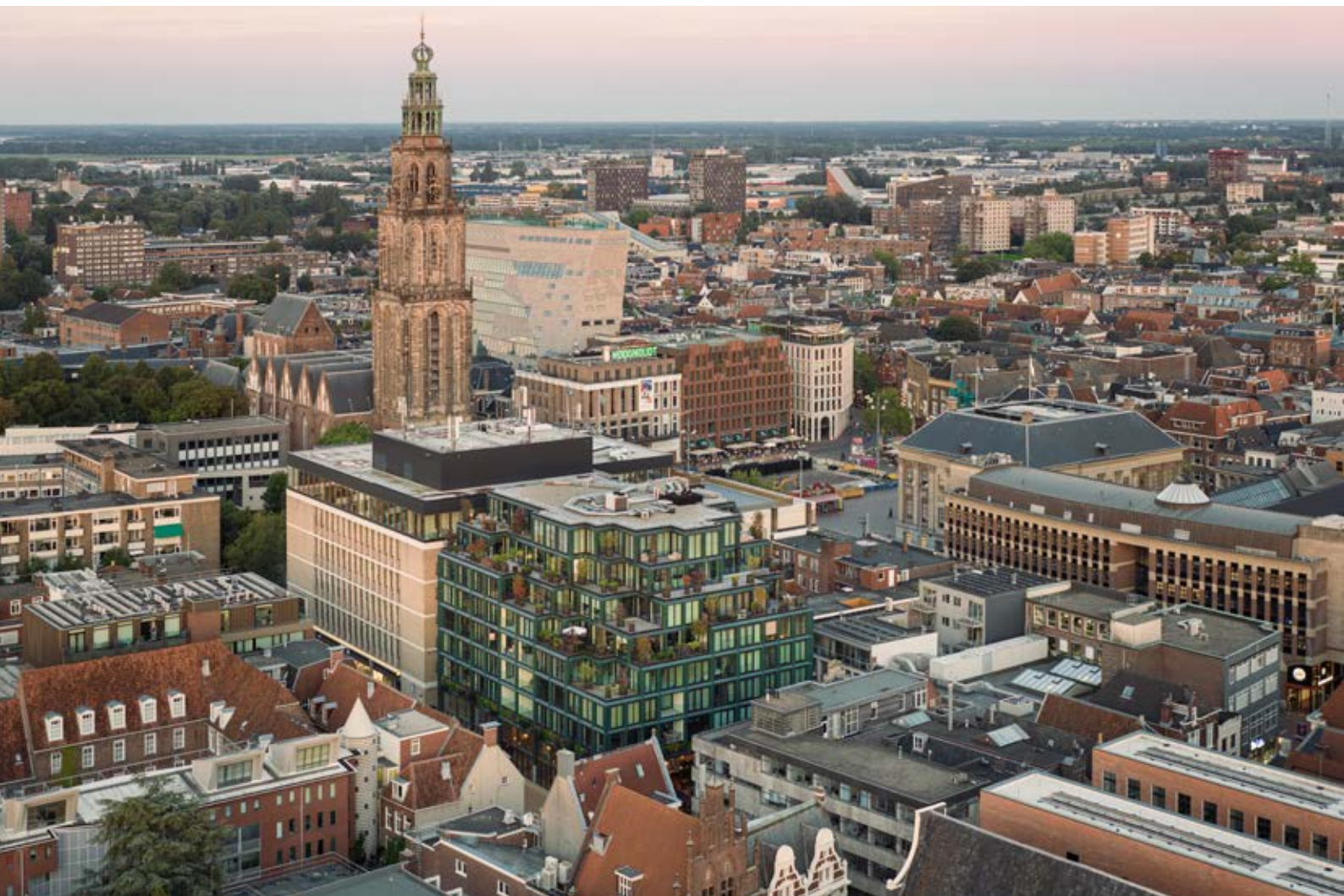
Luchtfoto vanuit het westen van de transformatie van de Rode Weeshuisstraat. Foto: Marcel IJzerman.
