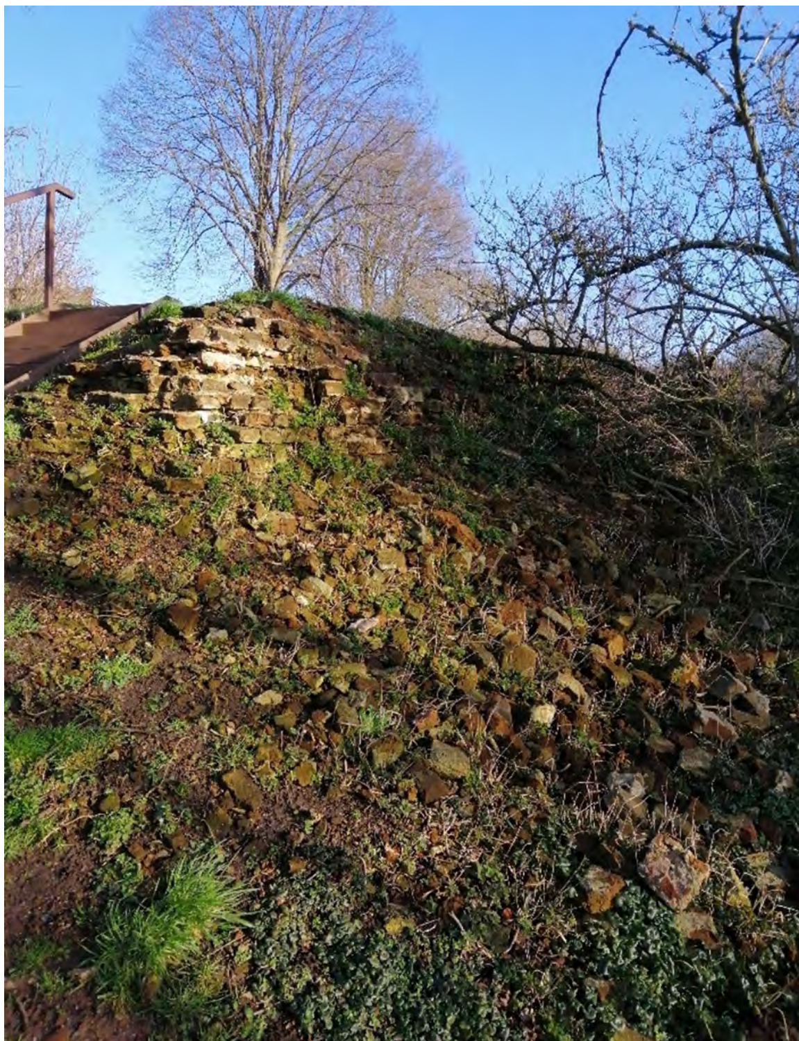
Afb.5.4. Foto visuele inspectie rijksmonument 525667.
