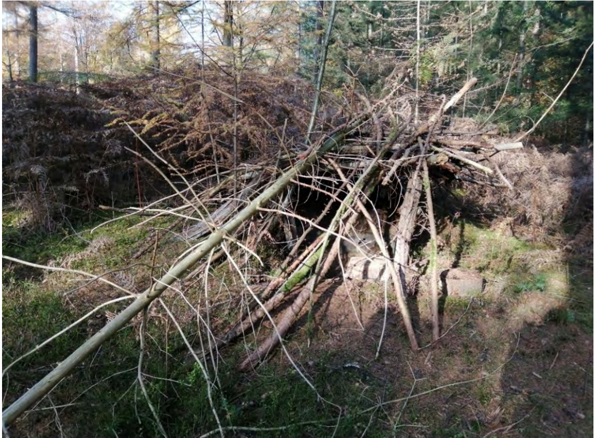
Afb. 5.8. Foto visuele inspectie complex, 12398, rijksmonument 45839; een groot gat is zichtbaar aan de voet van de grafheuvel. Over het gat zijn takken gelegd.
