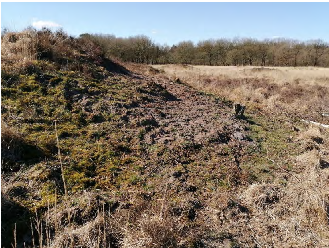
Afb. 5.3. Foto visuele inspectie Rijksmonument 532467, complex 50979. De grafheuvel is geërodeerd door runderen. Dit is geregistreerd als directe bedreiging.
