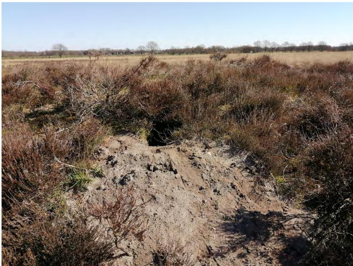
Afb.5.4. Foto visuele inspectie Rijksmonument 532467. Dierenhollen zijn geregistreerd als directe bedreiging en enig risico. Het gaat volgens de waarneming om konijnenhollen en mogelijk een dassenburcht en vossenhollen.
