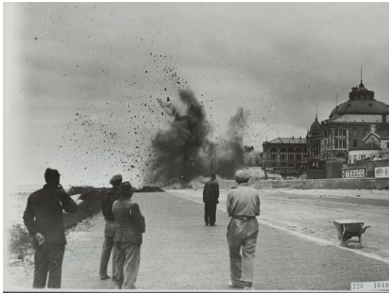
Afb. 20 Tot ontploffing brengen van een bunker bij het Kurhaus in Scheveningen, 1955
