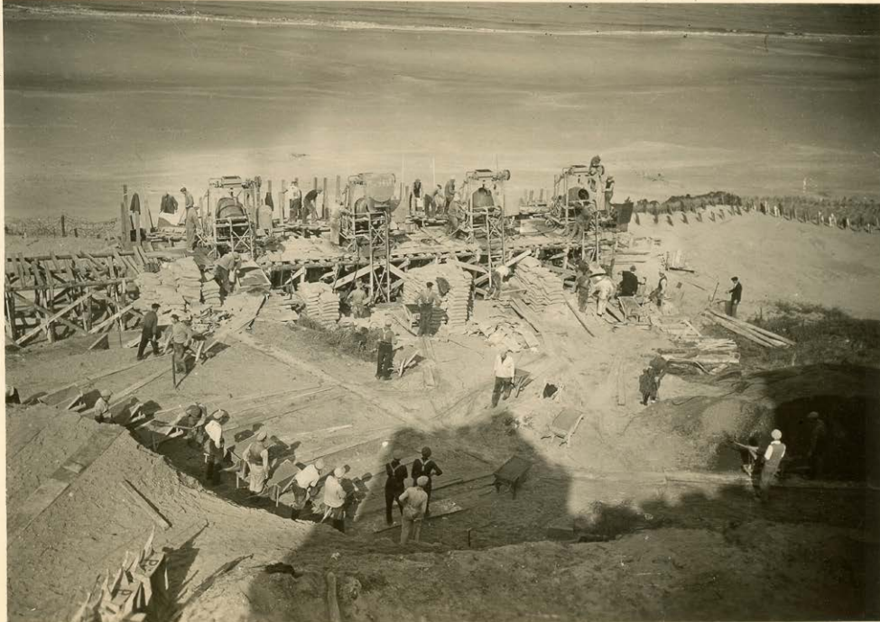
Afb. 27 Aanleg van een tankmuur bij Katwijk
