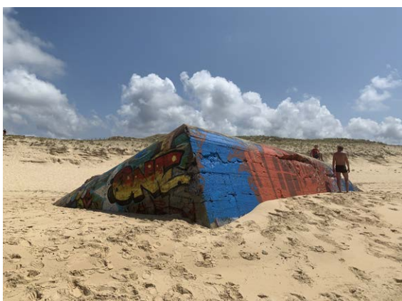
Afb. 28 Door kustafslag op het strand gelegen bunker in Contis (F.)
