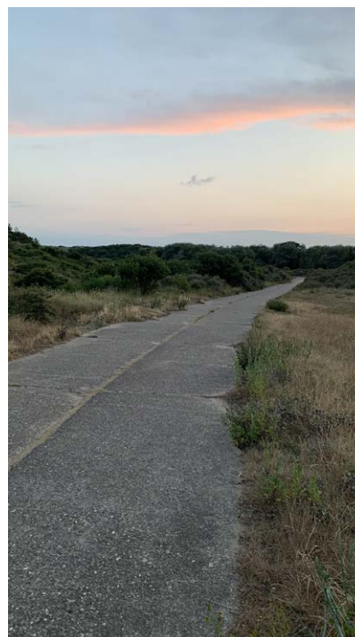
Afb. 31 Een door de Duitse bezetter aangelegde weg in de Festung IJmuiden, ook voorbeeld van een 'zacht spoor'
