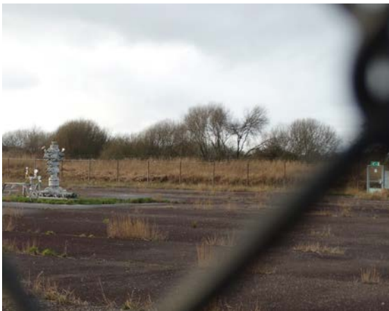
54 Afsluiter op Schaaphok, een proefboring die niet meer wordt gebruikt voor onderzoek
