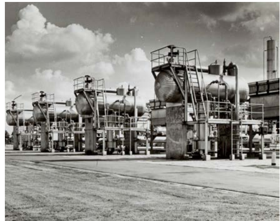
4 Onderdelen van de behandelingstrein waar aardgascondensaat en productiewater van het gas werden gescheiden
