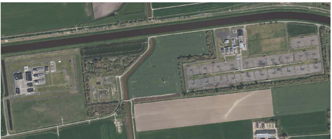
77 Luchtfoto ten westen van Scheemda, met het compressorstation, het overslagstation, de fakkeltoren en de voormalige dubbele productielocatie
