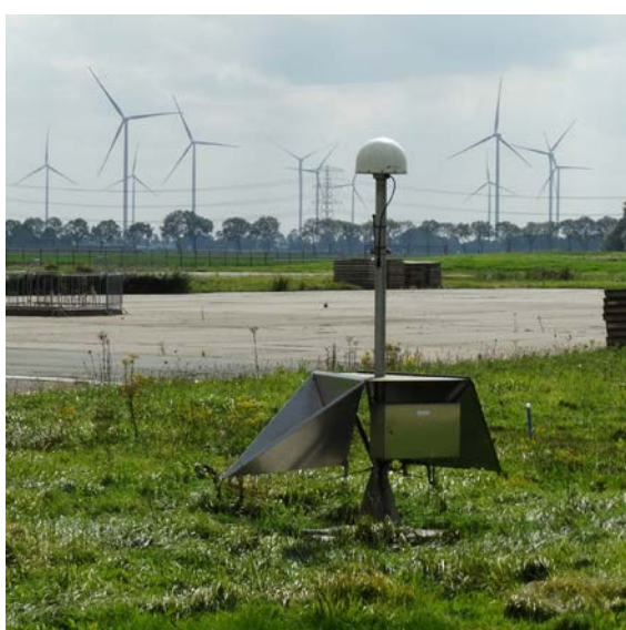
64 Apparatuur op de productielocaties meet bodemdaling. Hier op de in 2009 gesloten locatie Nieuw-Scheemda, 27 augustus 2024
