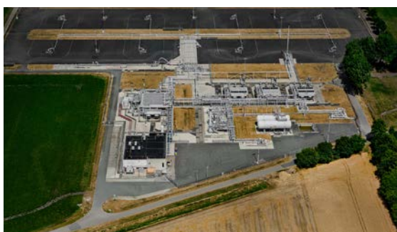
20 Boven: Slochteren-2 in de boorperiode (1960-1965). Links een afgewerkte put, rechts een boortoren. Onder: Slochteren-2 na de renovatie van het Groningen Long Term Project. Foto: John Gundlach / Flying Holland
