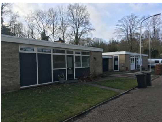
58 NAM-bungalows in de Assense wijk Zuiderpark, vlakbij de kantoren, 23 januari 2024
