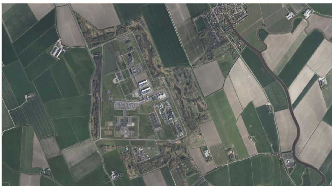
47 De NAM-locatie bij Grijpskerk van boven. Het terrein beslaat vijftig hectare, ingepakt in een landschapsplan dat honderd hectare beslaat
