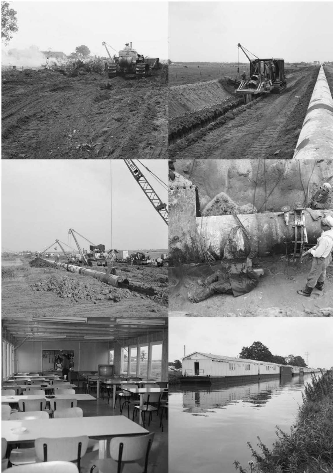
9 Het leggen van de hoofdtransportleiding in 1965. Het vrijmaken van de werkstrook, het graven van de sleuf, het leggen van de leiding, het lassen en de kantine en woonschuiten in de Hoogeveense vaart.
