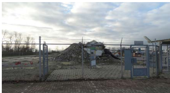
32 Afgebroken controlekamer, Overschild, 4 januari 2024
