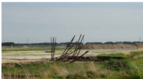
34 Bij de productielocatie Uiterburen, gesloten sinds 2009, is de bodemsanering inmiddels begonnen, 27 augustus 2024
