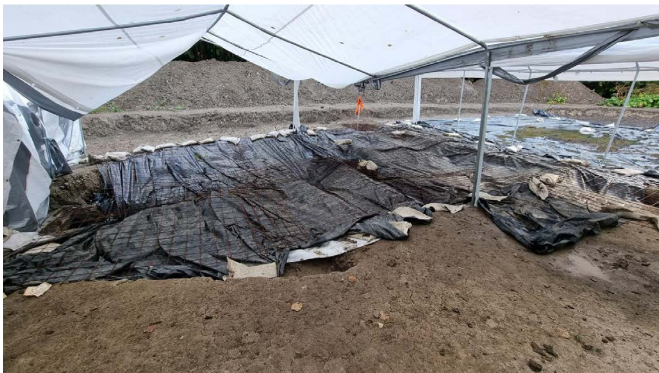
Afb. 6.3 Vervolgens is landbouwplastic geplaatst, dat is afgedekt met zandzakken en betonvlechtdraad.
