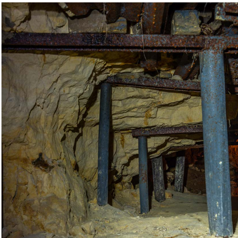
Figuur 4-7: Blik in enkele direct aan de centrale bezoekersgang grenzende galerijen. Duidelijk is te zien dat de in de jaren '60 en '70 geplaatste stalen ondersteuning door corrosie is aangetast. Foto's: RCE, Jos Stöver
