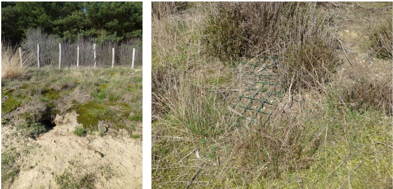
Afb. 1.2 In het heuvellichaam bleken ingraven zichtbaar (foto links) en gaas aan het oppervlak (foto rechts).
