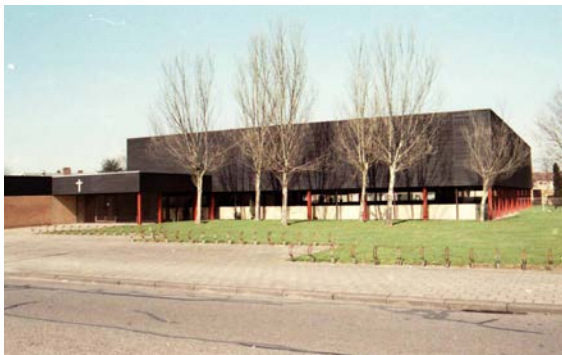
Het Woord Gods, Swalmen, Van der Grinten en Heijdenrijk, 1967 (sloop in 2008)
