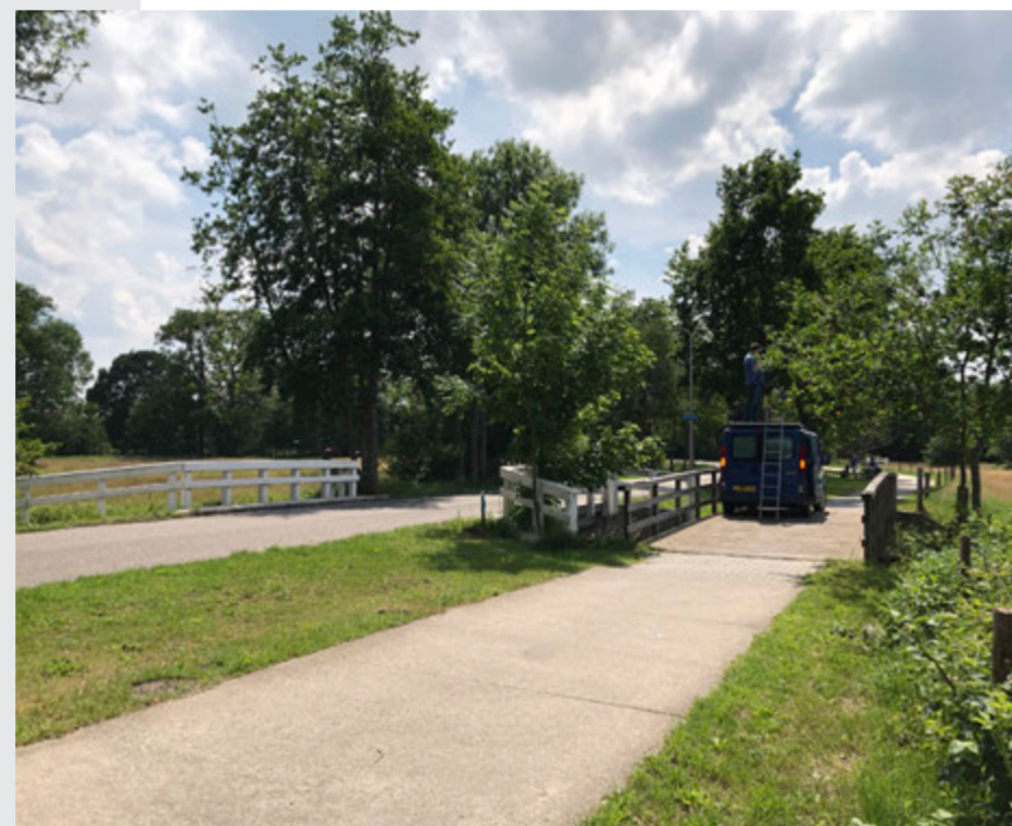
Naast de brug is een aparte overgang voor langzaam verkeer.
