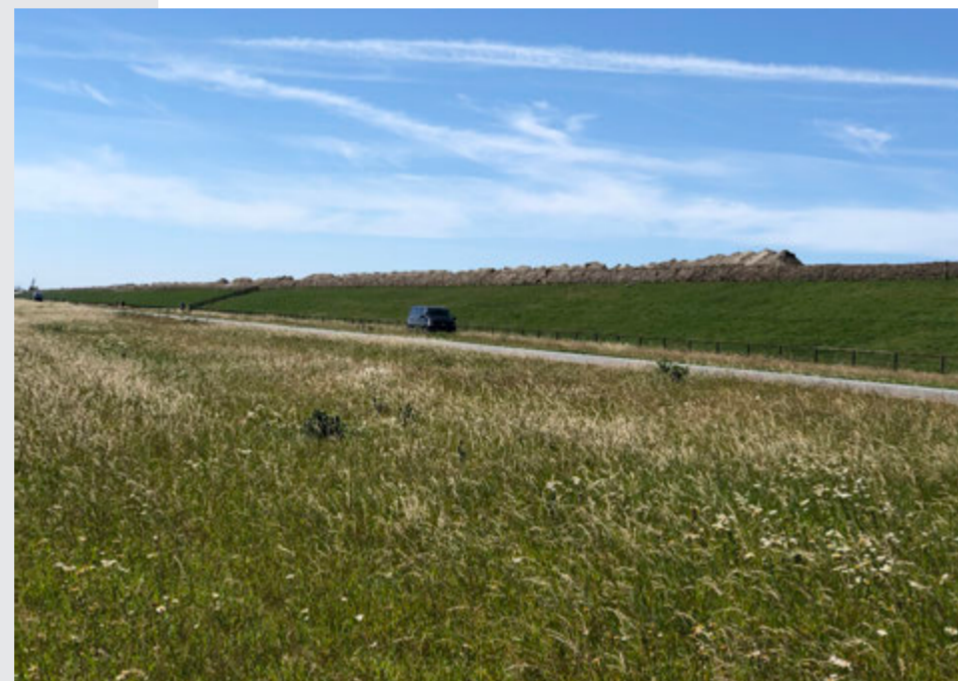
Aan de dijk wordt druk gewerkt.
