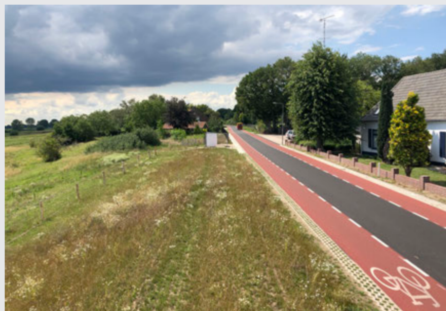
Het wegprofiel op de verzwaarde en verhoogde dijk. Naast de weg is de dijk nog een meter hoger.
