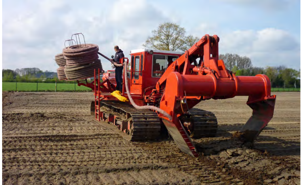
Afb. 5.6 Sleufloos aanbrengen van een drainagebuis met een V-vormige bodemfrees (foto: Smits B.V., Veldhoven).
