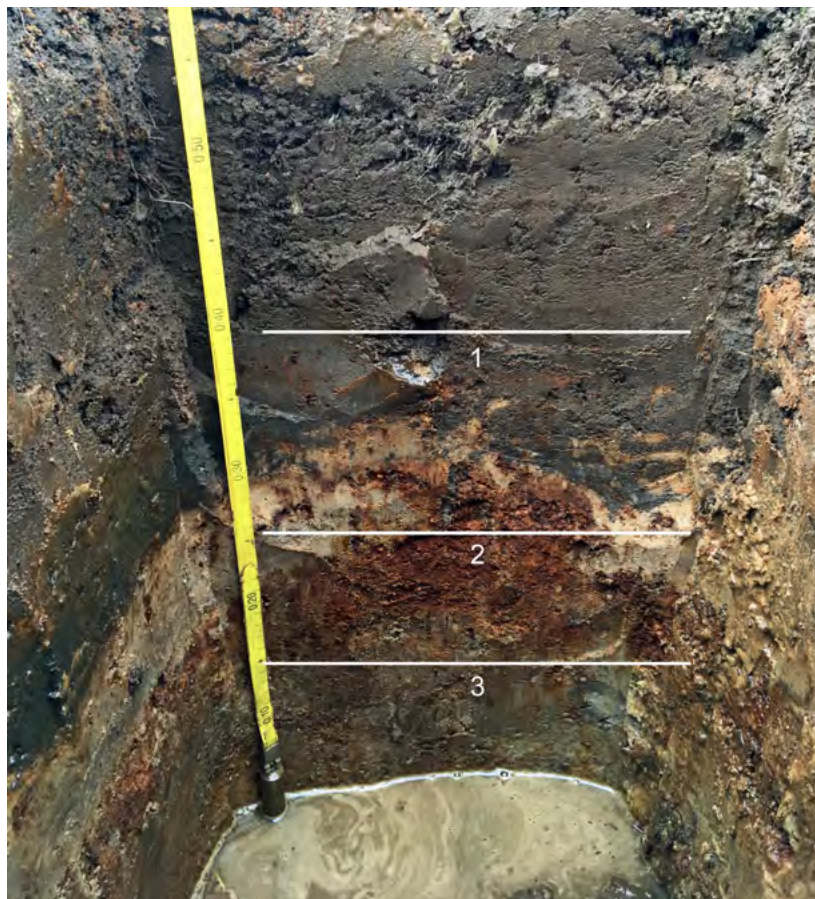
Afb. 5.5 Een profielkuil op een bouwlandperceel nabij natuurgebied Lonnekermeer toont drie verdichtingen: 1) een dicht gereden ploegzool met water stagnatie (30-35 cm - mv); 2) een harde ondoordringbare ijzeroerlaag (45-55 cm -mv) en 3) een sterk lemige laag (55-65 cm -mv) (foto: Joris Schaap, Badus Bodem & Water).
