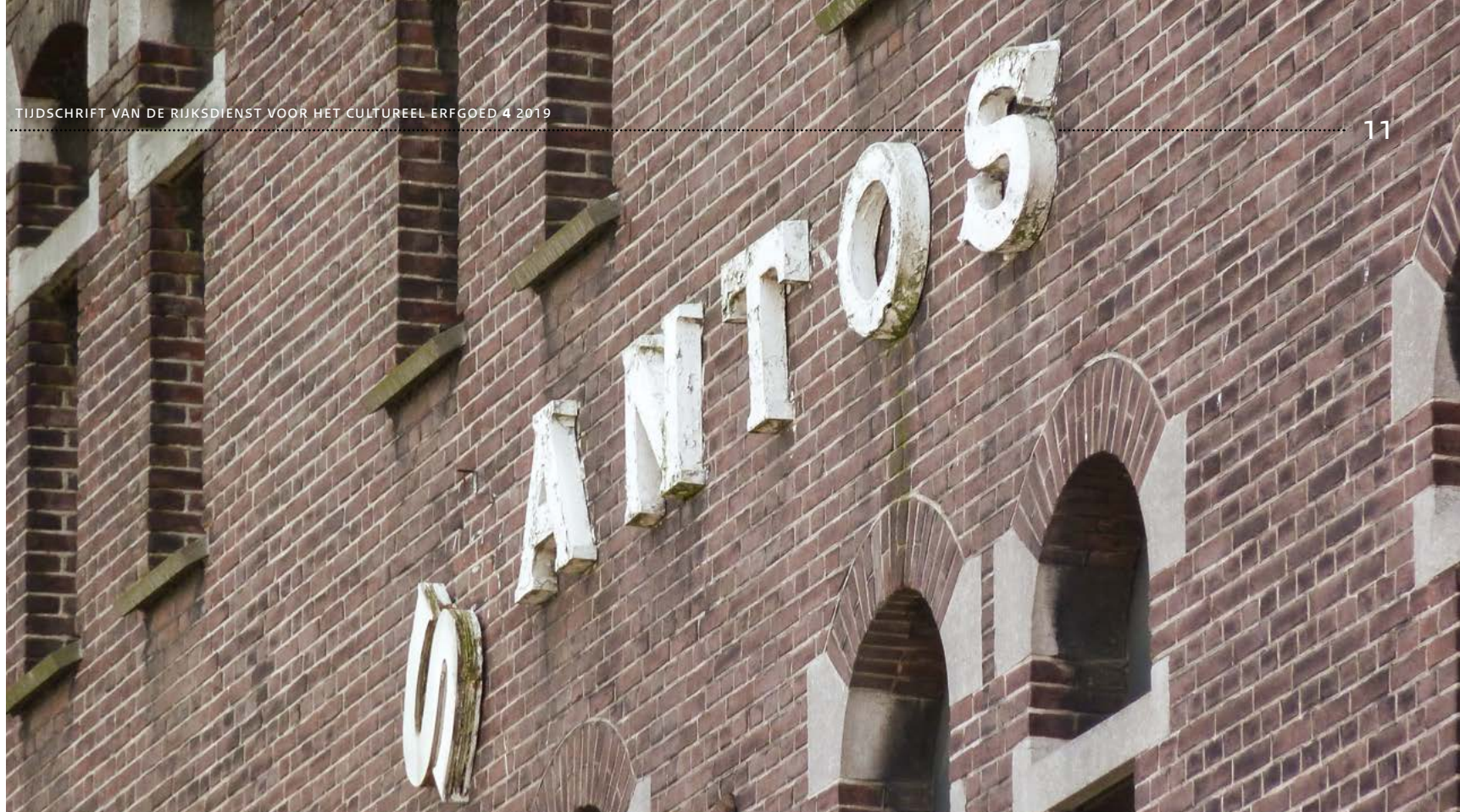
Er komen winkels in koffiepakhuis Santos in de Rotterdamse wijk Katendrecht, gebouwd in 1903 en tegenwoordig een rijksmonument
