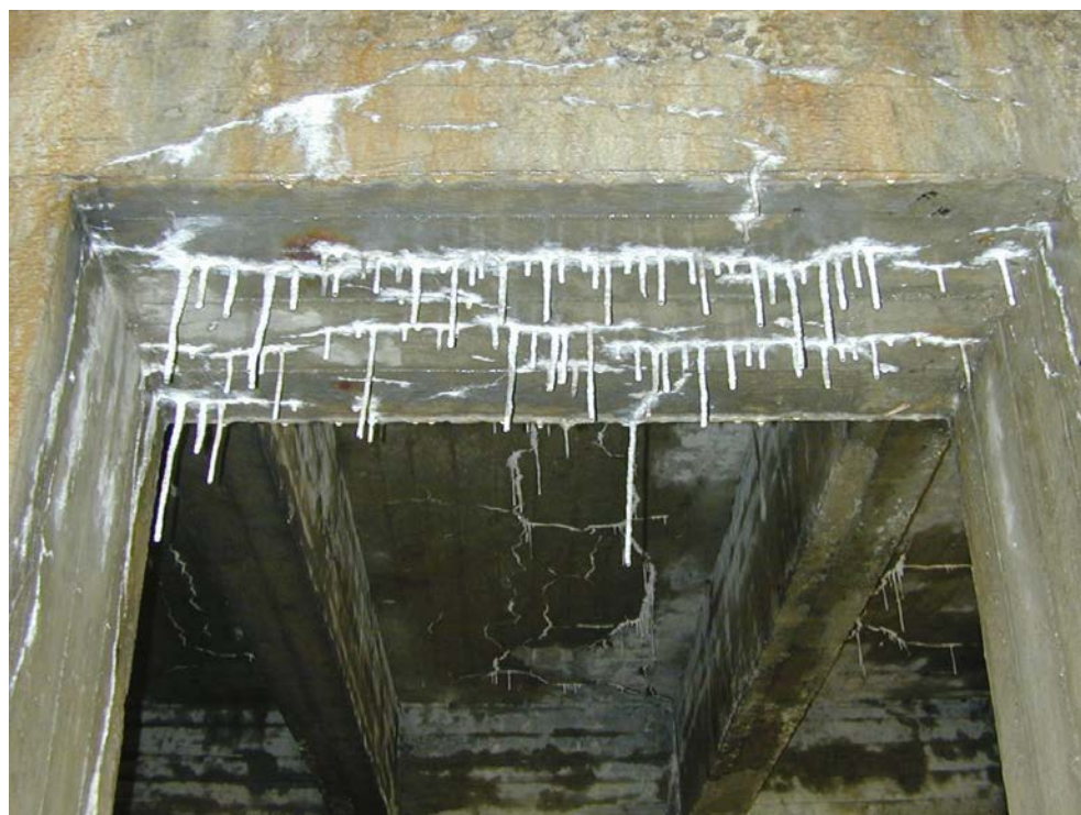
Pegels van uitgeloopte kalk aan beton worden veroorzaakt door scheuren waarin water binnendringt: 'incrustatie'
