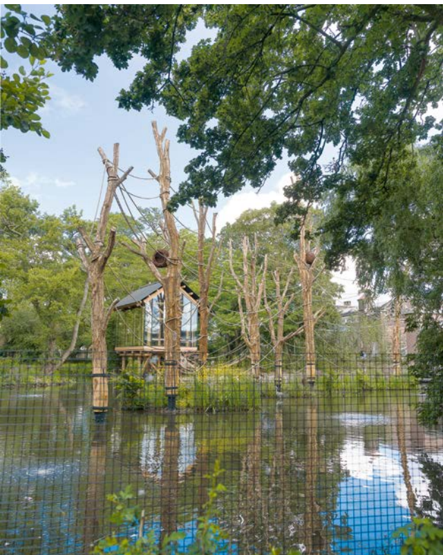
In de monumentale slingervijver is een fossielvrij verwarmd apenverblijf gebouwd
