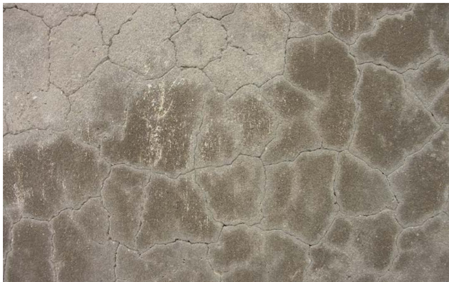
Craquelé in een pleisterlaag komt meestal door te snelle droging of een onjuiste samenstelling
