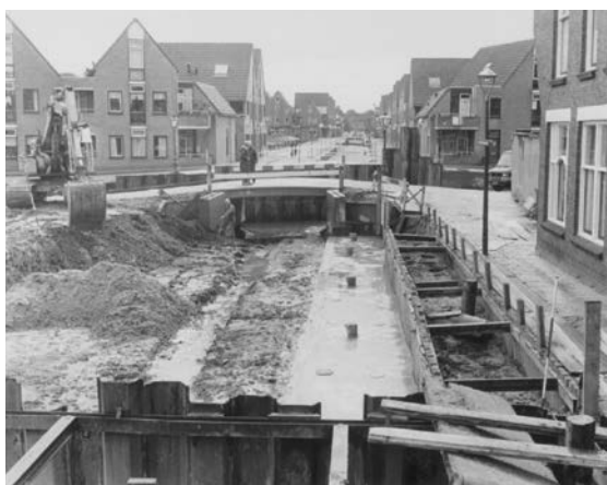
Stadsvernieuwing ging verder dan enkel het (ver)bouwen van woningen, de aanpak van de openbare ruimte was net zo belangrijk. Hier het opengraven van de in 1880 gedempte Minnebroersgracht in Leiden.
