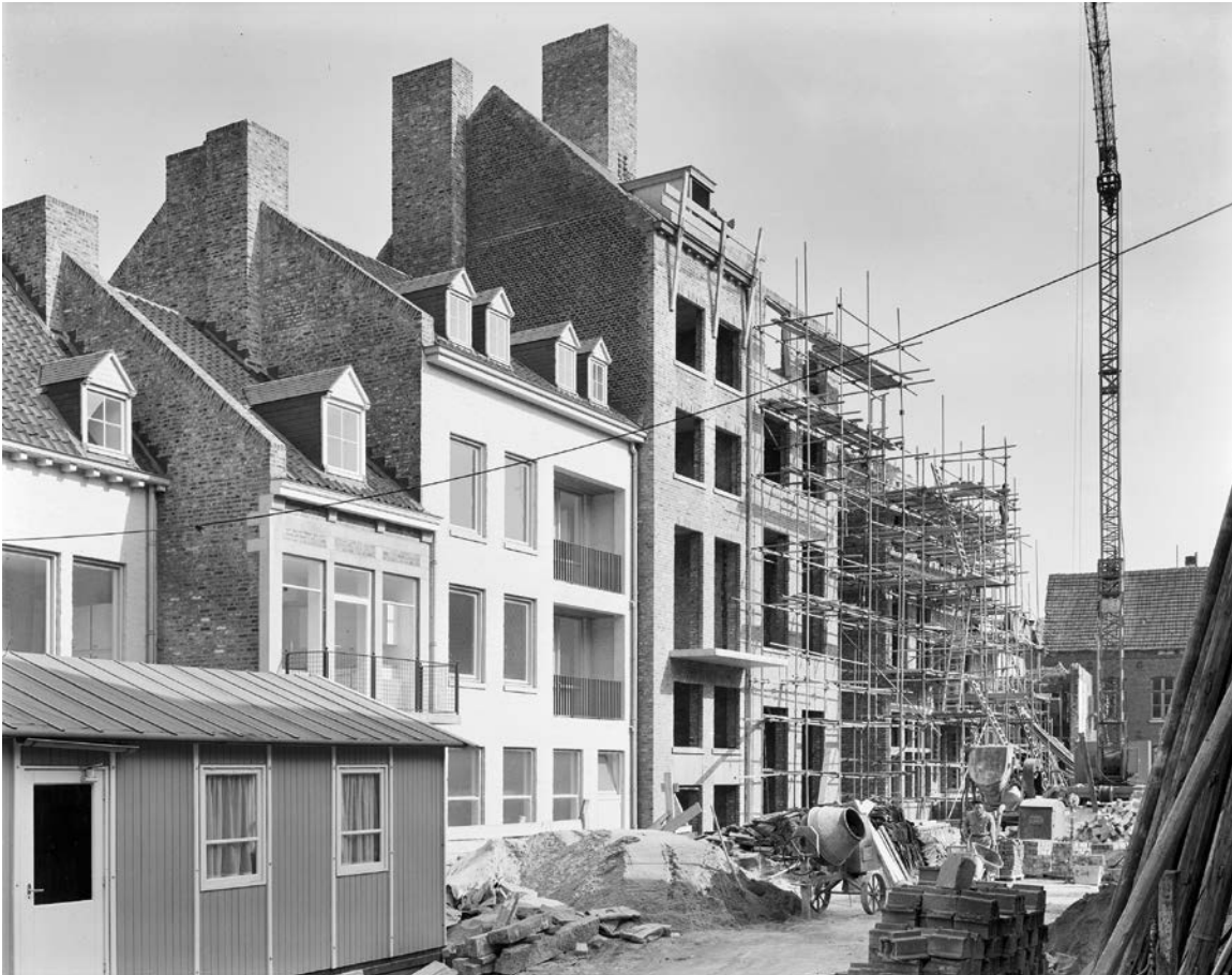
De grondige restauratie van het Stokstraatkwartier in Maastricht beantwoordde sociaal niet aan het ideaal van 'bouwen voor de buurt'. Achterzijde panden Stokstraat tijdens restauratie, 1976.
