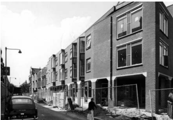
Woningbouwcomplex in de Josephstraat op de plek van een gesloopte kerk, 1978. Stadsarchief Rotterdam
