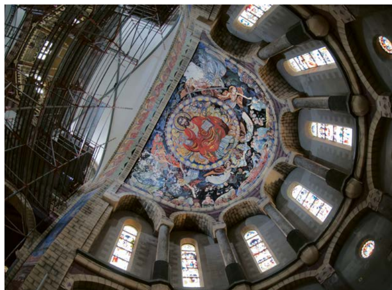
Een van de schilderijen van Jaap Mes in de Lambertuskerk te Maastricht. Tijdens de consolidatiewerkzaamheden heeft men de schilderijen niet afgedekt, waardoor grote schade is ontstaan, verergerd door waterschade en duiven.
