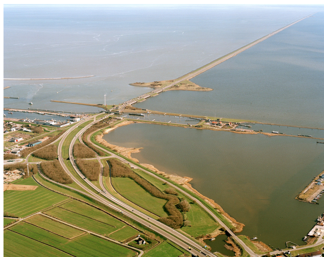
Afb. 3.3 De Afsluitdijk tussen IJsselmeer en Waddenzee is bijvoorbeeld een dam. Beeldbank RCE, foto Chris Booms en Kris Roderburg.
