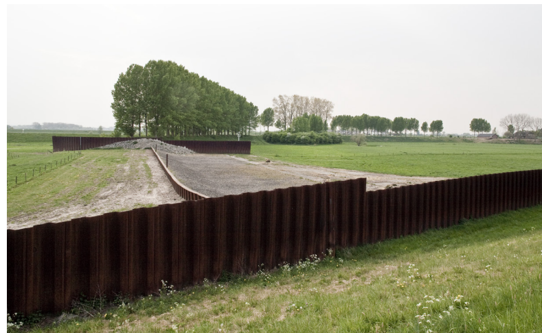
Afb. 3.9 Overlaatlid in de Pannerdense overlaat. In 2014 is deze vervangen door een betonnen constructie die een preciezere regeling van de hoeveelheid doorstroom toelaat. Beeldbank RCE, foto Bert van As.
