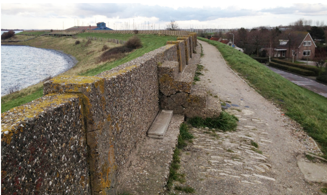
Afb. 3.8 Muraltmuur Scharendijke, Schouwen-Duiveland. Beeldbank RCE.
