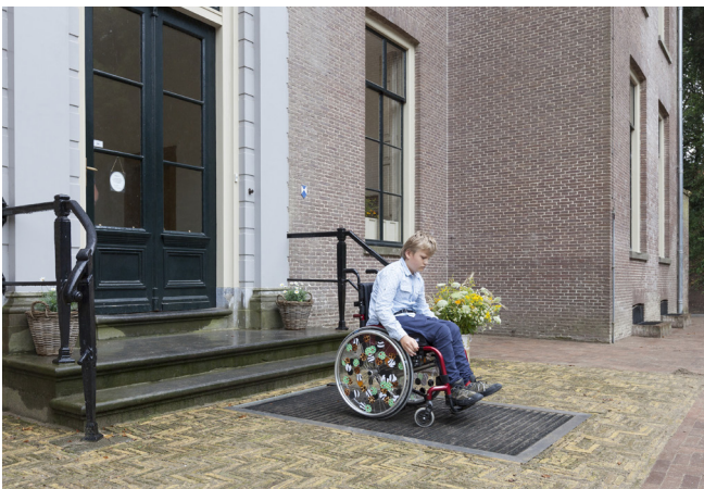
Na gebruik verdwijnt het hefplateau in de ondergrond
