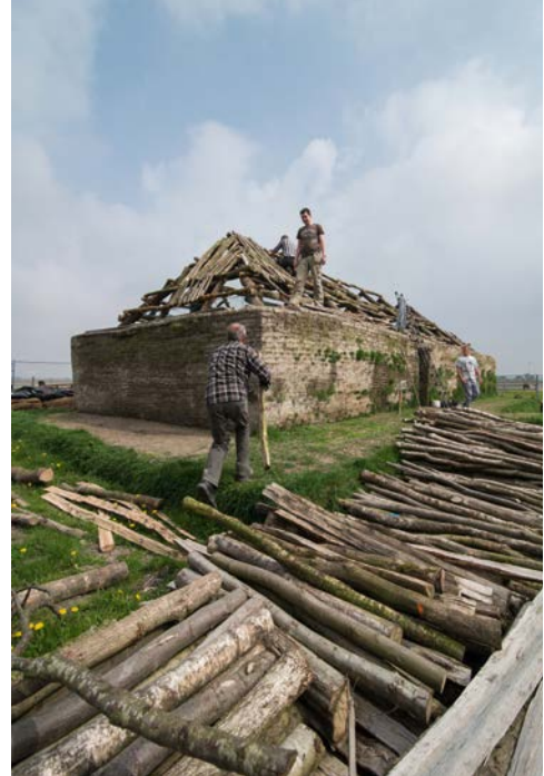
Afb. 2.14 Bouw van het zodenhuis in Firdgum (foto: J. Stöver).
