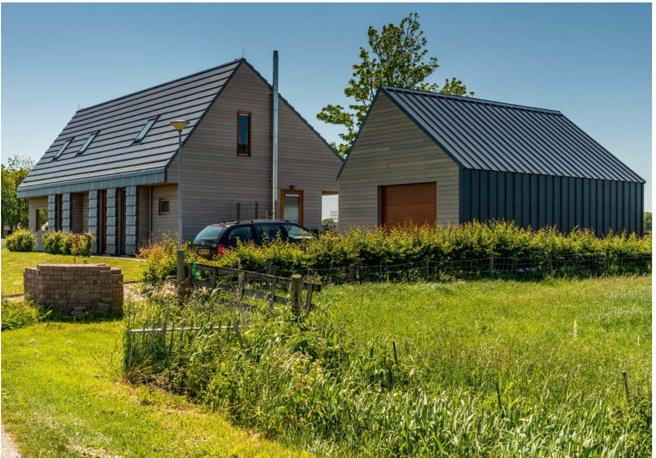
Afb. 4.3 In Anjum werd in vergunning verleend voor de bouw op een archeologisch rijksmonument net buiten de dorpskern van een nieuwe woning ter plekke van een kleine en sterk vervallen dienstwoning. Omdat de initiatiefnemer voorafgaande aan de vergunningaanvraag al had geïnformeerd naar de mogelijkheden voor bouwen op dit rijksmonument, was het mogelijk om voorafgaande aan het ontwerp vanuit de archeologie randvoorwaarden mee te geven. Het resultaat was een ontwerp met een lichte fundering op staal, zodat kon worden volstaan met een opstand in houtskeletbouw. De strokenfundering werd rondom de fundamenten van de gesloopte dienstwoning gelegd, zodat de fundering hiervan niet hoefde te worden uitbroken (foto: J. Stöver).
