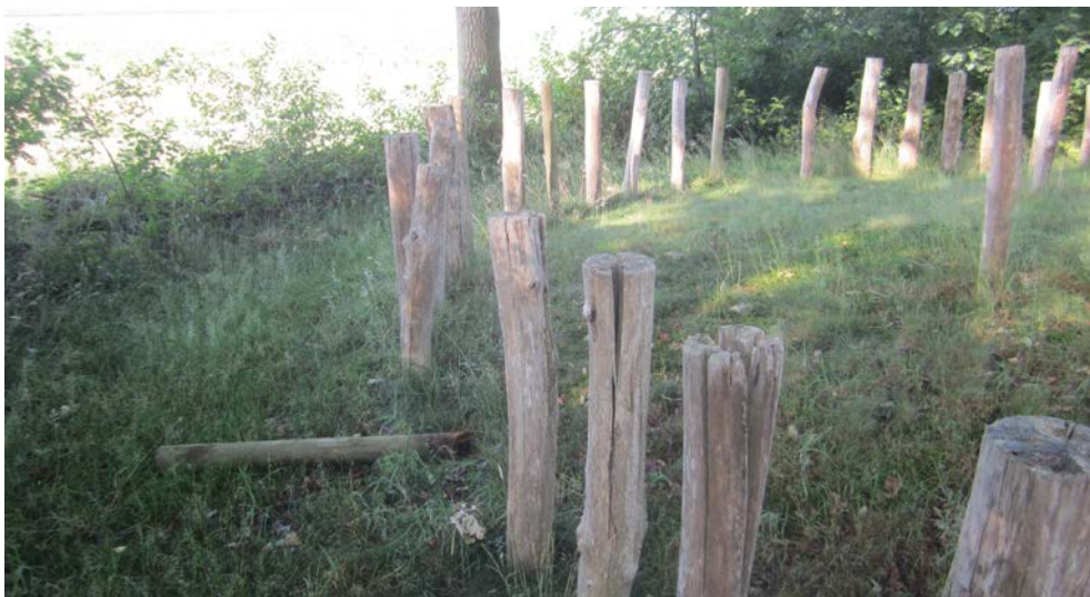
Afb. 1.2 Het hout van de paalkrans van heuvel 16 is duidelijk aangetast. Een groot aantal van de palen is gespleten en met name rond het contactvlak, de zone van de lage begroeiing en de bodem, verrot (foto: F. Kortlang, 6 juli 2015).
