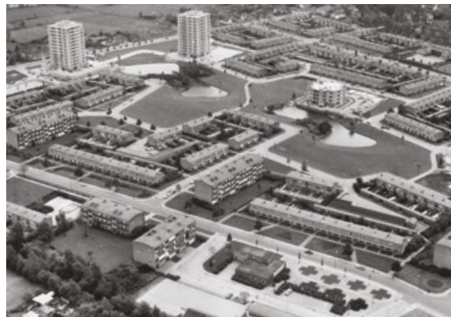
Kerschoten in aanbouw
