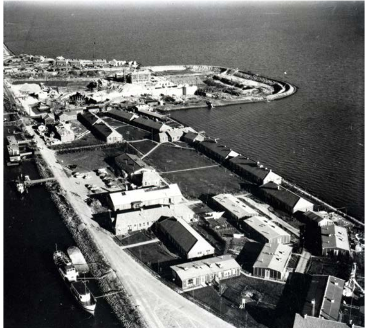
Afb. 30 De nieuwe stad Lelystad in aanbouw. Beeldbank RWS.
