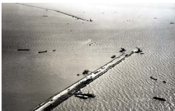
Afb. 29 De bouw van de Knardijk. Beeldbank RWS.
