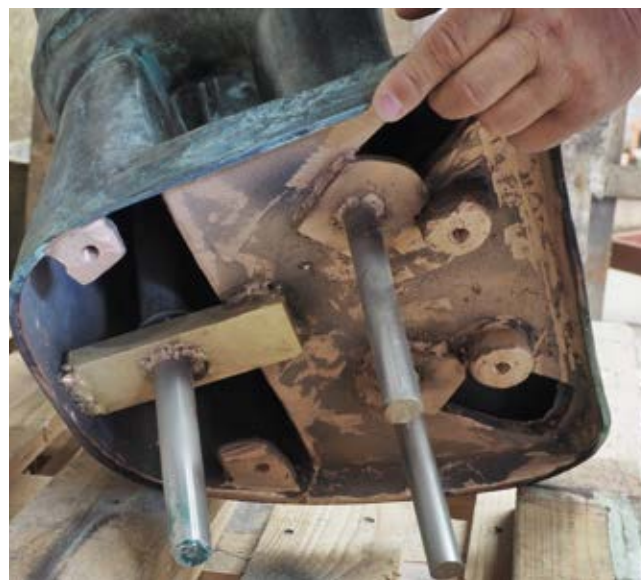
Een bronzen buitenbeeld wordt met stalen, roterende staven aan de sokkel vastgezet
