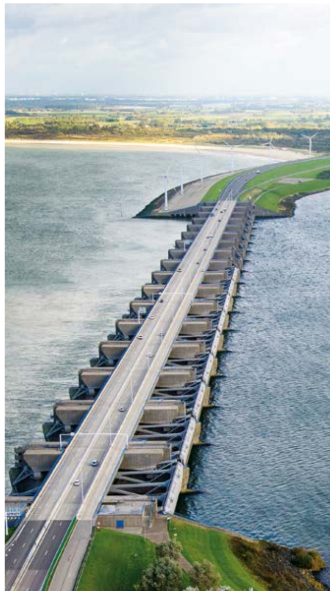
De Haringvlietsluizen maken deel uit van de Haringvlietdam
