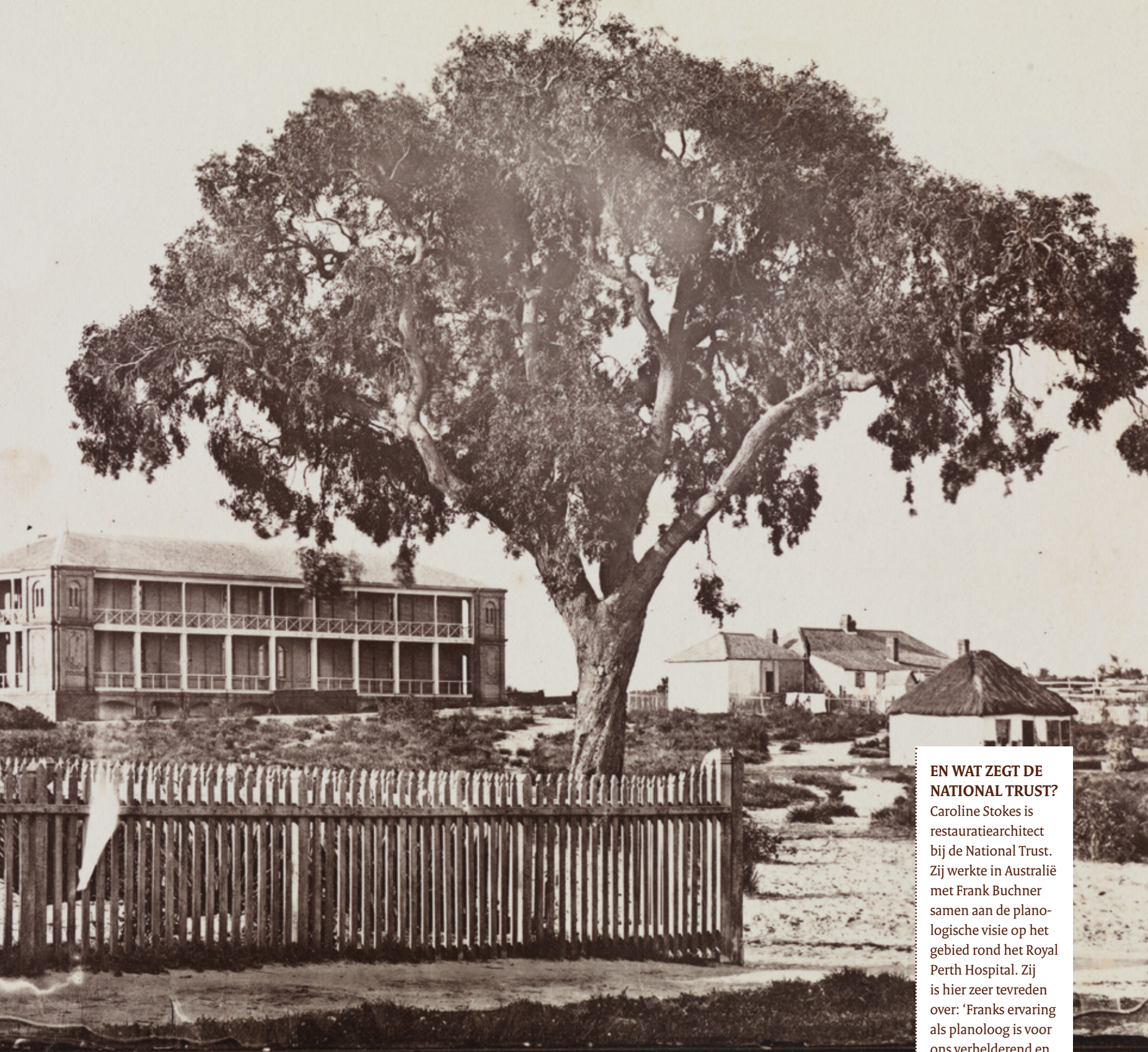
Het Royal Perth Hospital niet lang na de bouw in 1855
