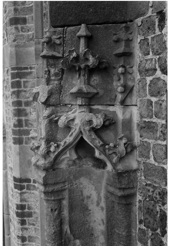
Foto's van voor de restauratie in de jaren vijftig van de vorige eeuw tonen de middeleeuwse hogels, die uitgevoerd waren in Bentheimer zandsteen. Besloten is in 2008 om dit steen- en beeldhouwwerk opnieuw uit te voeren in Bentheimer zandsteen (in plaats van Baumberger steen) en daarbij de middeleeuwse hogels als uitgangspunt te nemen voor het nieuw te maken beeldhouwwerk. Foto: RCE
