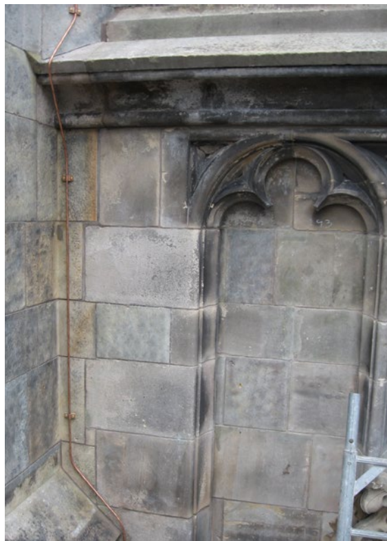
Een aantal blokken in deze zandstenen gevel van de Sint-Jan in Den Bosch zijn vervangen door verse steen en ingekleurd, zodat ze niet afsteken bij de omgeving. Foto: H.J.Tolboom 2014
