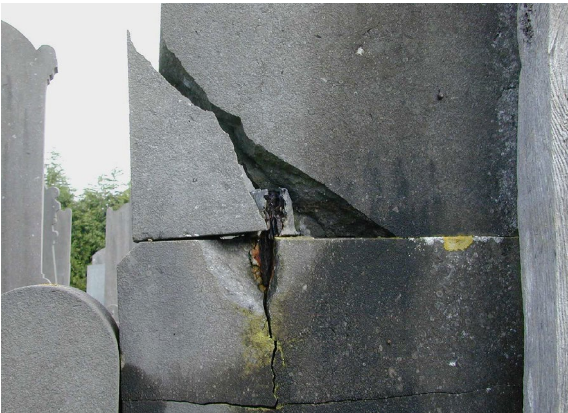
Hardstenen zerk op de Joodse begraafplaats in Katwijk. Roestende doken die opgesloten zitten in de steen, veroorzaken vaak ernstige schade.
