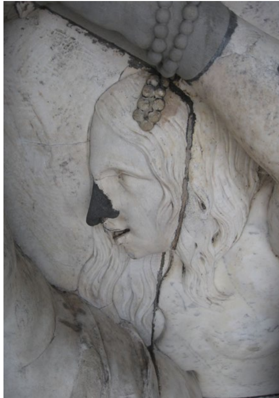
Hetzelfde gedeelte van het timpaan na reiniging. Oude reparaties komen aan het licht en steken af bij gereinigd steen. Foto: H.J.Tolboom 2011
