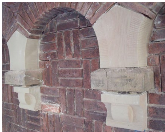
De slechte blokken Udelfanger zandsteen zijn vervangen door dezelfde steen, die dezelfde vorm en afwerking heeft gekregen als het origineel. Foto: Meesters In 2010
