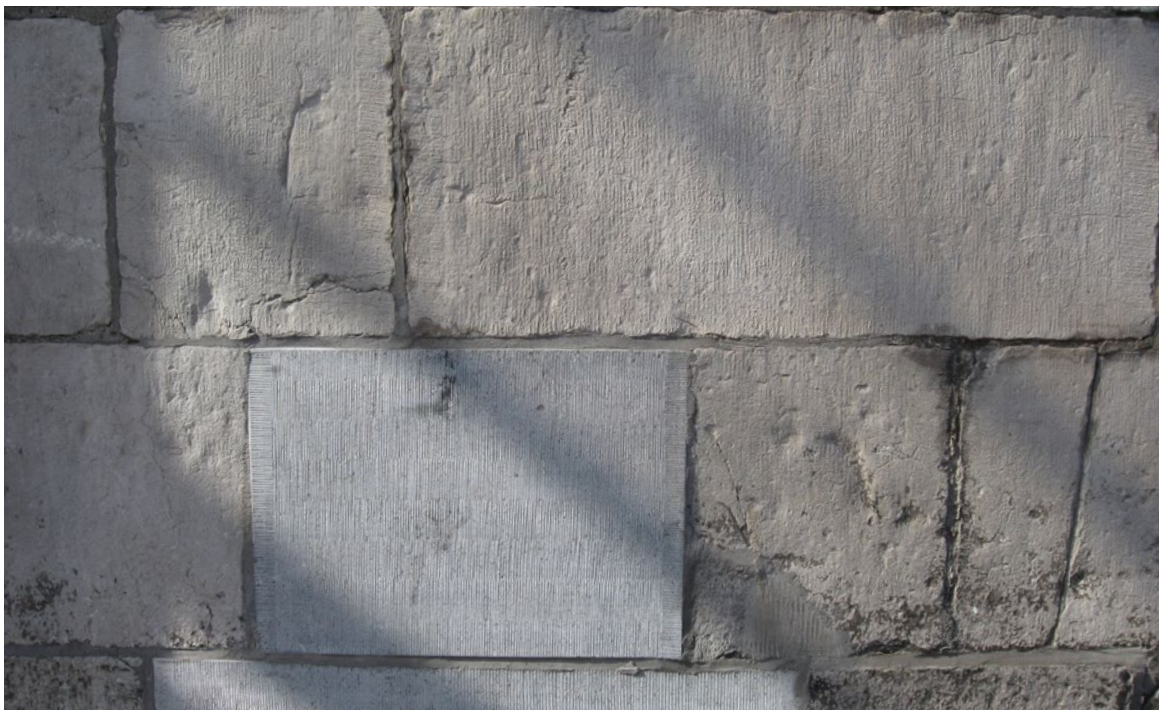
Bij het stadhuis van Maastricht zijn blokken Calcaire de Meuse vervangen door Ierse hardsteen. De oude blokken waren met de hand voorzien van rechte
