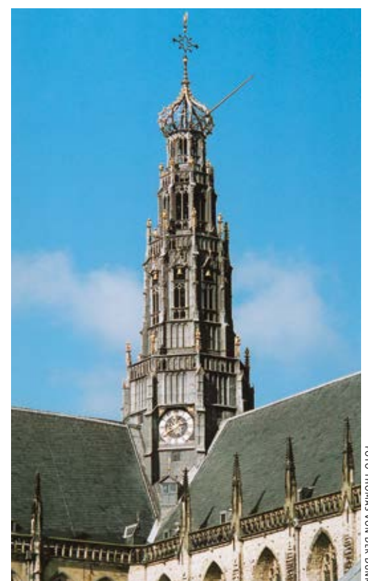
De vieringtoren van de Bavokerk in Haarlem kreeg een open beugelbekroning in hout
