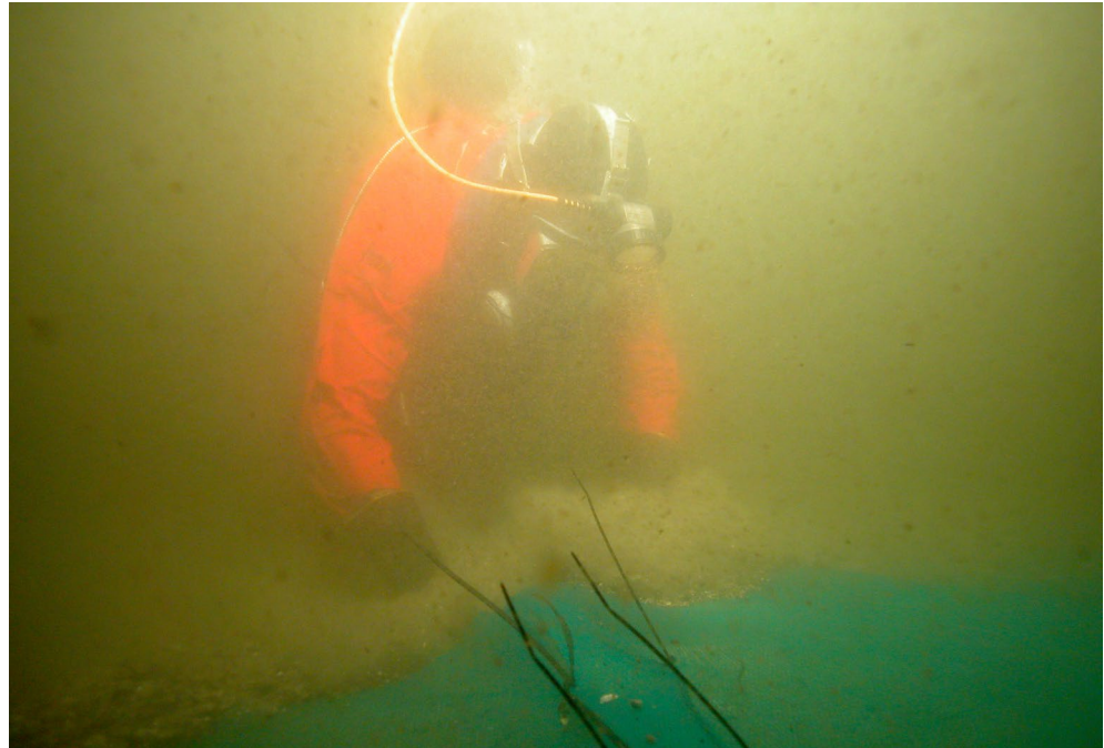
Afb.13: Duiker aan het werk om zand door het gaas te kloppen of te schudden (foto RCE).
