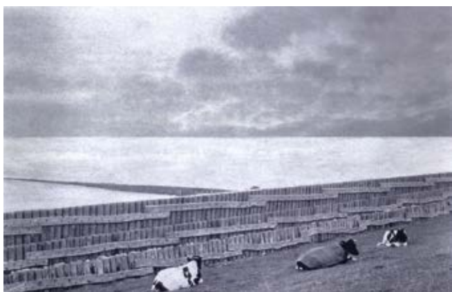
Paalschermen in drie lagen als extra bescherming van de dijk nabij Makkum rond 1935 (collectie Mar en Klif).
