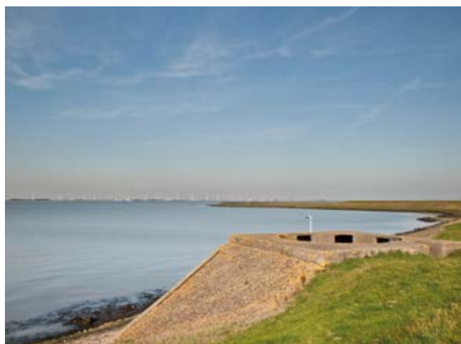
Betonnen affuit voor het luchtafweerkanon aan de buitenkant van de Eemsdijk te Fiemel ten oosten van Termunten (wikimedia) onderdeel van de Atlantikwall.
