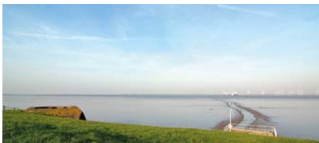
Blik over de Dollard bij Fiemel met links op de voorgrond de betonnen affuit van het FLAG geschut uit WOII en rechts het gemaal bij Fiemel met de spuigeul. Op de achtergrond de windmolens bij Emden (Duitsland).
