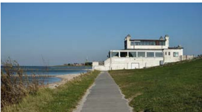
Badpaviljoen aan de buitenrand van de IJsselmeerdijk ten zuiden van Hindelopen.
