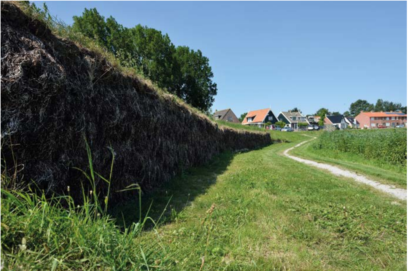
Experiment aanleg wierpakket tegen de wierdijk aan bij De Haukes op Wieringen.
