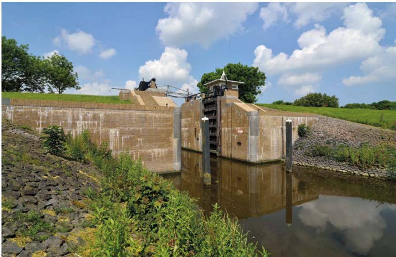
Sluiscomplex bij Ezumazijl aan de voormalige Lauwerszee.
