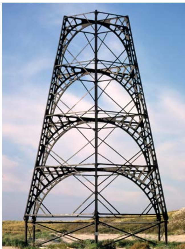
Emder kaap uit 1883 op het eiland Rottumeroog. Deze gietijzeren kaap is ontworpen door Quirinius Harder en A.C. van Lo. Vanwege kustafslag is de kaap in 1999 verplaatst. Beeldbank Rijkswaterstaat (Foto: Rob Jungcurt).
