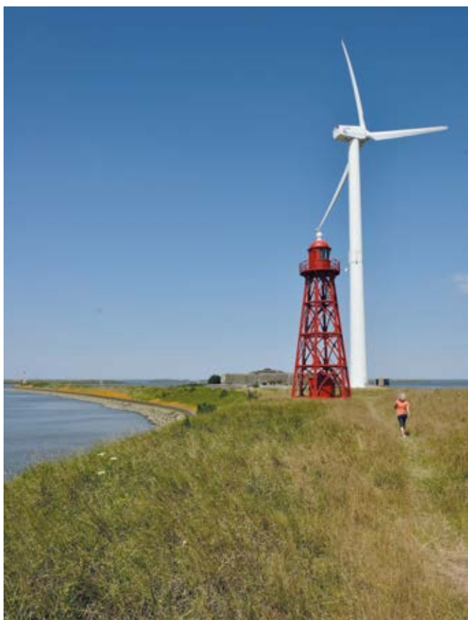
Gietijzeren vuurtoren langs de Afsluitdijk bij Den Oever. Oorspronkelijk afkomstig van de plaats De Haukes op Wieringen.
