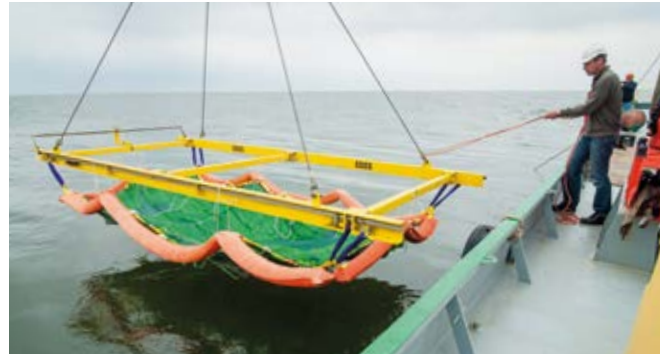
Het afdekkingsmateriaal wordt te water gelaten (foto: Paul Voorthuis/Highzone fotografie).
