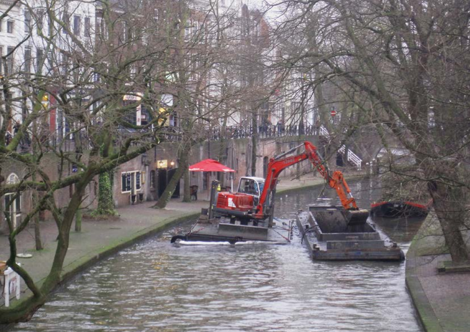
Onderhoudsbaggerwerkzaamheden in de Oude Gracht te Utrecht (foto: ODRU).
