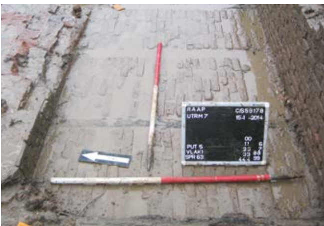
Bodem van een 18 e eeuwse sluis onder de veerweg bij Vianen (foto: RAAP).
