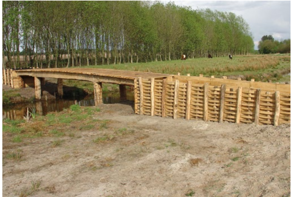
Afb. 15.7 De gereconstrueerde brug (foto E. Rensink).
