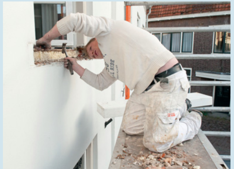
Onderhoud van een rijksmonument: de waterdorpel wordt vervangen
