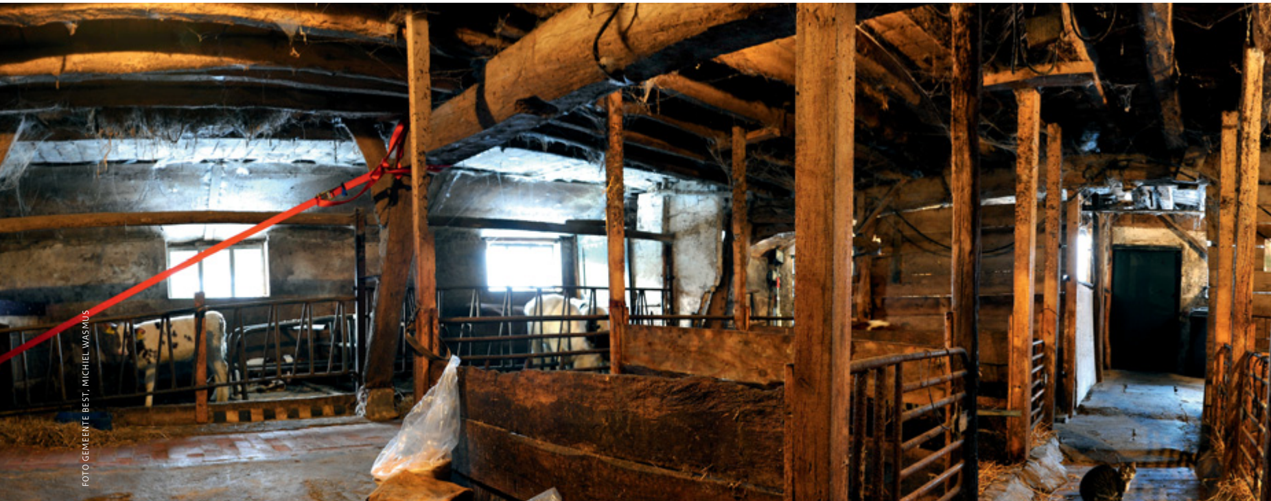
De houten constructie van de Armenhoeve in Best is de oudste van Nederland
