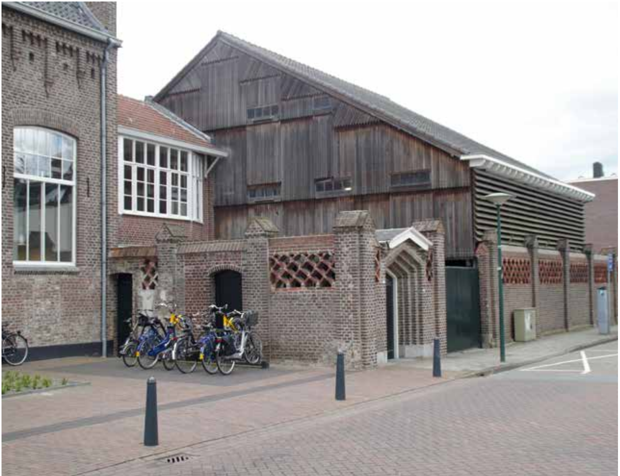
Afb. 53 Houtloods gebouwd circa 1880 achter het atelier van gewijde beeldhouwkunde van de firma P.J.H. Cuypers en. F.C. Stoltzenberg te Roermond.
