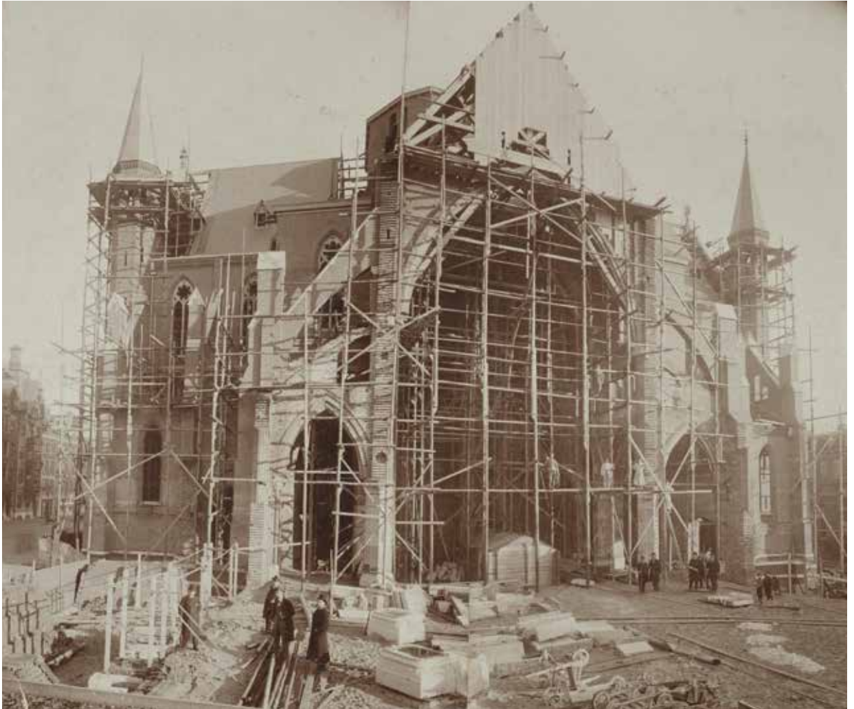
Afb. 145 Foto van de St.-Willibrorduskerk buiten de Veste te Amsterdam tijdens de bouw in 1871 met zicht op een deel van een verder afgetimmerd kaspant.
