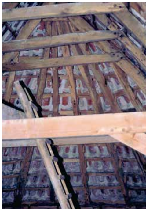
Afb. 11 Koorgedeelte van de onbeschoten sporenkap van de hervormde kerk in Marsum, dendro- chronologisch gedateerd in 1306.
