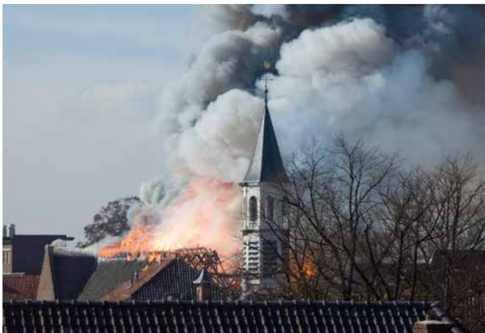
Afb. 217 Brand in de Amersfoortse Elleboogkerk op 22 oktober 2007 waarbij kap en dakruiter geheel verloren gingen.
