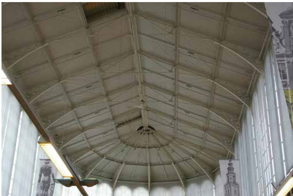
Afb. 209 Deel van de kap- constructie van de Groninger Korenbeurs uit 1865 met gietijzeren 'korbelen' ter verkor- ting van het gebruikte Polonceauspant.
