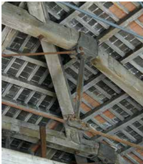
Afb. 136 Detail van een Polonceauspant uit circa 1880 in een gebouw in het Arsenal in Venetië met verticaal de dikkere gietijzeren drukstaaf en horizontaal de ronde stalen trekstaven. Hier is nog gebruik gemaakt van houten kapspruiten.
