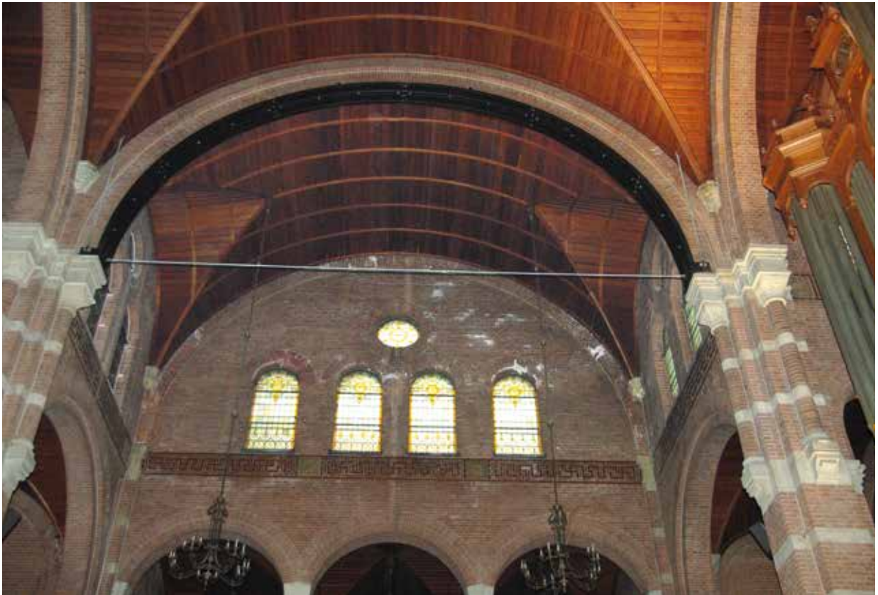
Afb. 113 Deel van het houten kruisgewelf van de remonstrantse kerk te Rotterdam.
