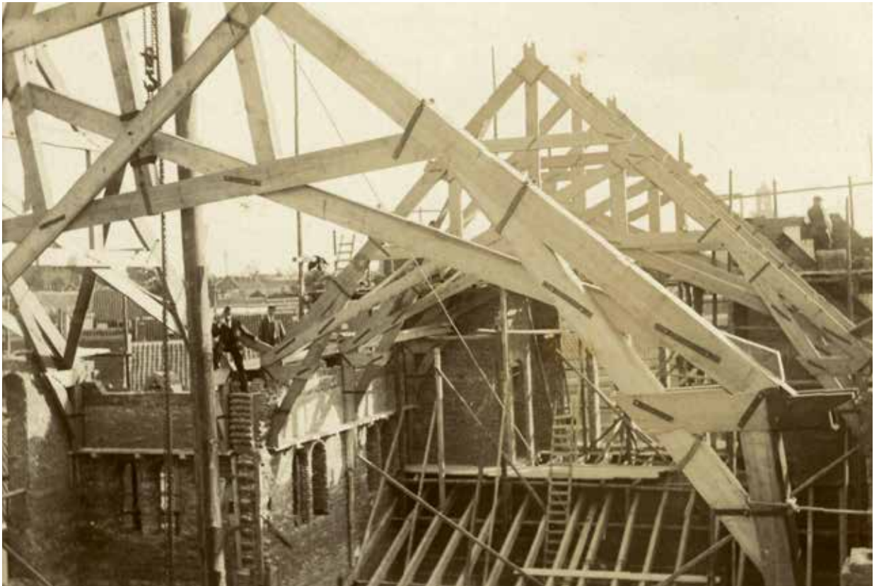
Afb. 220 Foto met een overzicht van de kapspanten tijdens de bouw van de hervormde Nieuwe Kerk te Utrecht met op de voorgrond één van de spanten die opgehesen wordt.
