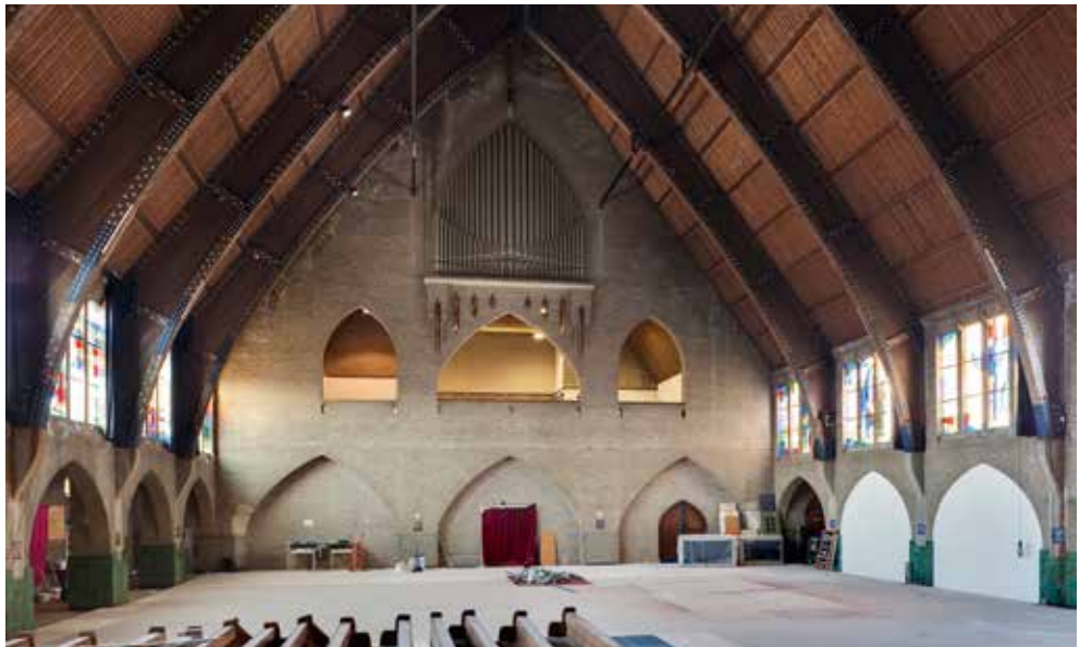
Afb. 153 Interieur van de O.L. Vrouwe van Lourdes te Scheveningen uit 1927 naar ontwerp van C.M. van Moorsel met betimmerde betonnen driescharnierspanten afgezet met stalen strips.
