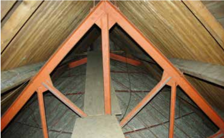
Afb. 155 Detail van een stalen kapspant in de kap van de St.-Petrus' Stoel van Antiochië-kerk te Berlicum met een stalen framework met daarop steengas voor het aanbrengen van de stuclaag.
