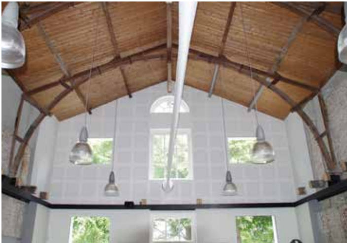
Afb. 134 Interieur van de voormalige handweverij te Zierikzee uit 1839 met op de verdieping een Emyspant.
