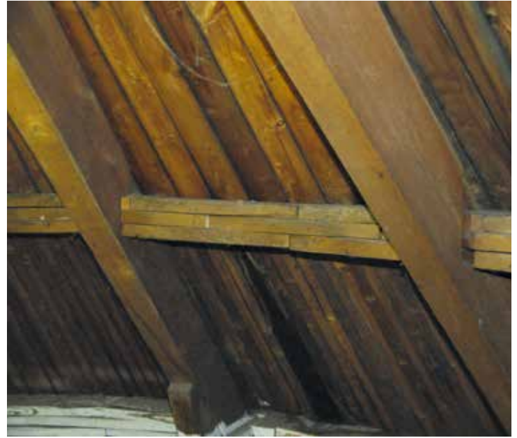
Afb. 132 Deel van de Philibert-constructie van het bijgebouw van kasteel Beverweert uit circa 1855, halverwege verbonden door trekstangen.
