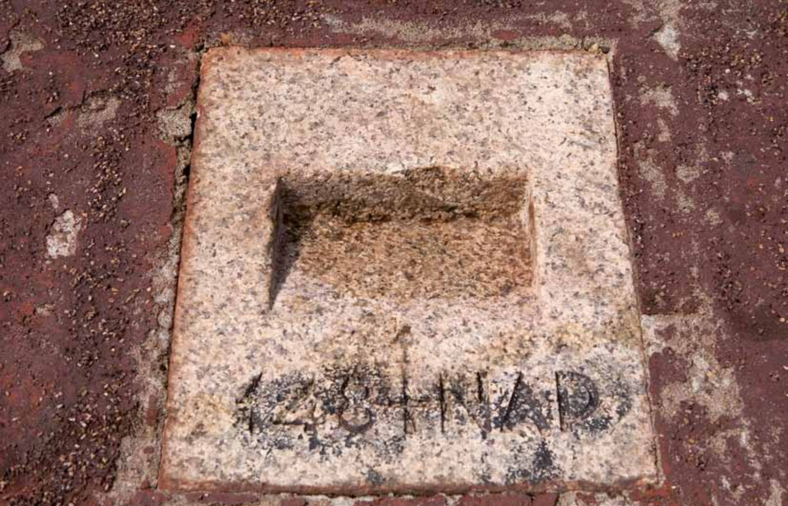
Een peilsteen in de gevel geeft de hoogte weer ten opzichte van het Normaal Amsterdams Peil. Ooit functionele informatie, nu vooral een karakteristiek detail.
