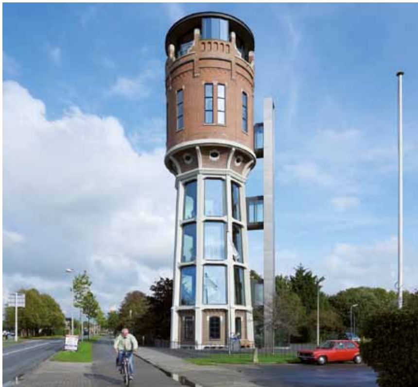
Bij de herbestemming tot kantoor (2003) is glas in de oorspronkelijk open draagconstructie van de watertoren geplaatst. Hazerswoude-Rijndijk, Rijndijk 127.
