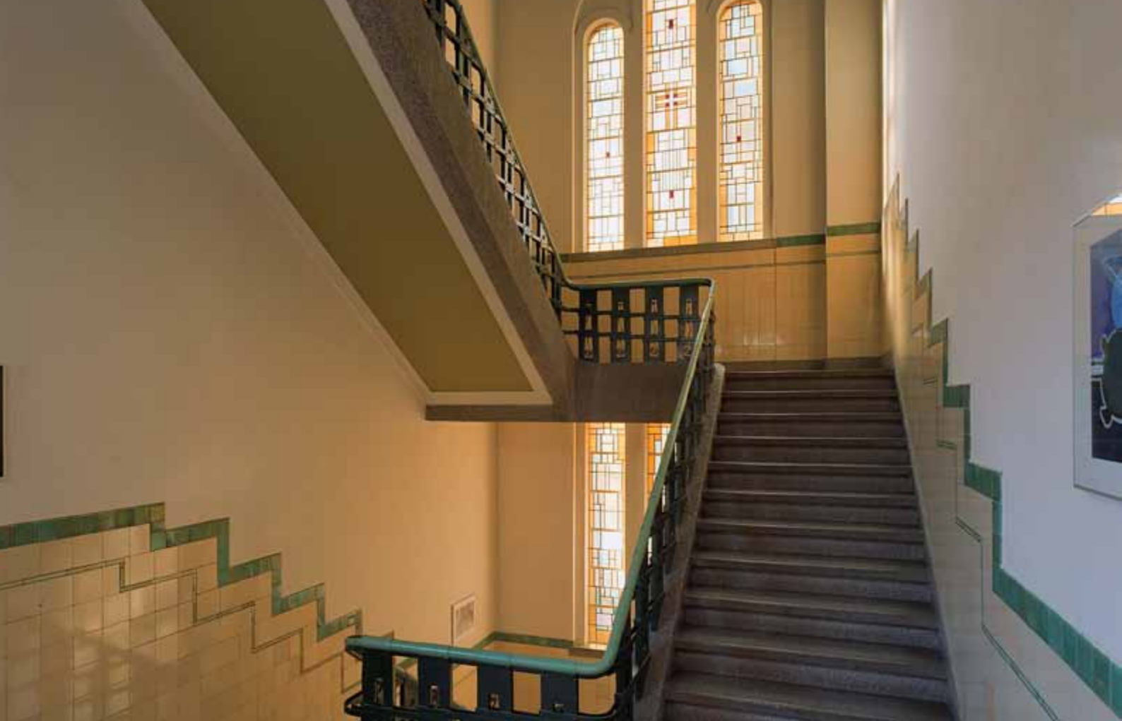
Het trappenhuis is verzorgd en met duurzaam materiaal uitgevoerd: houten traptreden, betegeld bordes met dito lambrisering en een drielichtsvenster met glas-in-lood dat zorgt voor de toetreding van daglicht. Eindhoven, Aalsterweg 289, klooster Eikenburg.
