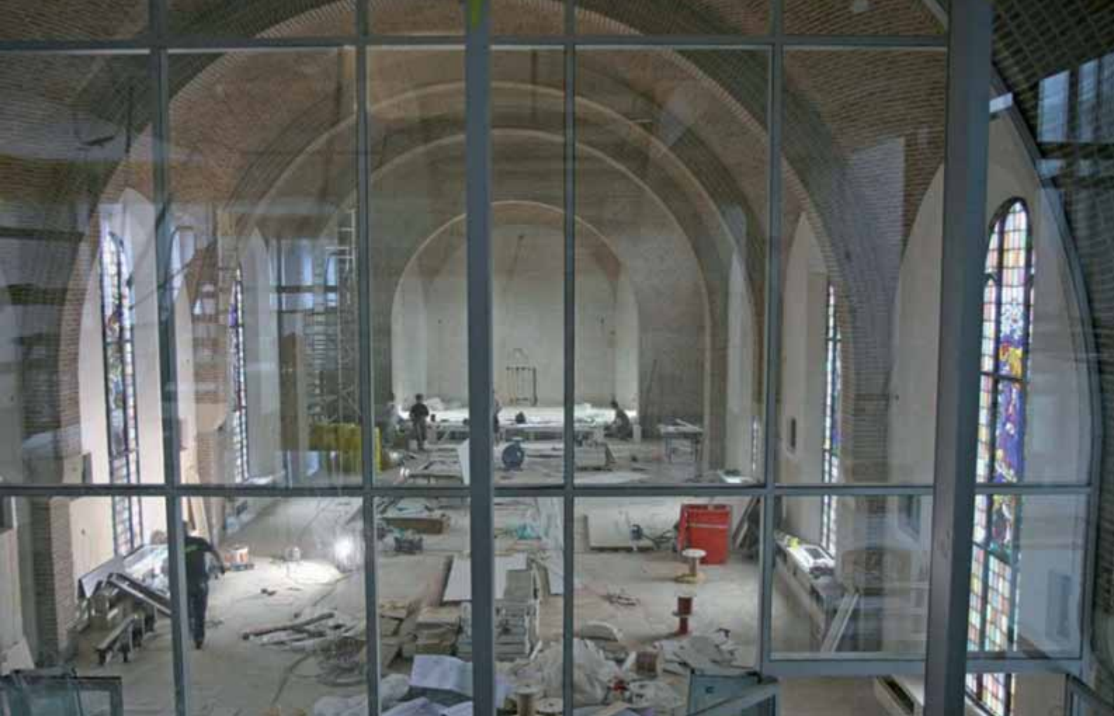
Het klooster Jeruzalem in Venray werd in 1970 verbouwd tot gemeentehuis en in 2012 volledig gerenoveerd.
