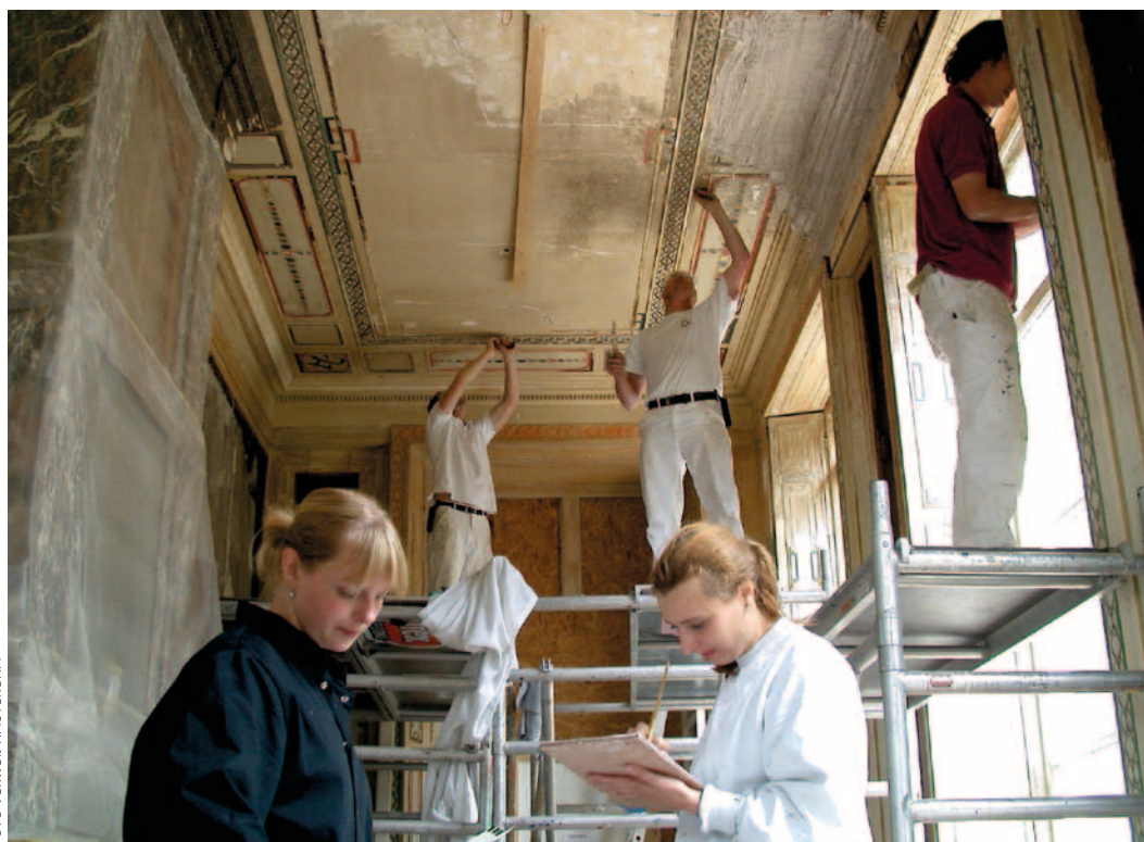
Het verwijderen van loodwitverf kan beter tot een minimum beperkt worden. Het mooie is dat we op die manier het historische materiaal op zijn plek behouden
