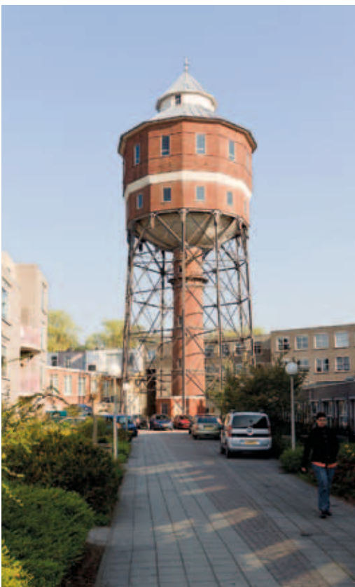
De watertoren aan de Noorderbinnensingel in Groningen gaat tot auditorium verbouwd worden
