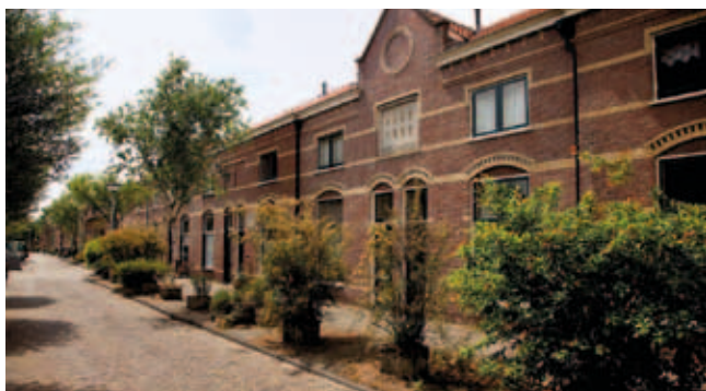
Fatsoenlijke arbeiderswoningen in de Gerrit Doustraat in Vreewijk
