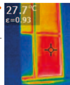
Zichtbaar gemaakte warmtewinst door folie
