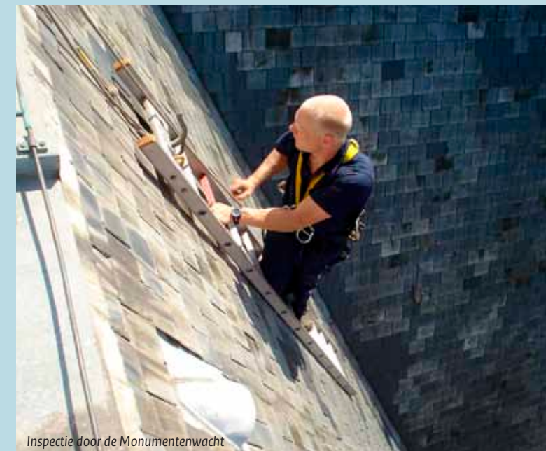
Inspectie door de Monumentenwacht
