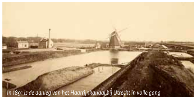
In 1891 is de aanleg van het Haarrijnkanal bij Utrecht in volle gang
