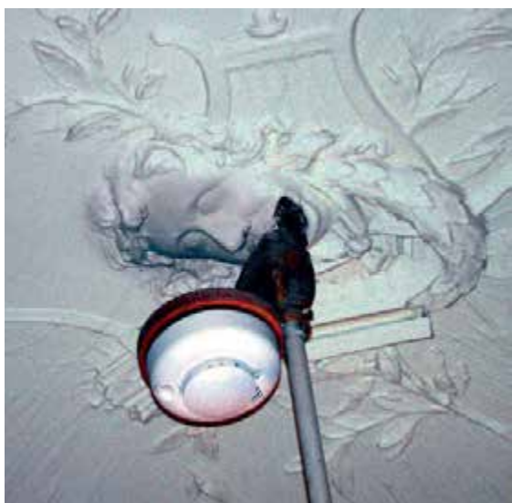
6. Soms laat het respect wat te wensen over. Onder een fraai achttiende-eeuws middenornament van een stucplafond is op weinig subtiel wijze een rookmelder gemonteerd (foto RCE, Taco Hermans 2001)
