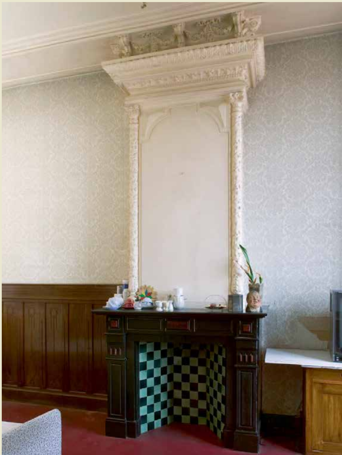
Steenwijk, Markt 24. Gestuukte schouwpartij met marmeren schoorsteenmantel in de kamer-en-suite op de eerste verdieping, 1900 (foto RCE 2006)
