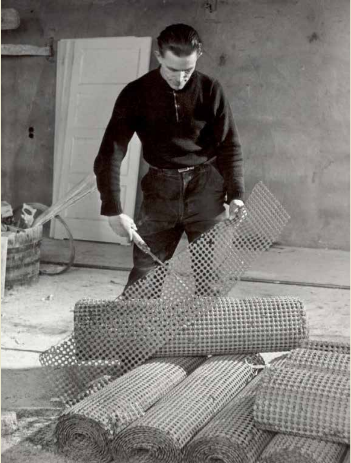
Een stukadoor bezig met het knippen van steengaas (Spaarnestad Fotoarchief 1953)
