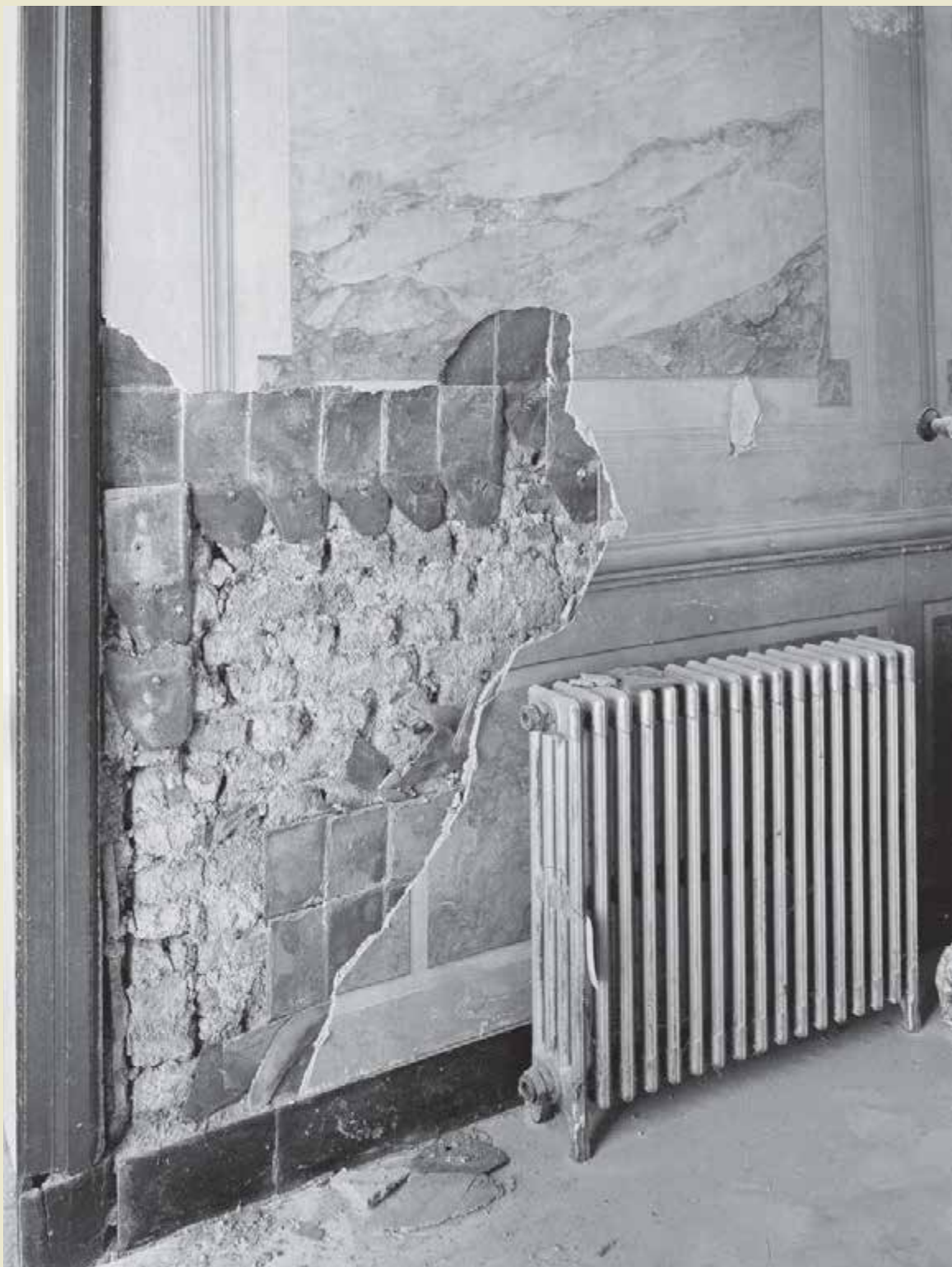
Maastricht, Klooster van de zusters Reparatricen. Achter het zwaar beschadigde pleisterwerk met een geschilderde marmerimitatie bleek een betegeling schuil te gaan (foto RCE 1974)
