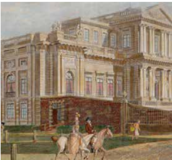
9. Paviljoen Welgelegen in Haarlem vanuit het zuidwesten, detail; links de gevel aan de Dreef (west), en rechts de gevel aan de Haarlemmer Hout (zuid), 1792, B.R. Comte naar H.P. Schouten (Noord-Hollands Archief)
