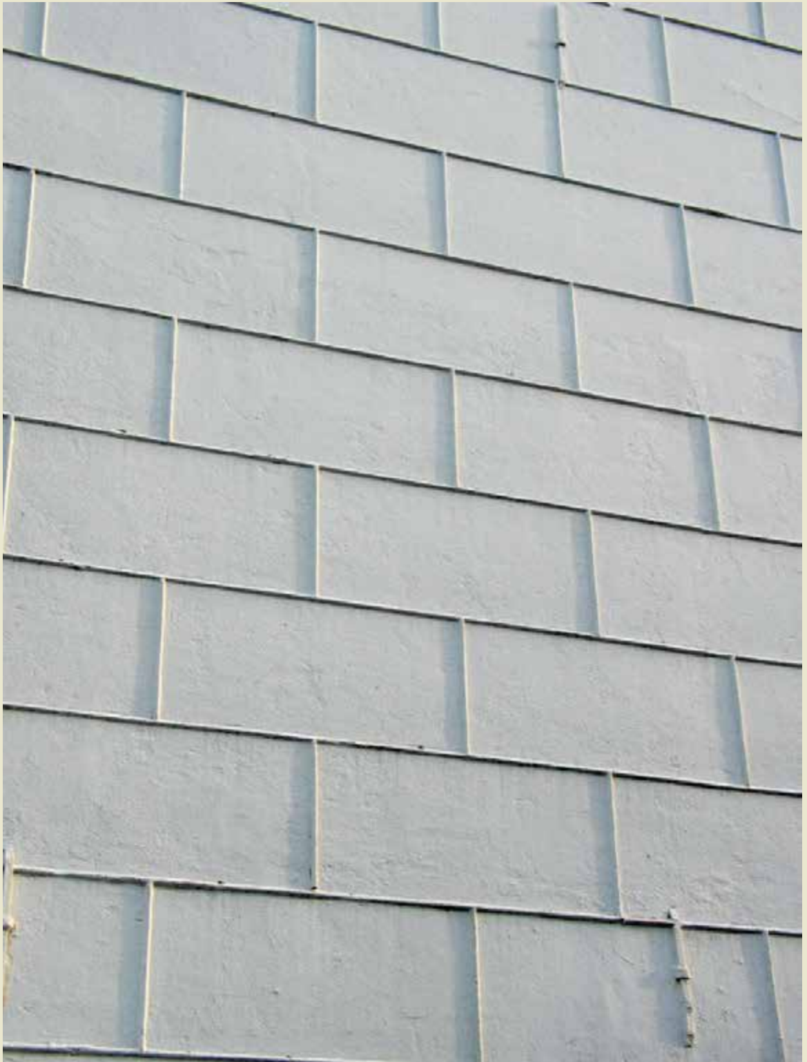
Wageningen, Junusstraat 41. Detail van de gepleisterde gevel met opliggende schijnvoeg, vroeg twintigste eeuw (foto B. van Aller 2010)
