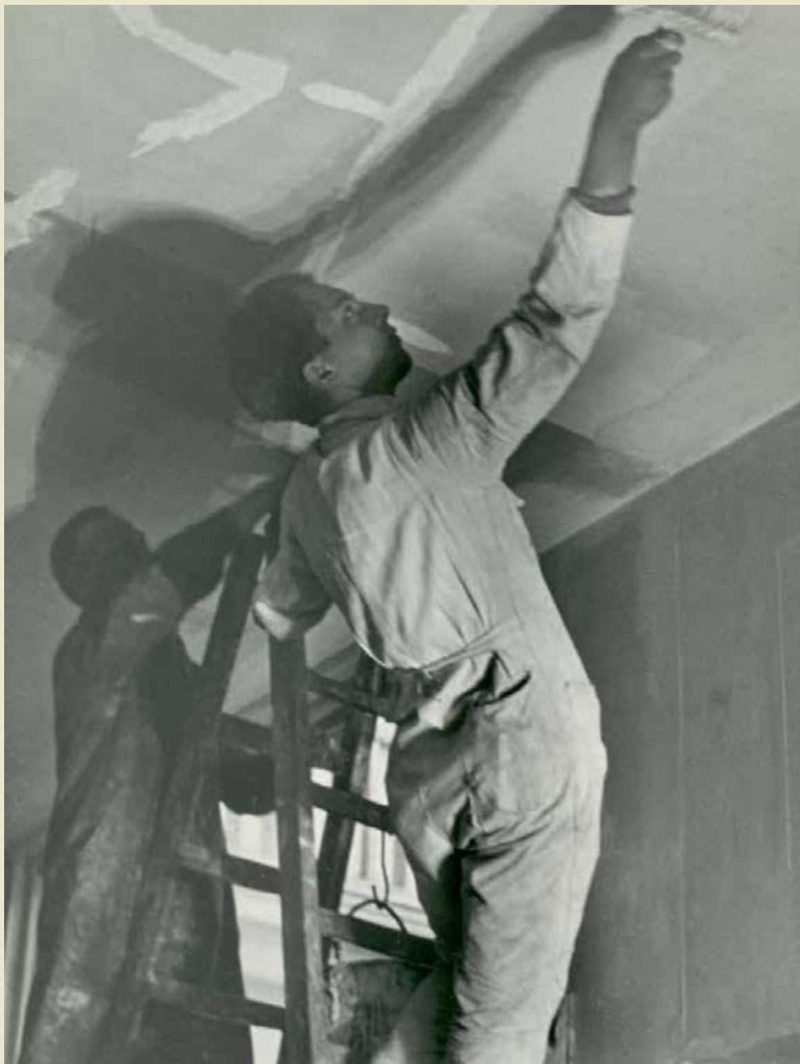
Een huisschilder bezig met het witten van een plafond (foto Gemeentearchief Rotterdam, Henri Berssenbrugge 1930-1940)
