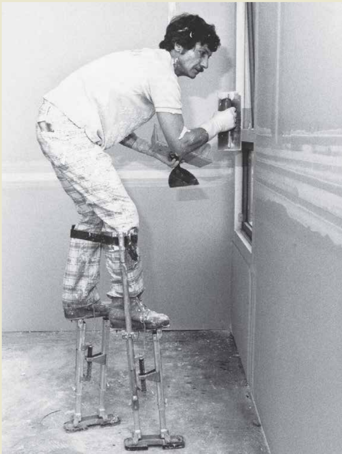
Stukadoor bezig met het dichten van naden tussen de gipsplaten (Spaarnestad Fotoarchief 1980)
