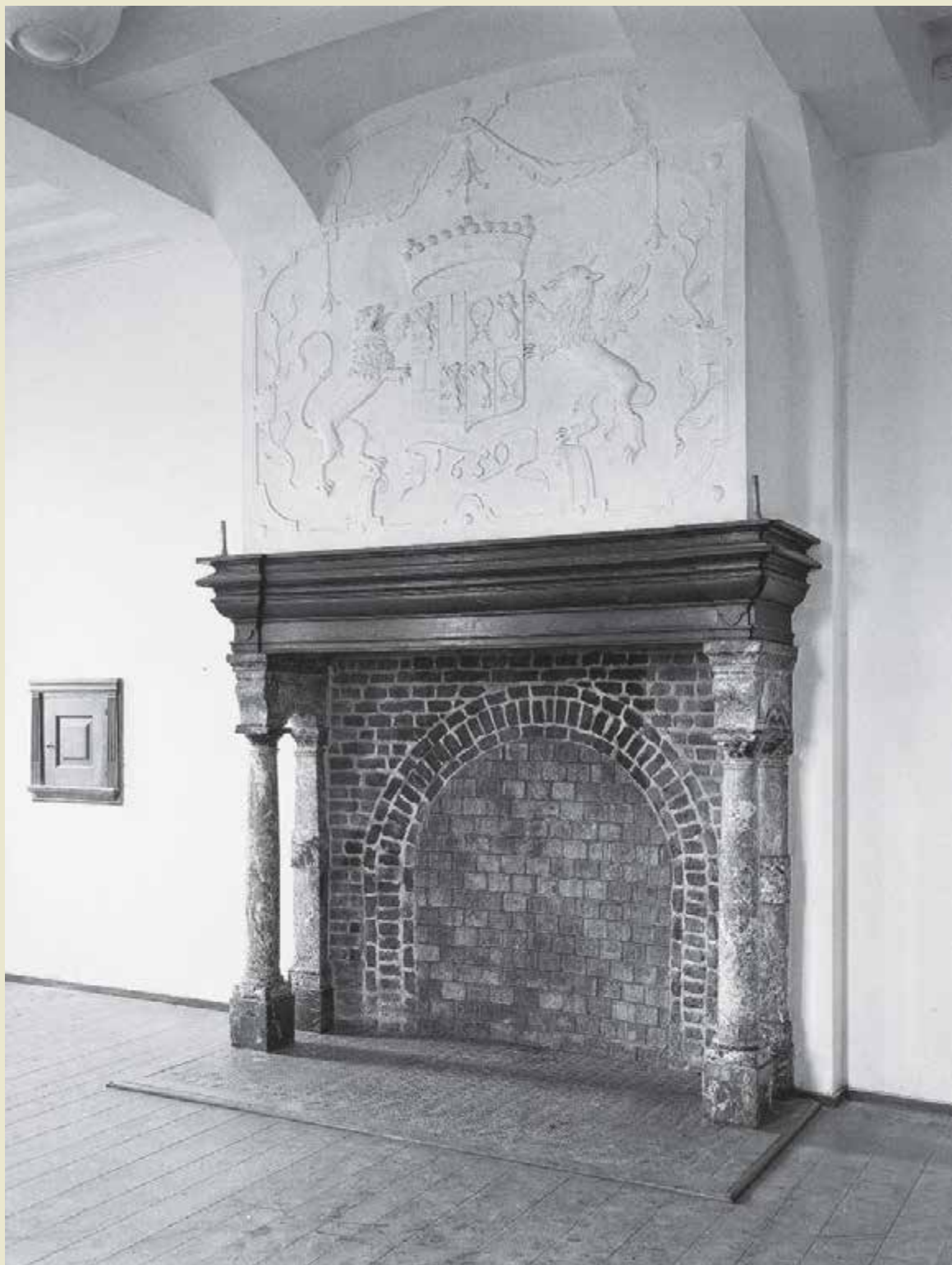
Hoensbroek, Kasteel Hoensbroek. Schouw met gestuukte schoorsteenboezem in het Groot Salet, gedecoreerd met het alliantiewapen van Adriaan Vrijheer van Hoensbroek (1590-1675) en zijn echtgenote Anne Isabelle de Loë (overleden 1632), gedateerd 1650 (foto RCE 1957)
