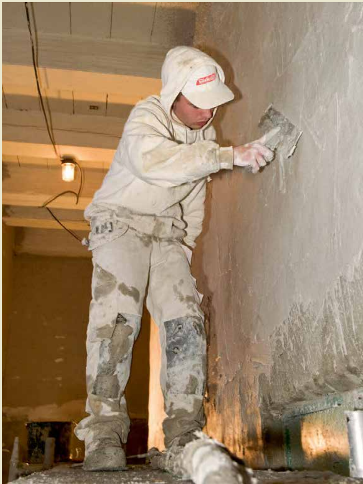
Zwolle, Huis van Bewaring. Herstel van het stucwerk in de gang op de begane grond (foto RCE 2008)
