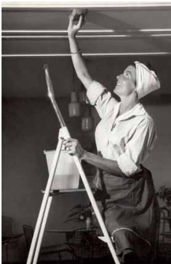
5. Goed bedoeld maar ondeskundig reinigen van geschilderde afwerk-lagen kan tot schade leiden. Opname uit de jaren vijftig (Spaarnestad Fotoarchief, W. Blum)
