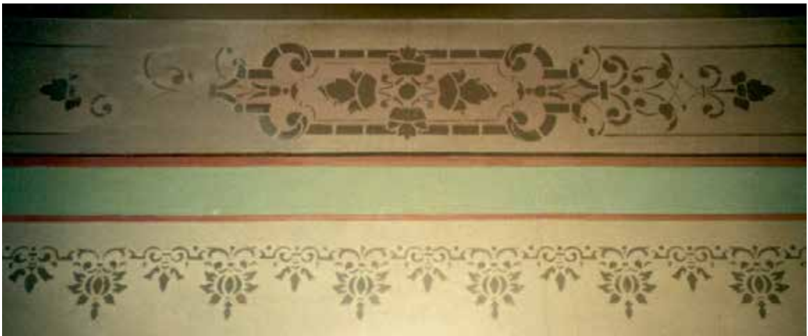
6. Gesjabloneerde randversiering in een van de kamers en suite in het herenhuis Brinkhorst (foto auteur)
