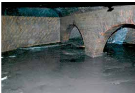
7. De ovale waterkelder van Paviljoen Welgelegen in Haarlem vanuit het westen, de centrale arcade ondersteunt twee gedrukte tongewelven (De Fabryck – Bureau voor Gebouwhistorisch Onderzoek)
