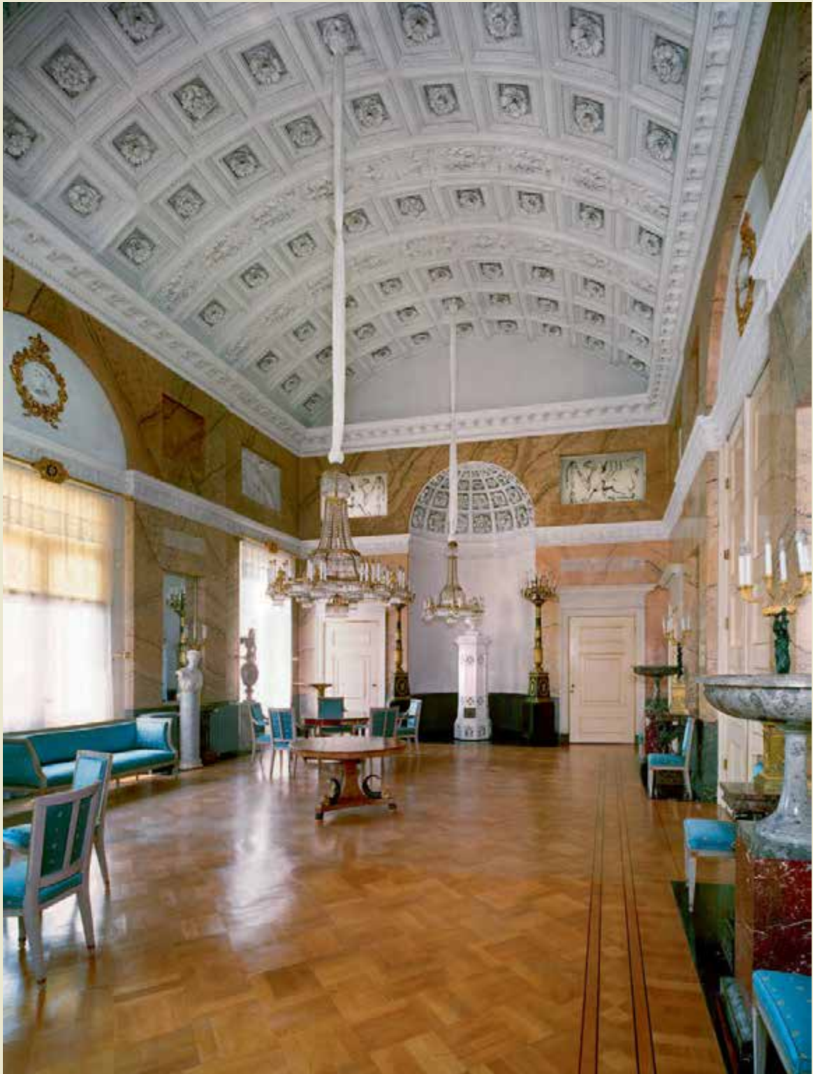
Soestdijk, Paleis Soestdijk. De Stuczaal met gebogen plafond met cassetten, waarvan de wanden zijn bekleed met stucmarmor, 1815-1821 (foto RCE 2006)
