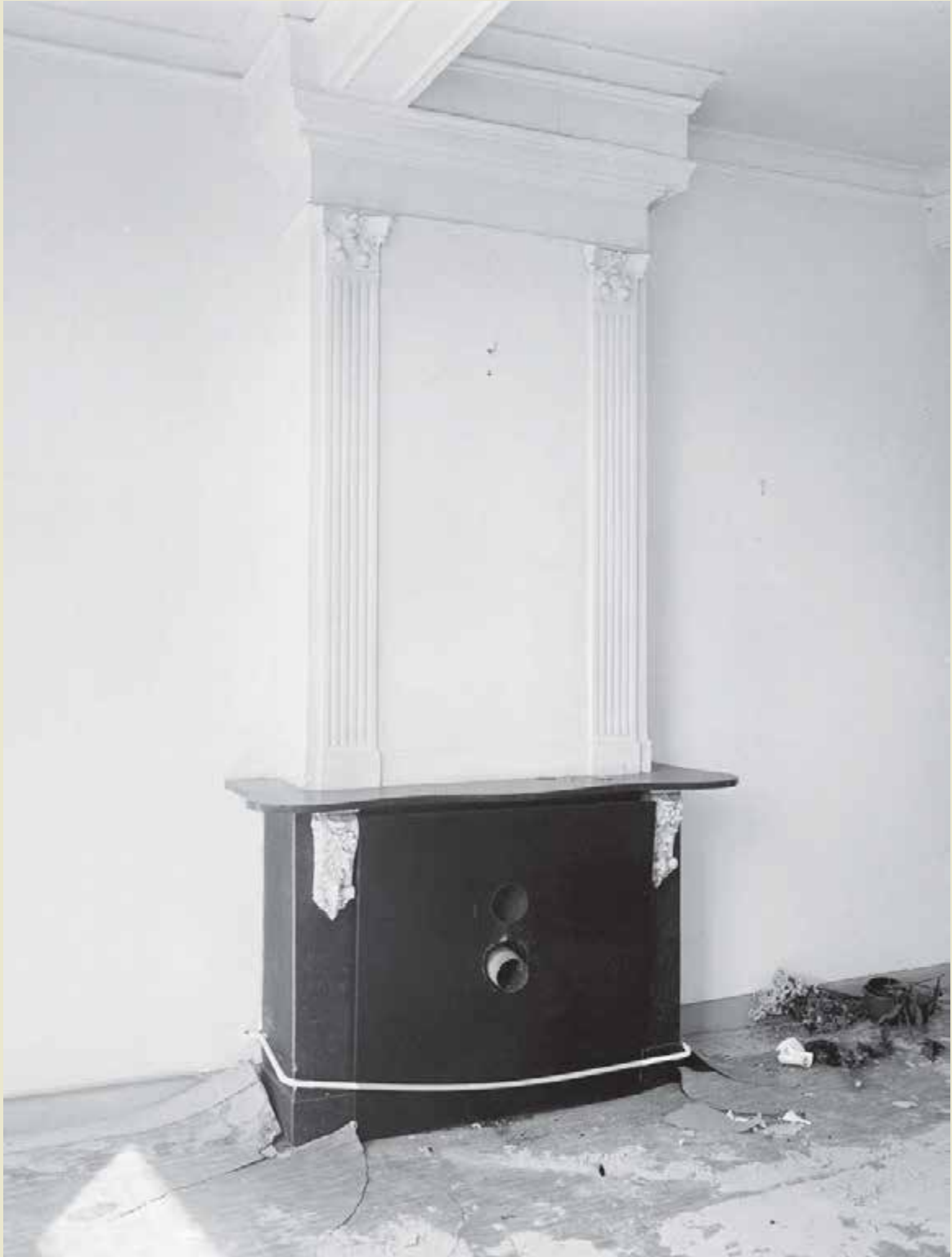
Leiden, Nieuwe Rijn 76. Negentiende-eeuwse schouwpartij met een eenvoudig gestuukte schoorsteenboezem met twee pilasters (foto RCE 1989)
