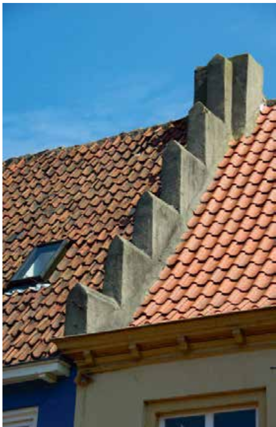
3. Laatmiddeleeuwse tussengevel voorzien van cementpleister Ooipootstraat 15 te Doesburg (foto auteur)
