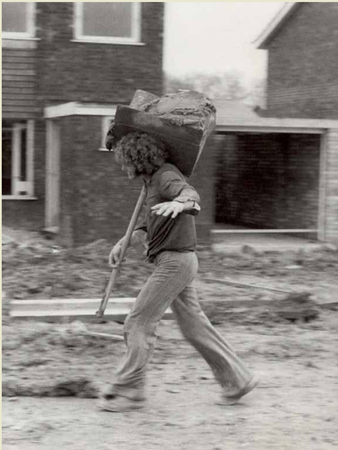
Stukadoor met een 'vrachtje' pleistermortel (Spaarnestad Fotoarchief 1975)
