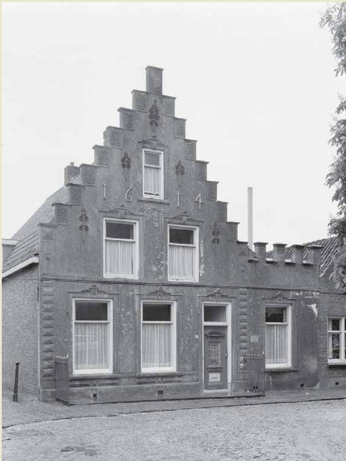
Groede, Markt 20. Gecementeerde trapgevel met sierankers die het jaartal 1614 aangeven (foto RCE 1967)
