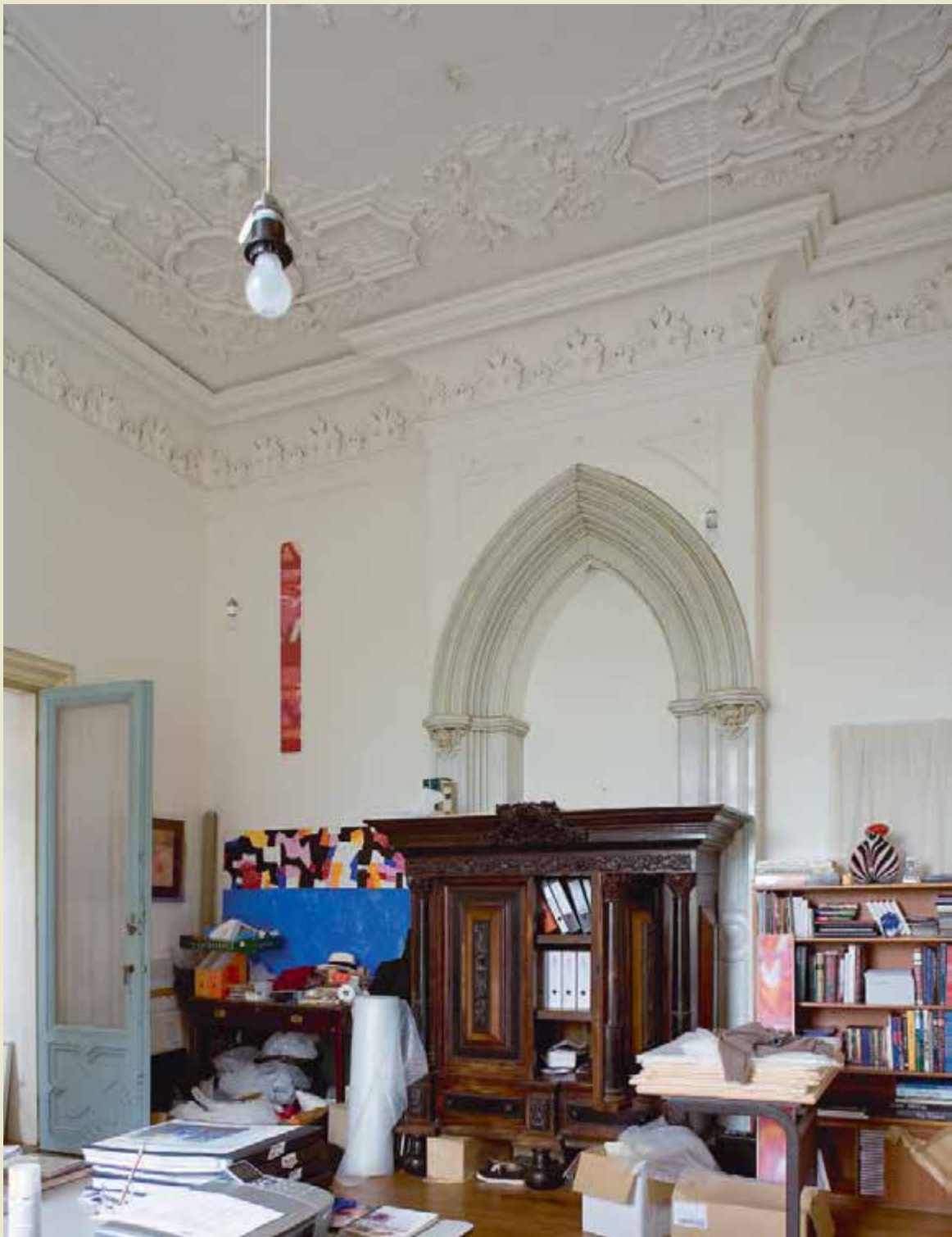
Werkhoven, Kasteel Beverweert. Interieur, bel-etage, overzicht zaal zuidoost hoek, gezien naar het noorden met stucwerk plafond met kooflijst, geornamenteerd middengedeelte, spitsboogvormige nis en schouw, midden negentiende eeuw (foto RCE 2007)
