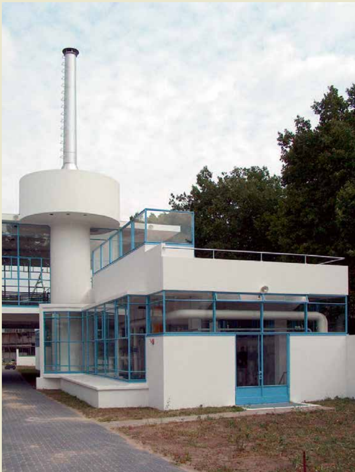
Hilversum, Zonnestraal. De stookruimte van het hoofdgebouw na restauratie en herstel van het oorspronkelijke kleurbeeld uit 1928 (foto RCE, T. Hermans 2003)
