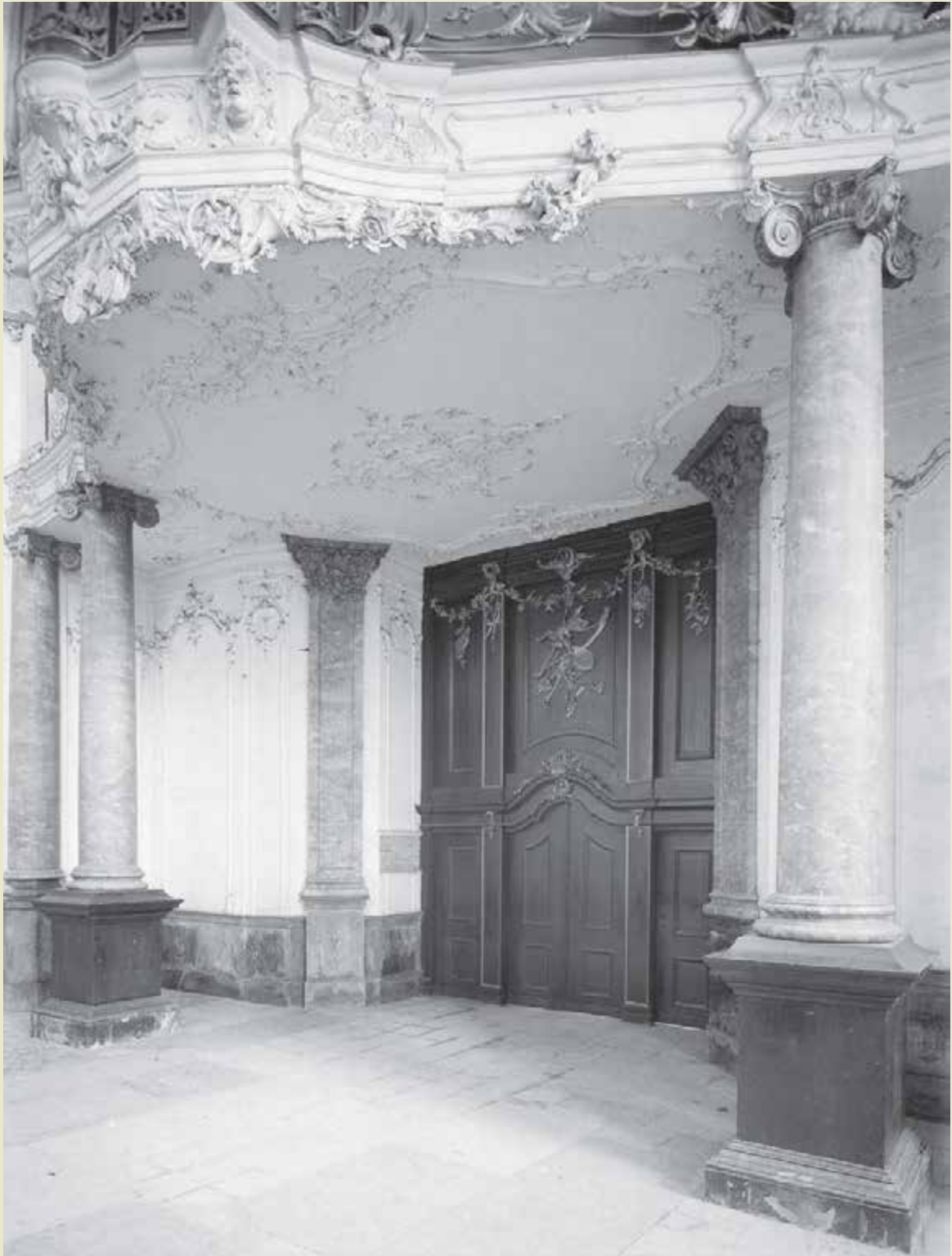
Dordrecht, Grote Kerk. Stucwerk aan de onderzijde van het orgelbalkon, uitgevoerd door de Italiaanse stucwerker Castelli, 1763 (foto RCE 1925)
